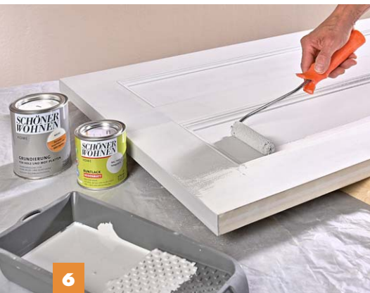
6 Tür entstauben und mit Acryl-Lack im gewünschten Farbton je zweimal streichen. Dabei Zwischenschliff nicht vergessen!
