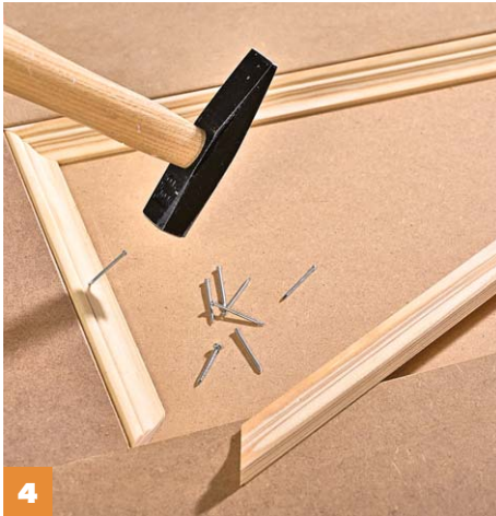
4 Leisten für die Kassetten auf Gehrung sägen, diese in die Innenseiten der Kassetten legen, mit Stauchkopfnägeln fixieren.
