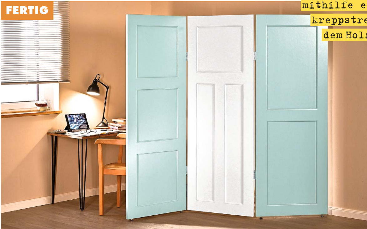
6 Tür entstauben und mit Acryl-Lack im gewünschten Farbton je zweimal streichen. Dabei Zwischenschliff nicht vergessen!
