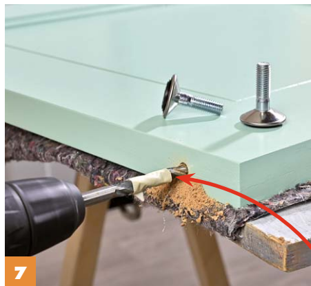
7 In die äußeren Türen mit 10 mm-Holzbohrer 40 cm tiefe Löcher bohren. Stellschrauben einschrauben, auf eine Höhe stellen.
