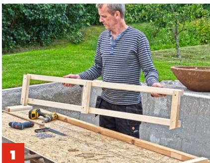
1 Zweimal Giebel aus jeweils zwei Trägerleisten mit 143,5 cm Länge und drei Zwischenstreben mit 25 cm Höhe bauen. **Giebel verkleiden und auf Standleisten (84,5 cm) montieren.**
