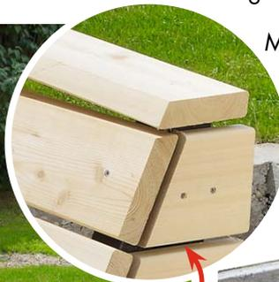
Mit einer Kreissäge das **oberste Deckbrett** auf 22,5° Gehrung zusägen
