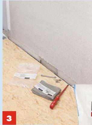
**3** Ein **Metall-Ableitgitter** im Putz sorgt für die nötige Erdung.
