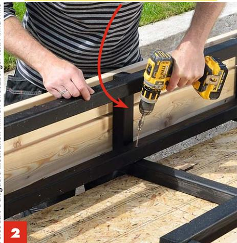
Wichtig: Die Zwischenstreben der Giebel zeigen nach außen. Danach **Endbretter** (90 cm) lot- und winkelrecht befestigen. Als Tipp, damit das **Holz nicht reißt**: die Schraublöcher stets vorbohren.
