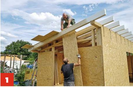
**1** Das Verlegen der OSB-Platten beginnen Sie **am unteren Ende des Daches** (Traufe). Die Federn der Platten zeigen nach oben.
