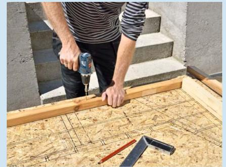
Als Führungsschiene Stützplatten unterhalb und seitlich der aufgezeichneten Giebelstreben auf die Platte bohren
