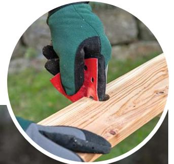
Anschließend die ganze Aussparung mit dem Schleifpapier sauber abschleifen
