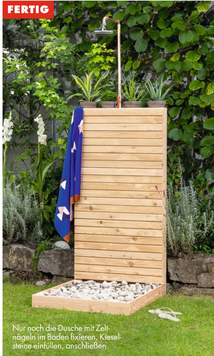
Nur noch die Dusche mit Zelt-nägeln im Boden fixieren, Kieselsteine einfüllen, anschließen
