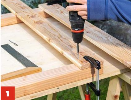
**1** Die beiden **Holzbretter B** im rechten Winkel von außen **an das Kantholz E** schrauben. Diese L-Konstruktionen ergeben die Seiten der Dusche.
