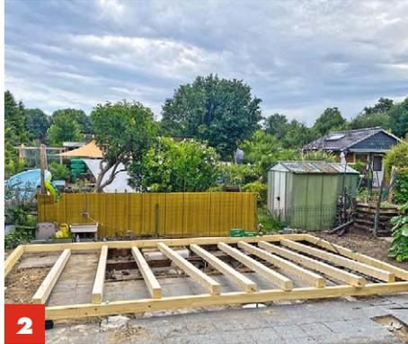
**2** Das Abstandsraaster der Bodenhölzer richtet sich nach der Breite der EPS-Dämmung (50 cm). Das spart Zuschnittarbeit.
