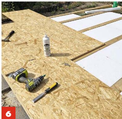
**6** Platten auf dem Rahmen verschrauben, kurze Kanten leimen, am Ende die Platten besäumen.
