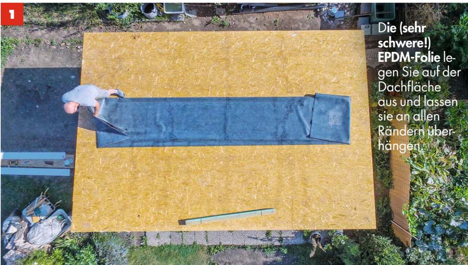
**1** Die (sehr schwere!) EPDM-Folie legen Sie auf der Dachfläche aus und lassen sie an allen Rändern überhängen.
