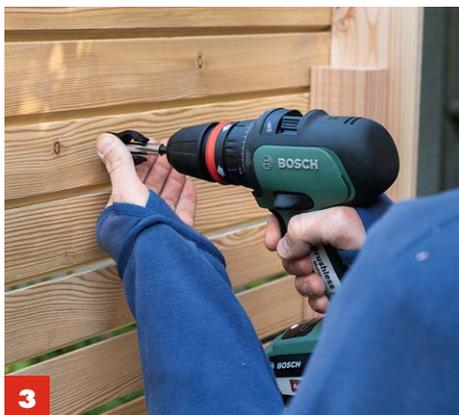
**3** An der Rückwand von hinten auf der dritten Latte von oben und unten die Mitte markieren, Klemmschellen anschrauben.
