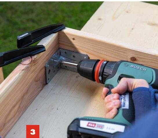
**3** Anschließend das vordere Holzbrett A mithilfe zweier Winkelverbinder und der kleineren Schrauben daran befestigen.
