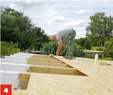
**4** Schrauben **sofort nach dem Verleimen setzen**, um die Lage zu sichern. Drei Schrauben pro Sparren reichen.
