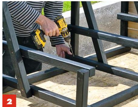
**2** Die gestrichenen Außengiebel **nach Vorbild der Liege verkleiden** und auf die Standleisten (194,5 cm) schrauben. Im Anschluss die beiden Mittelgiebel in gleichmäßigem Abstand **montieren**.
