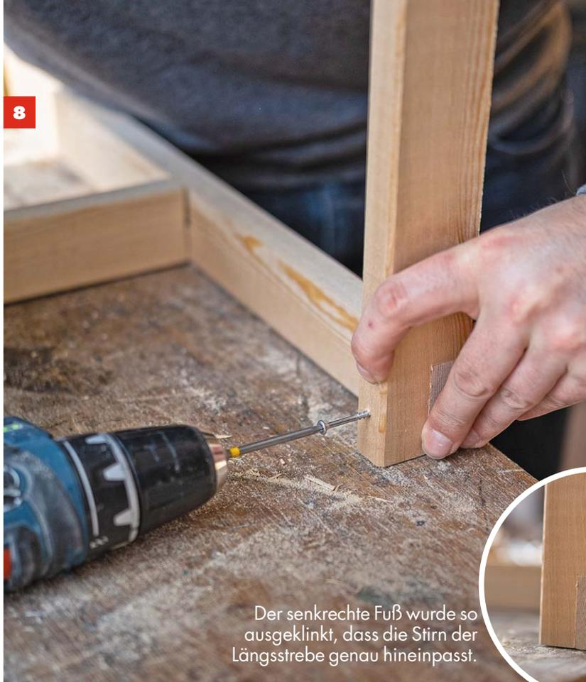
Der senkrechte Fuß wurde so ausgeklinkt, dass die Stirn der Längsstrebe genau hineinpasst.
