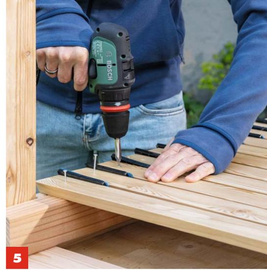
**5** An diese Rückwand kommen nun **23 Rhombusleisten**. Die erste Leiste bündig an das Gestell schrauben, alle weiteren mit einem **0,4-cm-Abstand**. Dafür Abstandshalter verwenden!
