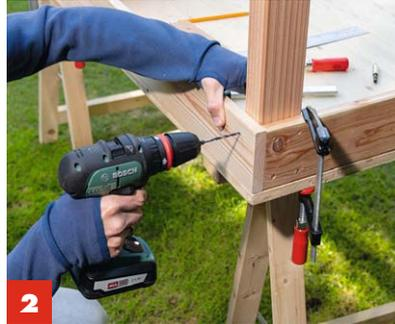
**2** Mit den größeren Schrauben das **Bauteil A** von hinten **bündig an die U-Konstruktion** montieren.
