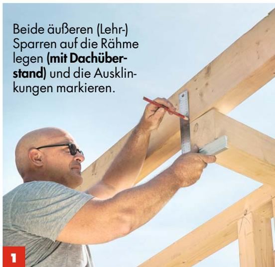
Beide äußeren (Lehr-) Sparren auf die Rähme legen (**mit Dachüberstand**) und die Ausklinkungen markieren.
