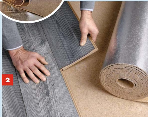
**2** *Silver Line* dient zudem als **dampfbremsende Trittschalldämmung** unter Bodenbelägen.
