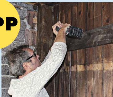
Bevor man den Ausschnitt für das Fenster macht, sollte man den **Bereich knapp darüber und darunter mit quer verlaufenden Brettern verstärken**. So verhindert man, dass die Bretterverkleidung des Schuppens später lose umherschlackert. Bei der seitlichen Ausrichtung des Fensters sollte man den Ausschnitt so setzen, dass **links und rechts noch ein Teil der Bretter übersteht**, sodass das Fenster später stabil sitzt.
