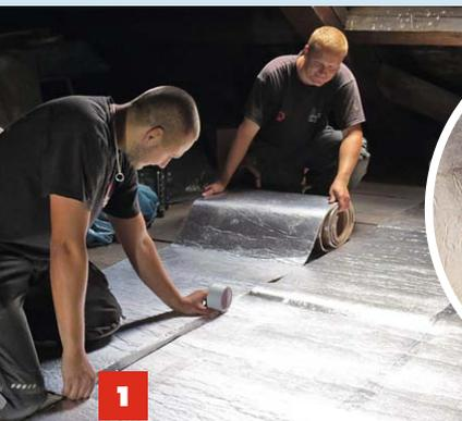
**1** Für eine lückenlose Dämpfung muss man die Stöße der Dämmplatten **mit Alu-Klebeband abkleben**.
