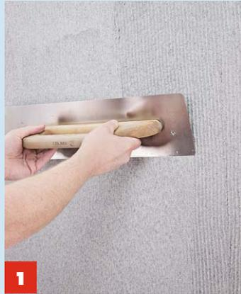
**1** Der Putz wird **per Zahnkelle** in einer Richtung aufgezogen, danach geglättet.
