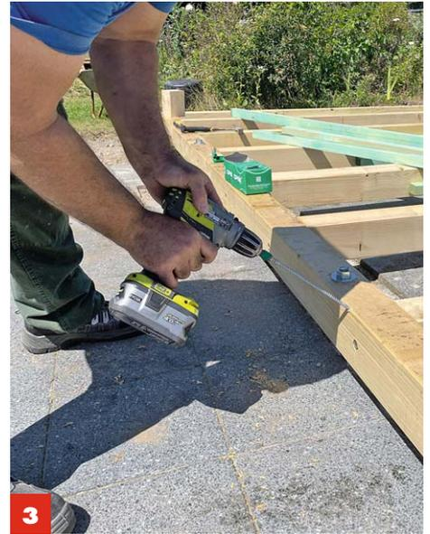
**3** Die Rahmenhölzer werden mit jeweils einer Tellerkopfschraube und zwei schrägen Vollgewindeschrauben verbunden.
