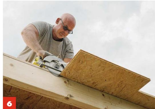
**6** Die Platten lassen Sie **an den Rändern zu-nächst überstehen**, um sie ganz am Ende mit der Handkreissäge abzuschneiden.
