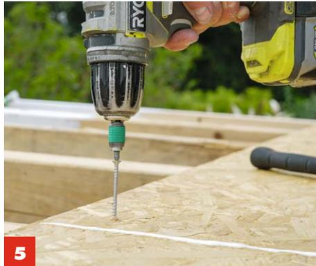
**5** Hier kommen **spezielle Verlegeschrauben** zum Einsatz. Sie fixieren die Platten auch bei starkem Arbeiten des Holzes.
