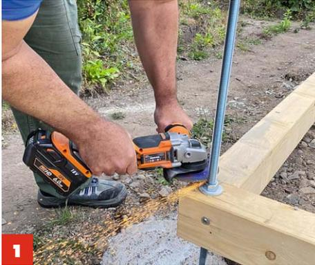
**1** Die einbetonierten Gewindestangen flecken Sie nach dem Ausrichten des Bodenrahmens bündig mit der Mutter ab.
