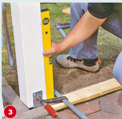
Hat der Beton abgebinden, Pfosten per Wasserwaage ausrichten und mit einer Schraubzwinge fixieren.
