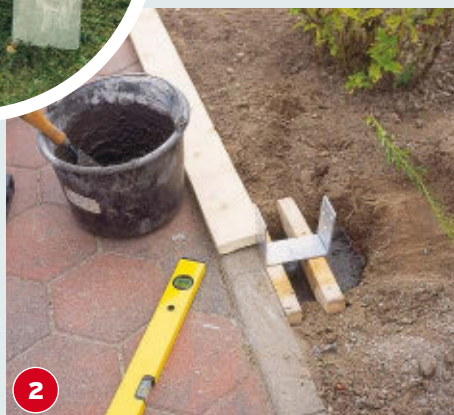
Den Pfostenschuh mit kleinen Hölzchen in Position bringen, fixieren und dann das Loch mit der Betonmischung füllen.
