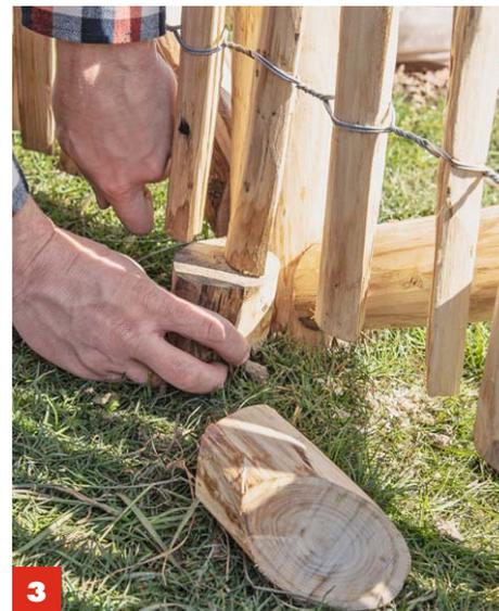
**3** Für die Höhenpositionierung der Staketen hilft ein Verschnittstück, das vom Anpassen der Verstreibungen übrig blieb.
