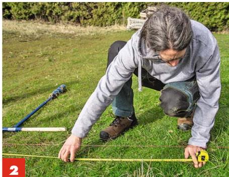
**2** **Spätestens alle 1,6 m** sollte ein Pfosten stehen. Die Geraden des Zauns werden gleichmäßig aufgeteilt.
