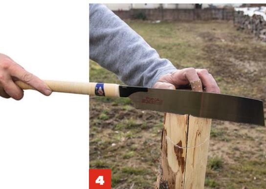
**4** Nehmen Sie die Verstrebung ab und sägen Sie per Augenmaß einen Keil aus dem Pfosten.
