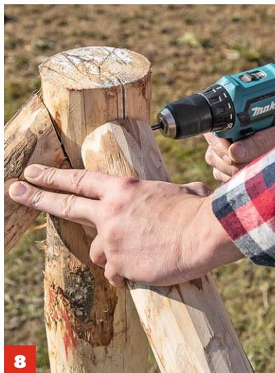
**8** Wenn alles formschlüssig passt, wird mit einem Holzbohrer quer durch den Pfosten vorgebohrt.
