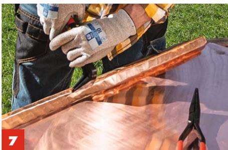
**7** Mit der gekrümmten Spenglerzange wird nun die Traufkante angefalzt und in mehreren Durchgängen umgebogen.
