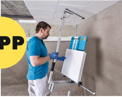
Für EPS-Platten gibt es spezielle Styropor-Schneidgeräte, die Sie im Fachhandel mieten können. Damit gelingen Ihnen die so wichtigen dichten Plattenfugen und alle Arten von Aussparungen millimetergenau. Bei großen Deckenflächen lohnt sich das Gerät.
