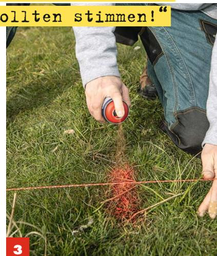
**3** Wenn die **Positionen der Pfosten** feststehen, werden sie mit **Farbspray** markiert.
