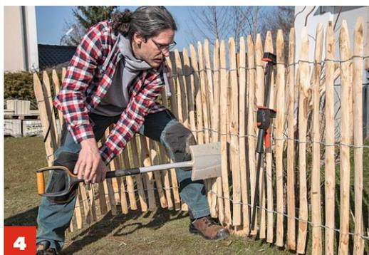
**4** Ein solider Spaten wird zwischen Stakete und Pfosten geklemmt – dank des langen Hebels lässt sich das Staketenelement dehnen.
