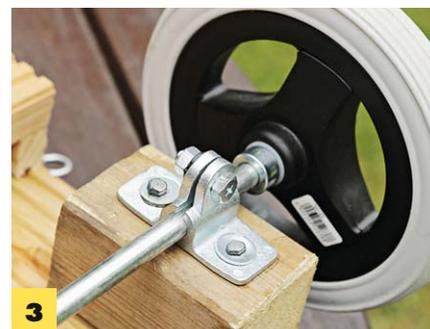
**3** Das Fahrgestell an der Unterseite des Bodens montieren. Die Kanthölzer tragen die Auflageböcke **für die Achse**.
