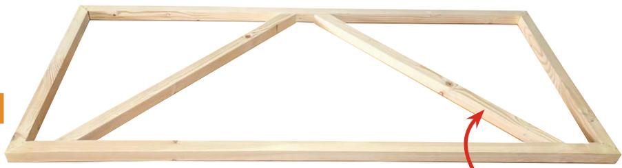
Diese **diagonalen Latten** wurden auf Gehrung gesägt und eingesetzt
