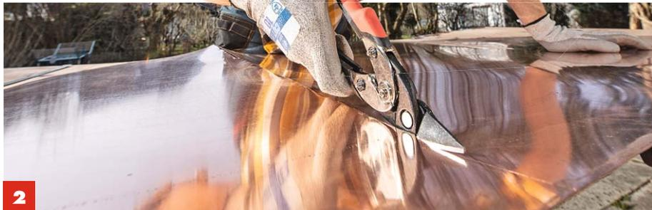
**2** Reißen Sie mit der Nadel an und schneiden Sie das Blechstück ab. Tragen Sie schnittfeste Handschuhe und drücken Sie die Schere nie komplett zu!
