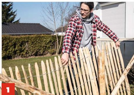
**1** Zuerst werden die Staketen aufgerollt und provisorisch mit kurzen Drahtschlingen an die Pfosten geheftet.
