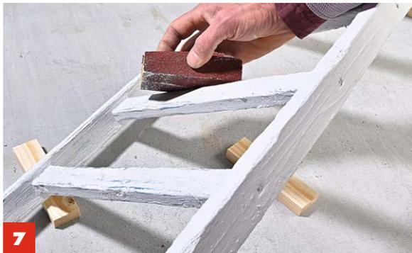
Ein **Anschliff** mit 80er-Körnung macht die untere Farbschicht sichtbar. Mit 120er-Papier nachschleifen – das verleiht einen rustikalen Charme.
