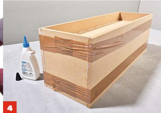
**4** Das Klebeband fixieren. Herausquellenden Leim mit einem **feuchten Lappen** abwischen. 30 Minuten trocknen lassen.
