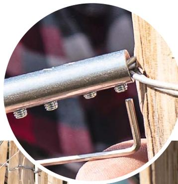
Die Schraubhülsen bilden **nicht die stabilste Verbindung** und sollten zusätzlich gesichert werden.
