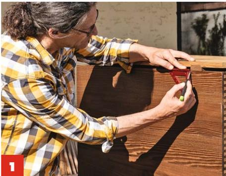
**1** Markieren Sie die Aussparung **mit 1 mm Luft zum Keil** und rechnen Sie bei der Tiefe die Stärke des Scharniers ein.
