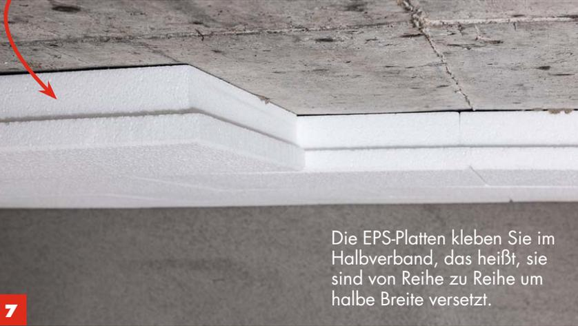
Die EPS-Platten kleben Sie im Halverband, das heißt, sie sind von Reihe zu Reihe um halbe Breite versetzt.
