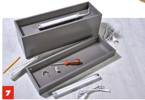
**7** Die Pflanzenlampe mittig auf der Unterseite des oberen und des mittleren Kastens **montieren**. Danach das Netzkabel verlegen.
