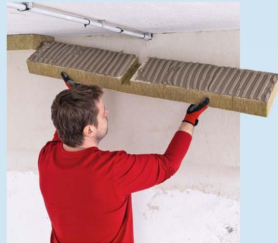
... bevor Sie ihn mit der 12er-Zahnkelle aufkämmen. Die Kelle für eine ausreichende Klebermenge möglichst steil abziehen.
