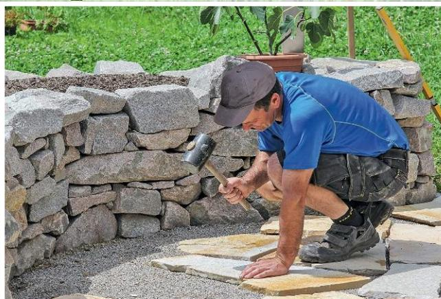
Im Gegensatz zu Pflastersteinen werden Trittsteine **ebenerdig im Rasen verlegt und angeklopft**. So kann man später gut Rasen mähen und stolpert nicht
