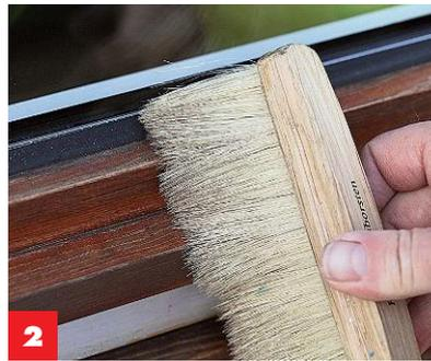
2 Entfernen Sie den **Schleifstaub** mit einer feinen Bürste vom Fensterrahmen und aus allen Ritzen.
