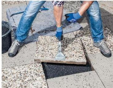
**REPARIEREN** Kaputte Fliesen tauschen Sie aus, fixieren sie hohlraumfrei mit Fliesenkleber und verfugen sie. Abgesackte Terrassenplatten lassen sich mit ein wenig Splitt rasch ausgleichen
