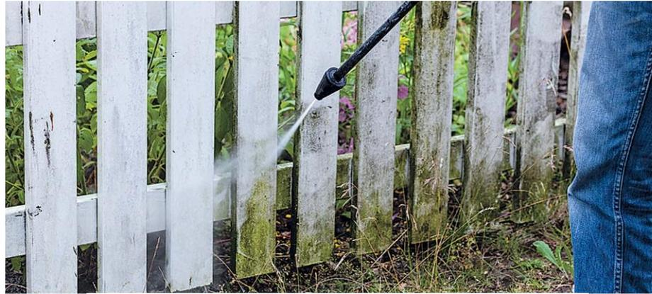
**REINIGUNG** mit dem Hochdruckreiniger oder einer Bürste: Hierbei kommen alle verdeckten Schäden zum Vorschein
