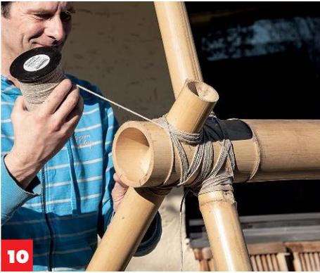
**10** Mit einer **4-mm-Hanf**kordel werden nun Beine und Querrohr straff umwickelt. Das Wickelmuster ist frei wählbar.
