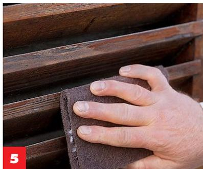
5 Montieren Sie zum Schleifen die **Fensterläden** ab. So kommen Sie leichter in die Zwischenräume.
