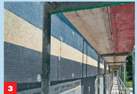
**3** Bei Polystyrol-Dämmung sind **Brandriegel aus Steinwolle** oberhalb der Fenster nötig, um einen Brandüberschlag zu verhindern.
