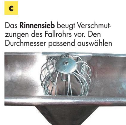
Das Rinnensieb beugt Verschmutzungen des Fallrohrs vor. Den Durchmesser passend auswählen
