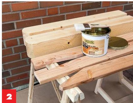
**2** Das Holz für die neuen Riegel über die alten legen und die **Ausschnitte für die Überlappungen** anzeichnen.
