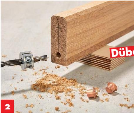
**2** Die Position für die **Dübellöcher** an der Mittelstrebe markieren und mit einem 10-mm-Holzbohrer mit Tiefenstopp bohren.
