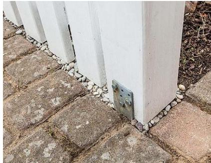
Den Boden unter den Latten mit Kies aufüllen. Es führt Wasser ins Erdreich ab
