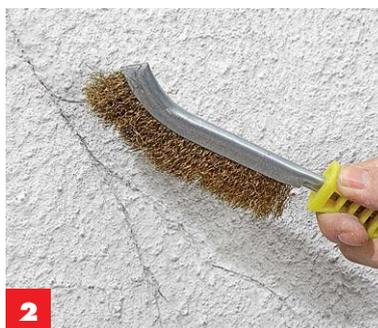
**2** **Bürsten Sie** den Riss gut mit einer Drahtbürste aus, um auch hier alle losen Putzteile zu entfernen.
