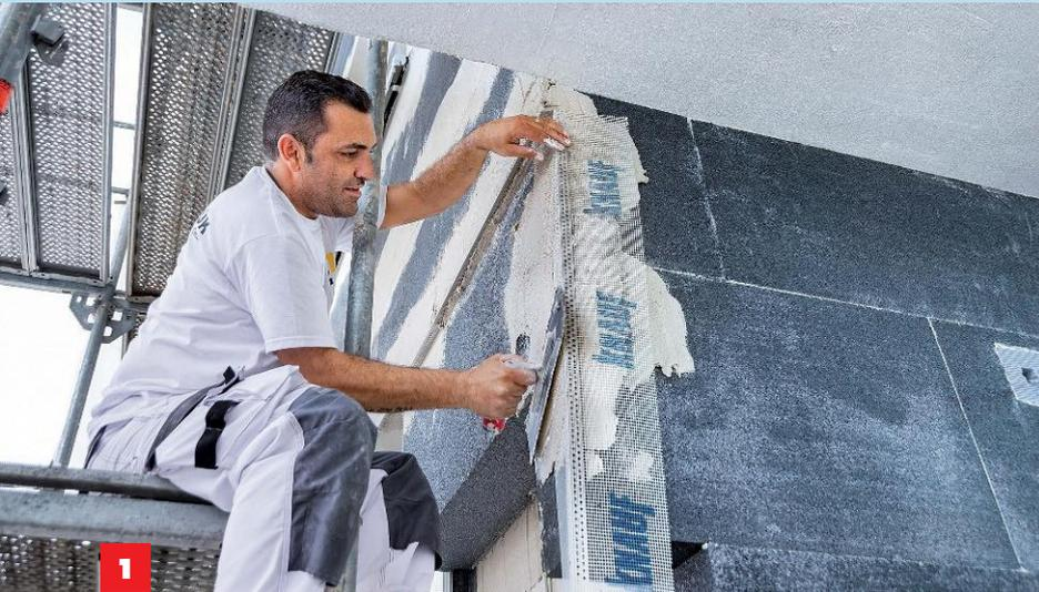
**1** Der nur **wenige Millimeter dicke Putz** muss in der Fläche und an allen Ecken armiert werden, damit er nicht reißt.
