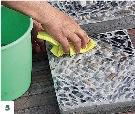
**5** Mit **dünnflüssigem Mörtel ausgießen.** Nach mehreren Tagen Trocknen die Platte stürzen. Mörtelreste mit Schwamm lösen.
