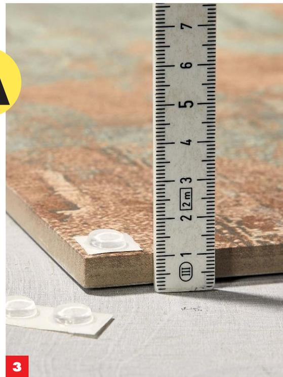
**3** Fliese mit **Gummipuffer** ausmessen. Von der Höhe der Stirnseite abgezogen, ergibt sich die Längsseitenhöhe.
