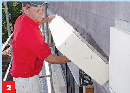
**2** Das **Verkleben der Dämmplatten** erfolgt im Punkt-Wulstverfahren, um Hohlstellen hinter den Platten zu vermeiden.
