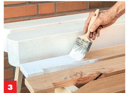
**3** Die zugeschnittenen und bearbeiteten Hölzer mit **Nadelholz-Imprägnierung** und mit Holzschutzfarbe streichen.
