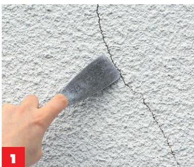
**1** Lockere, **grobe Putzteile** rings um den Riss lösen Sie am besten mit einem geeigneten Spachtel ab.
