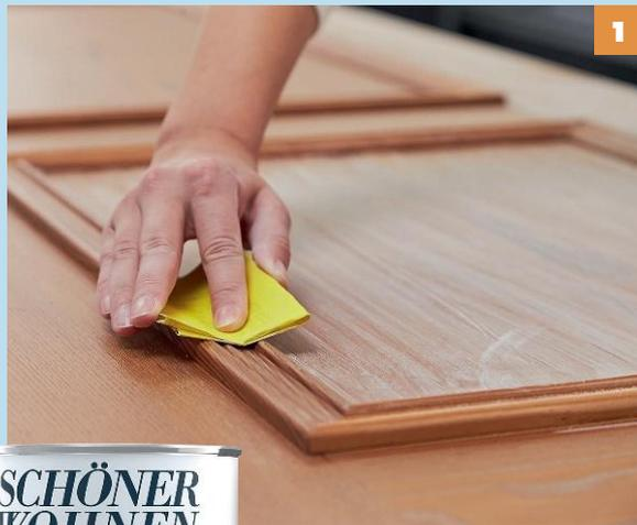
**1** Türblatt aushängen, auf zwei Böcken lagern, Türgriffe und Dichtungen entfernen. Neues Holz **anschleifen**, abblätternde Anstriche **abschleifen**.
