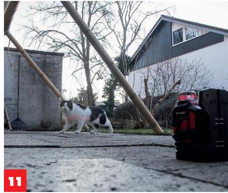
**11** Nun wird der Ständer **auf Endhöhe** gekürzt. Der **Linienlaser** hilft beim Markieren des zu kürzenden Bereichs.
