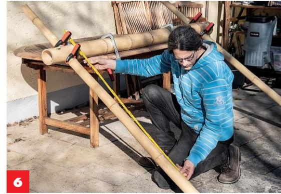
**6** Die Vorderbeine **durch das Querrohr führen** und ausrichten, dann provisorisch mit Zwingen fixieren.
