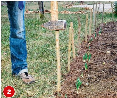
**2** Bei niedrigen Zäunen ggf. bis zu 1 m Höhe werden die Pflöcke eingeschlagen, bei höheren eingegraben.
