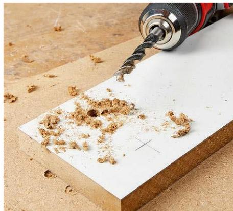
Saubere Durchgangsbohrungen: ein untergelegter Restzuschnitt verhindert das Ausreißen auf der Plattenunterseite
