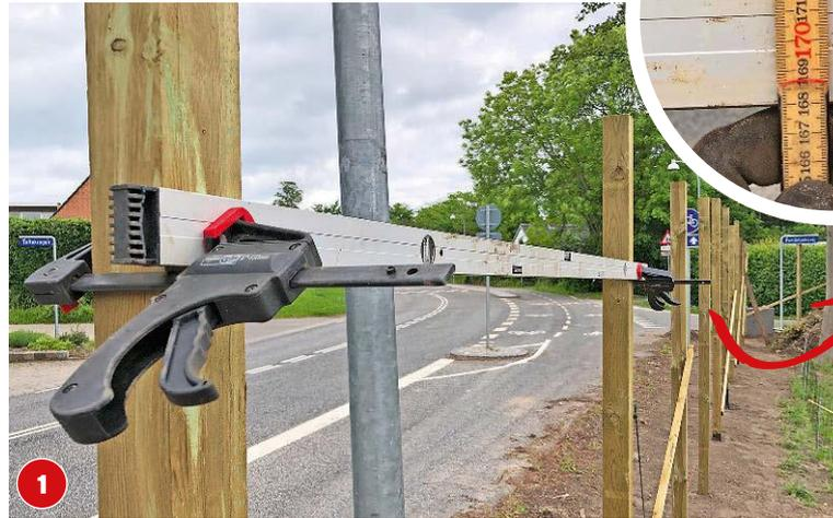
Messen sie 180 cm auf dem Pfosten (A) ab, der am tiefsten Punkt steht. Die 180 cm lange Wasserwaage an der Markierung anlegen und waagrecht am zweiten Pfosten fixieren.
