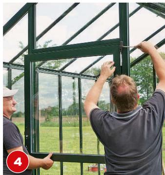
Die beiden Torflügel (oben und unten) setzt man auf die Scharnierhalterungen am Türrahmen.
