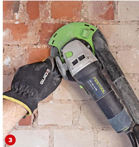
**3** Für hartnäckige Wandbeschichtungen: Fräse oder Winkelschleifer mit Diamantscheibe und Absaugung.
