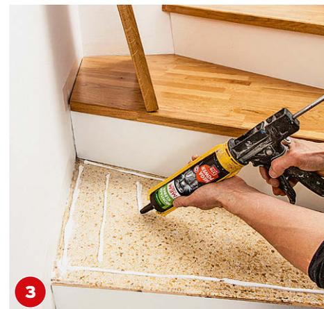
Zum Fixieren der Trittstufen wird auf den zuvor gereinigten Untergrund Montagekleber aufgetragen.
