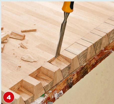
4 Nach dem Sägen wird der Verschnitt nach derselben Methode wie bei den Zinken ausgestemmt.
