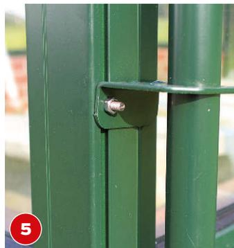
Die Fallrohre für das Dach-Regenwasser verschrauben Sie mit den beigelegten Halterungen am Gewächshaus.
