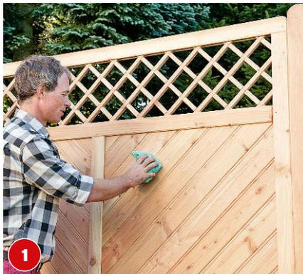
1 Das Holz leicht anschleifen und mit einem fusselfreien Tuch von Schleifstaub befreien.
