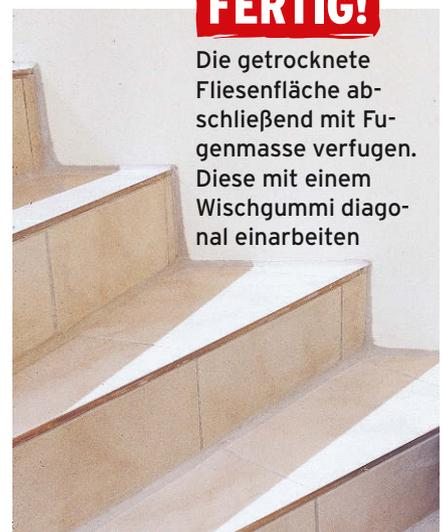
Die getrocknete Fliesenfläche abschließend mit Fugenmasse verfugen. Diese mit einem Wischgummi diagonal einarbeiten
