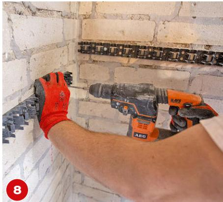
**8** Die Löcher für die Montage werden direkt durch die Klemmschienen in die Wand gebohrt.
