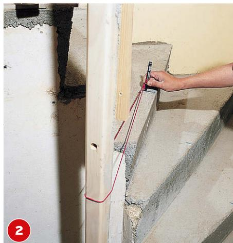
Für jede Stufe die Fliesen einzeln ausmessen. Mit Stift und Schnur die Mitte markieren und Fliesen daran ausrichten.
