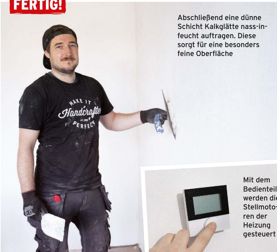
Abschließend eine dünne Schicht Kalkglätte nass-in-feucht auftragen. Diese sorgt für eine besonders feine Oberfläche
