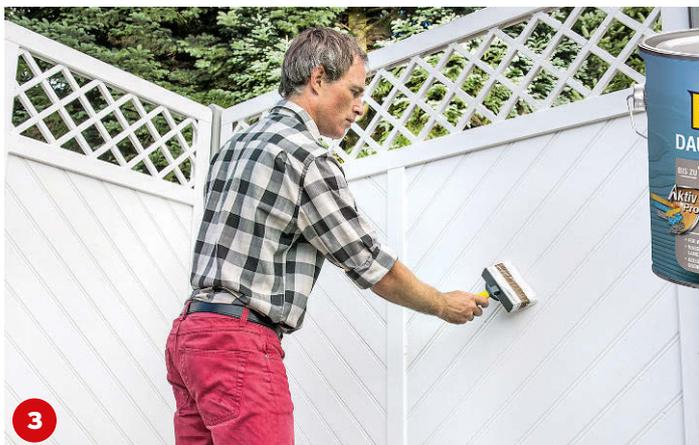
3 Anschließend kann die Dauerschutzfarbe aufgetragen werden. Nach einer Trocknungszeit von circa zwölf Stunden soll diese bis zu zwölf Jahre Schutz vor Wittereinflüssen gewähren.
