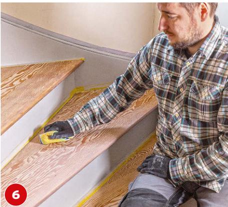
**6** Überschüssiges Öl nach 30 Minuten mit einem Lappen aufnehmen. Lappen luftdicht lagern. Entzündungsgefahr!
