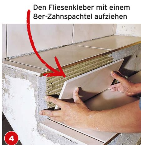
Ist der Kleber der Trittstufe getrocknet, folgt die Setzstufe. Auch hier ausmessen, zuschneiden und einsetzen.
