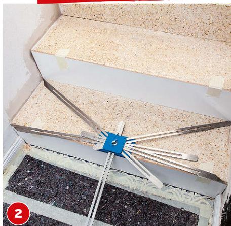
Mithilfe der Treppenspinne messen Sie die einzelnen Trittstufen aus und können das Maß direkt auf das Holz übertragen.
