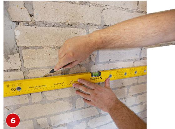
**6** Markieren Sie die Oberkante der Klemmschienen mit Hilfe einer Wasserwaage. Das erleichtert später das Anbringen.
