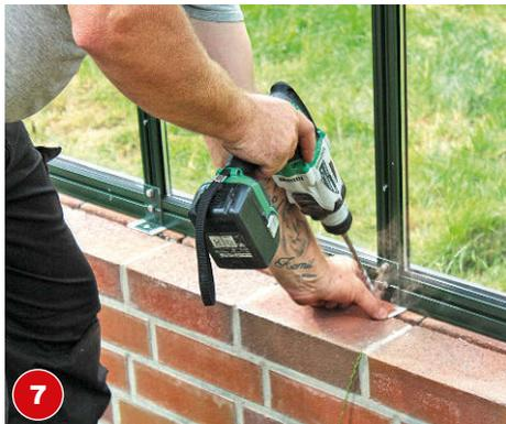
Abschließend wird die Gewächshauskonstruktion im Innern über Befestigungsschrauben mit dem Mauerwerk verschraubt.
