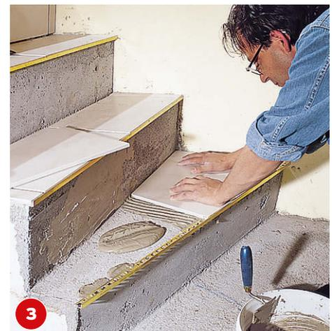
Fliesen zuschneiden und die Schnittkanten brechen. Fliesenkleber und Kantenenschutz aufbringen und die Fliesen legen.
