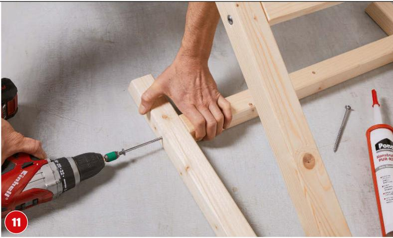
Beide Querlaten mit einer 6-x-100-mm-Tellerkopfschraube und PU-Leim mit den Beinen verbinden.
