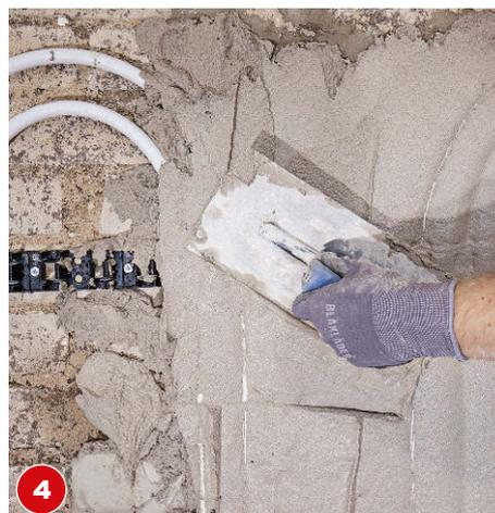
4 Den Putz flächig auf das Niveau der Rohre auftragen. Überstehenden Putz glatt mit einer Kelle oder Rake abziehen.
