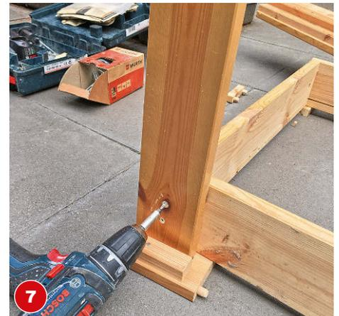
**7** Die zugesägten Stützen dort vorbohren, wo sie mit dem Bettkasten verbunden werden sollen. Dicke Schrauben wählen.
