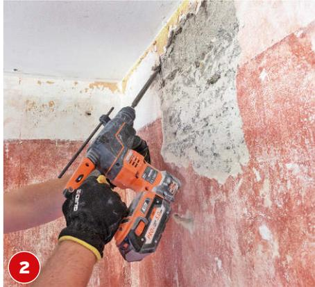
**2** Dort, wo der Putz nicht mehr tragfähig ist, entfernt man ihn am besten mit einem Bohrerhammer mit Flächenmeißel.
