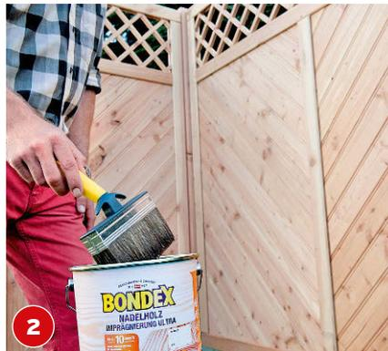
2 Die Nadelholz-Imprägnierung Plus von Bondex auftragen und sechs Stunden trocknen lassen.
