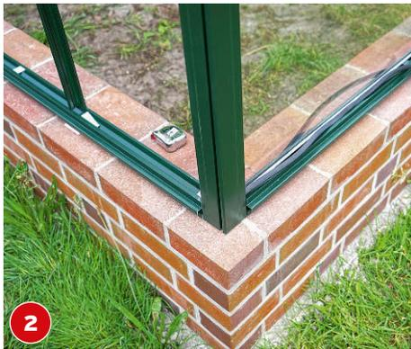
Vor dem Einbau weiterer Scheiben die Gummidichtungen im Firstbereich an den Ecken und im Bodenprofil eindrücken.
