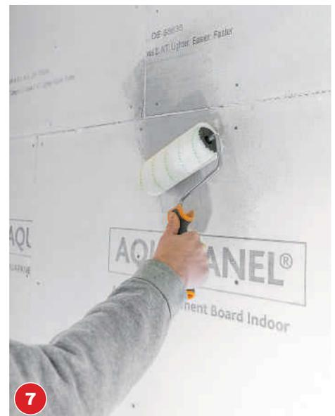
7 Nach zwölf Stunden Trocknungszeit den Fugenkleber von allen Elementen entfernen. Alle Beplankungen grundieren.
