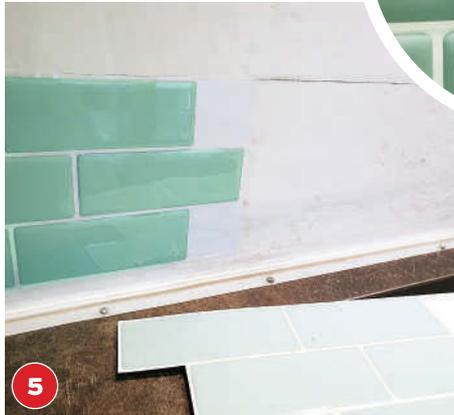
**5** Entlang einer mit der Wasserwaage gezogenen Hilfslinie kleben Sie die erste Fliesenreihe auf.
