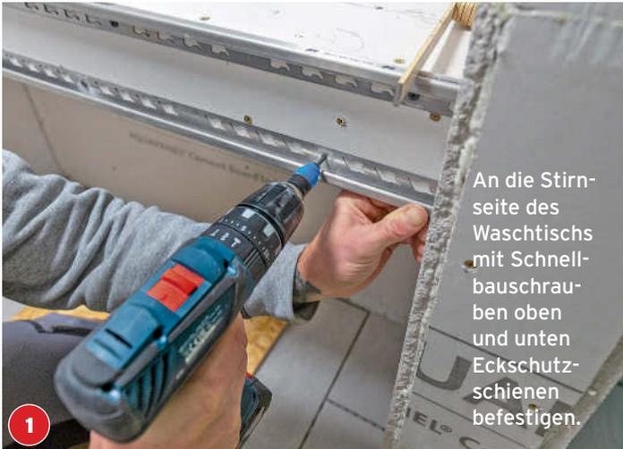
An die Stirnseite des Waschtischs mit Schnellbauschrauben oben und unten Eckschutzschienen befestigen.
