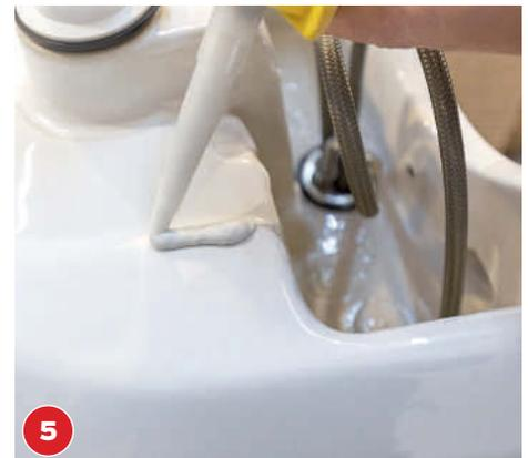
Auf die Auflageflächen an der Unterseite und an der hinteren Seite des Beckens ausreichend Sanitärsilikon auftragen.
