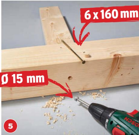
5 Mit dem Forstnerbohrer ein 3 cm tiefes Sackloch bohren. Dann das Tischbein mit dem Querbalken verschrauben.
