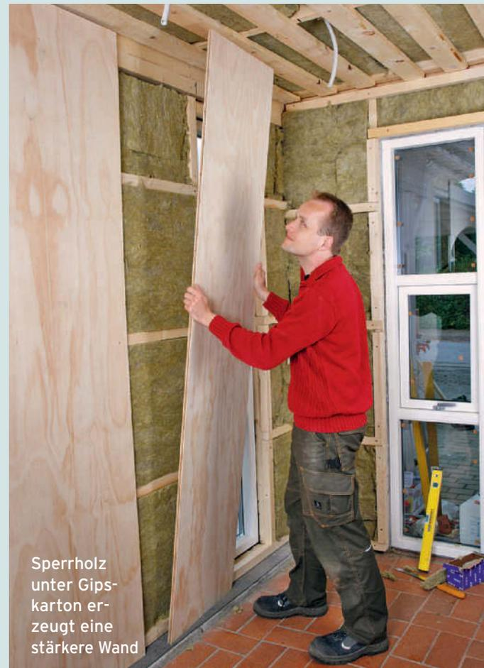
Sperrholz unter Gipskarton erzeugt eine stärkere Wand
