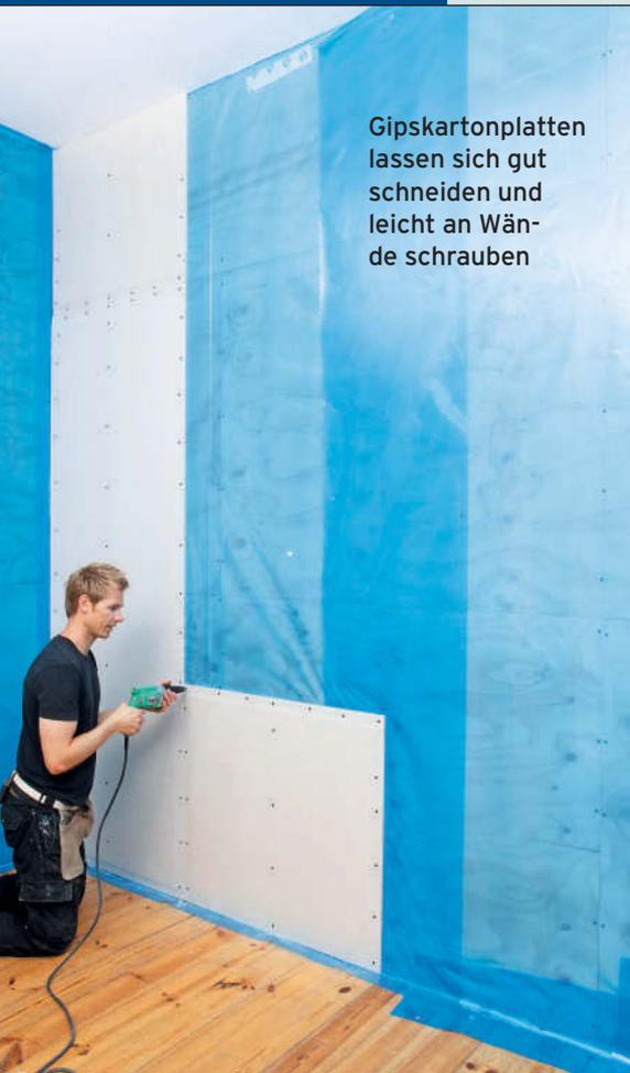
Gipskartonplatten lassen sich gut schneiden und leicht an Wände schrauben
