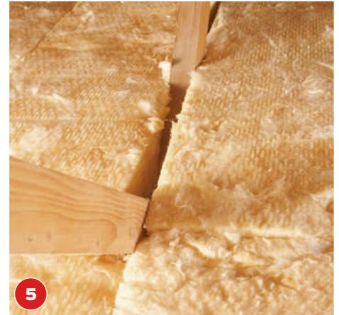
**5** Werden an solchen Stellen die Matten ohne Zuschnitt verlegt, füllt man die Fugen mit Granulat (siehe Kasten Seite 18).
