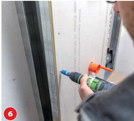
6 In regelmäßigen Abständen von 20 cm die Platten rundum mit Spezialschrauben am Ständerwerk fixieren.
