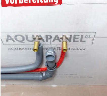
Starthilfe vom Fachmann: Der Klempner bereitet Wasseranschluss und Abwasserrohr vor
