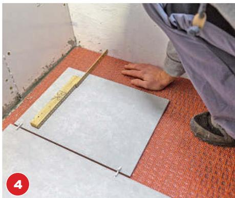
4 Wir starten mit dem Verlegen an der hinteren Wand und ermitteln die Breite des ersten Zuschnitts, sodass an der Tür eine ganze Fliese liegt.
