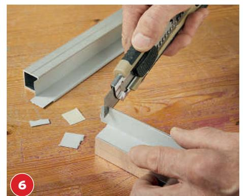
Ist der Umleimer und das Profil erkaltet, die Überstände mit einem Cuttermesser abschneiden.
