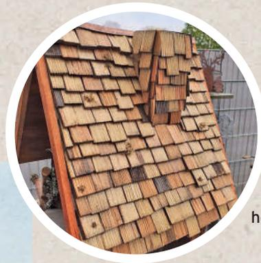
Hier kommt nichts in die Tonne: Das Dach hat Klaus Berres mit Resten aus Sperrholz eingedeckt
