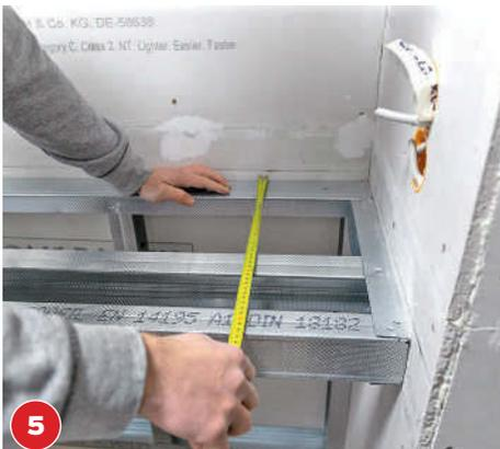
Waagrecht an der Wand die U-Profile fixieren, CW-Profile hochkant einschieben und verbinden. Auf Maßhaltigkeit prüfen.
