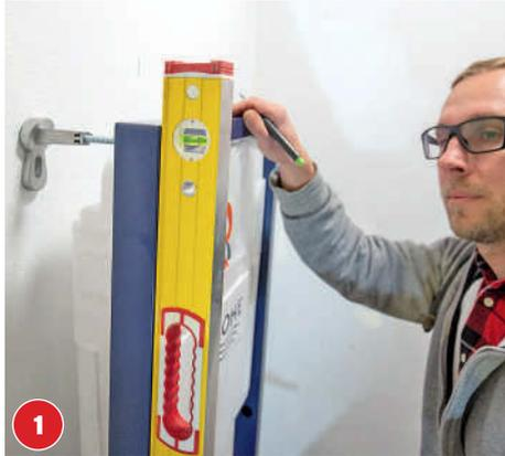
1 Bei der Montage des Unterputz-Spülkastens sollte man darauf achten, dass er exakt lot- und waagrecht ausgerichtet ist.
