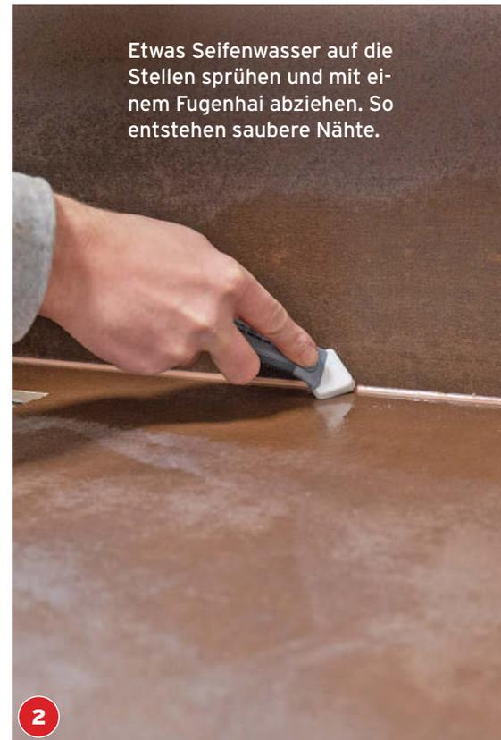
Etwas Seifenwasser auf die Stellen sprühen und mit einem Fugenhai abziehen. So entstehen saubere Nähte.
