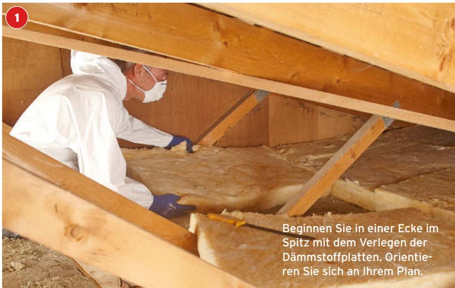
Beginnen Sie in einer Ecke im Spitz mit dem Verlegen der Dämmstoffplatten. Orientieren Sie sich an Ihrem Plan.
