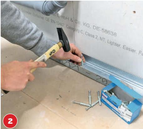
Zwei U-Profile am Boden befestigen. Mit Drehstiftdübeln von Knauf verankern Sie die Metallprofile sicher im Boden.
