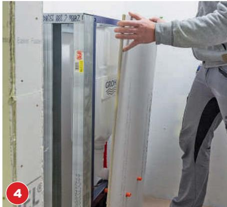
4 Anschlüsse und Gewinde mit Deckeln schützen. Mit Trockenbauprofilen und *Aquapanel* das Element verkleiden.
