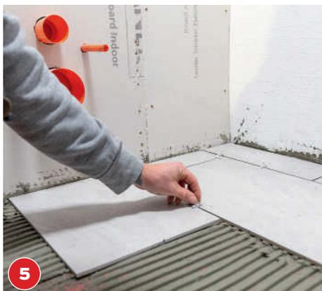
5 Entkopplungsvlies mit Flexkleber bestreichen, zugeschnittene Fliesen mit Fugenkreuzen ausrichten, andrücken.
