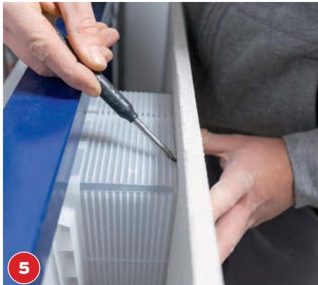
5 Auch der integrierte Spülkasten wird beplankt. Hierfür Ausschnitte anzeichnen, per Stichsäge zusägen und beplanken.
