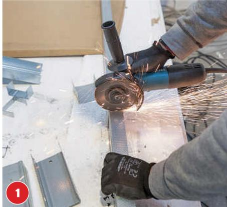
Nun die Trockenbauprofile ausmessen: Wir brauchen sechs U- und sechs CW-Profile. Mit Flex zuschneiden, entgraten.
