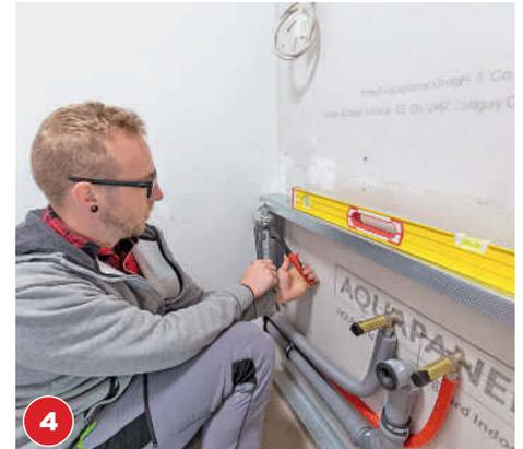
Die Profile mit der Profil-Verbundzange verbinden. So entsteht eine stabile Konstruktion ohne Schrauben oder Nieten.
