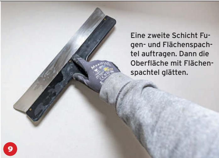
Eine zweite Schicht Fugen- und Flächenspachtel auftragen. Dann die Oberfläche mit Flächenspachtel glätten.
