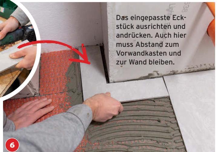
Das eingepasste Eckstück ausrichten und andrücken. Auch hier muss Abstand zum Vorwandkasten und zur Wand bleiben.
