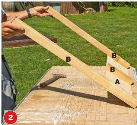
**2** Die langen Latten (B) erleichtern das Anbringen der „Belüftungsplatte“ zwischen den Sparren.
