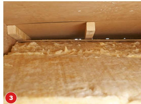
**3** Die Platte wird am Sparrenfuß so angebracht, dass diese den Luftspalt zwischen Dämmung und Dach offen hält.
