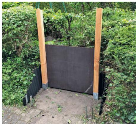
Um die Rückwand vor dem dahinter liegenden Erdwall zu schützen, setzte Peters auf Siebdruckplatten mit Bitumenwellpappe
