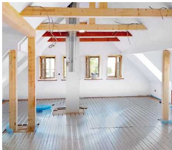
Die Wärmeleitbleche bieten dem Verbundrohr eine perfekt passende Einlegenut
