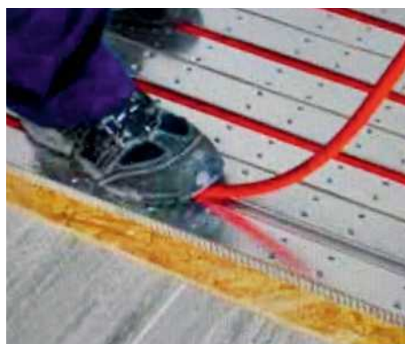
Die Wärmeleitbleche bieten dem Verbundrohr eine perfekt passende Einlegenut
