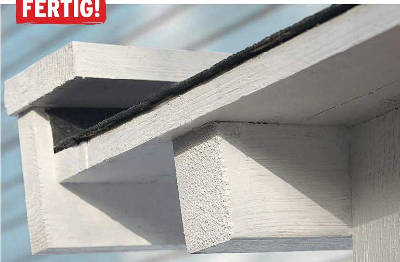
Clever gelöst: Die Bitumendachbahn steht vorn als Tropfkante 1 cm über, um das Holz zu schützen.
