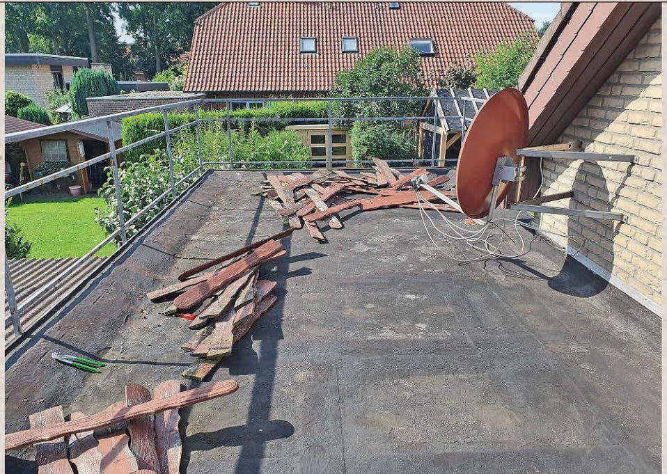
Die über 30 Jahre alten Bretter an der Umrandung des Daches wurden inklusive der stark angerosteten Schrauben komplett demontiert
