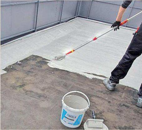
Das Dach wird mit einem bitumen- und lösungsmittelfreien Flüssigkunststoff gestrichen
