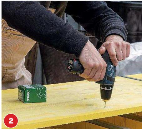
**2** Im unteren Bereich der Leisten zwei Bohrungen zur Befestigung an der Küchenplatte anzeichnen.
