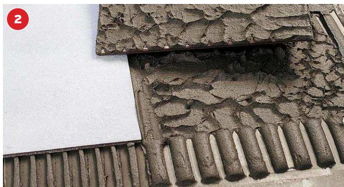
Hohlstellen unter den Fliesen sind durch das beidseitige Auftragen des Klebers ausgeschlossen.
