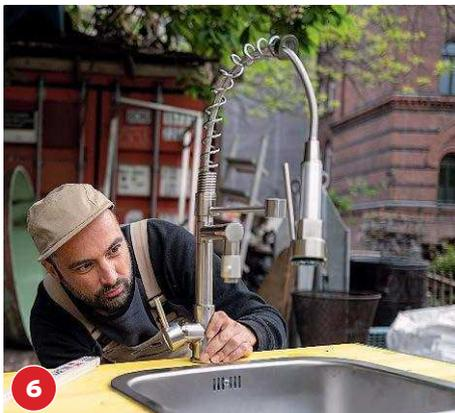
Den Siphon an den Abfluss der Spüle setzen, die Spüle einsetzen - verschrauben. Wasserhahn einsetzen und verschrauben.
