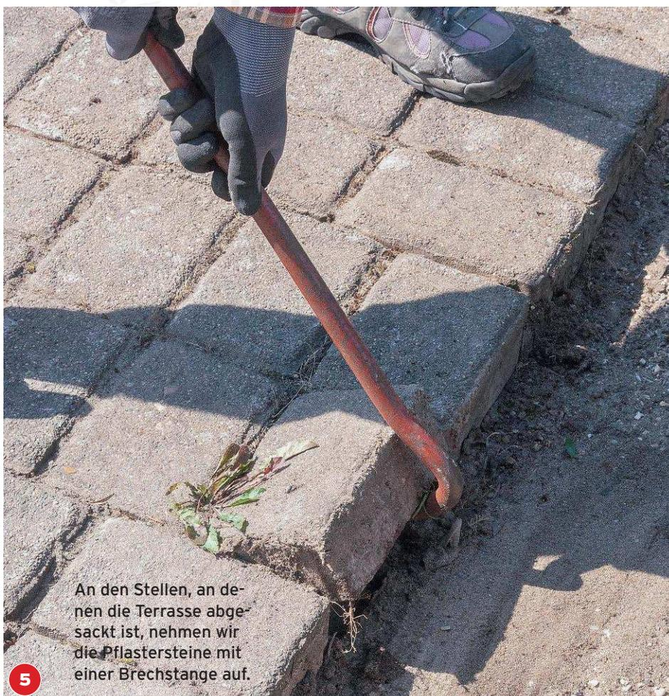
5 An den Stellen, an denen die Terrasse abgesackt ist, nehmen wir die Pflastersteine mit einer Brechstange auf.
