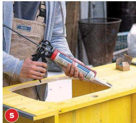
Schnittkanten der Löcher (Wasserhahn und Spüle) mit Silikon benetzen. Eine dünne Silikonwurst für die Spüle auftragen.
