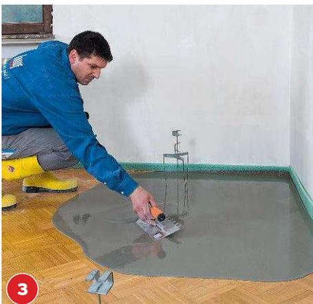
3 Mit der Zahnkelle unterstützen Sie den Verlauf der Masse, vor allem bis an die Ränder und bis in die Ecken hinein.
