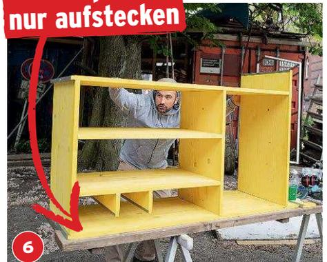
Restliche, feststehende Bretter ebenso montieren. Mittig und je 5 cm von den Außenkanten 60-mm-Schrauben setzen.
