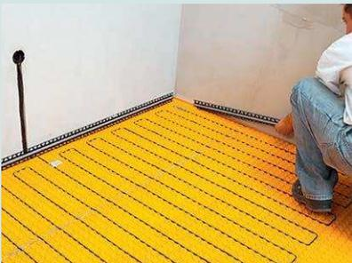
Elektrische Heizschleifen werden direkt in den Fliesenkleber eingearbeitet
