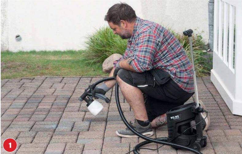
Fläche trocknen lassen. Tiefgrund in den Farbtank füllen und mit Abstand von 30-50 cm aufbringen. 12-24 Stunden trocknen lassen.
