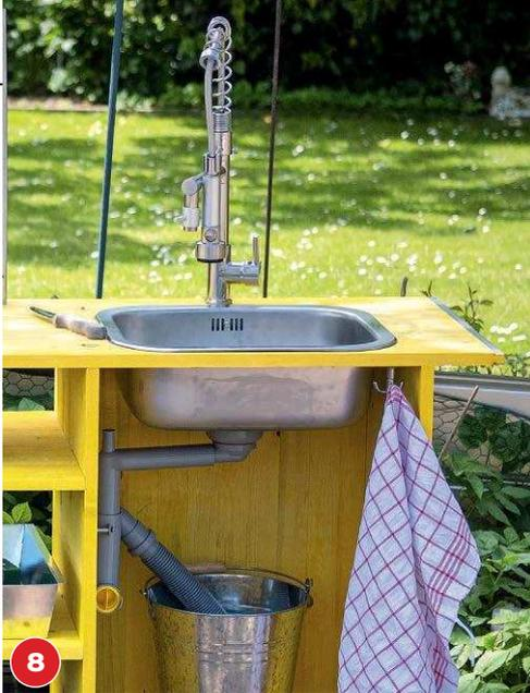
Einen Eimer unterstellen. Am besten läuft das Abwasser über einen flexiblen Abflussschlauch am Siphon ab.
