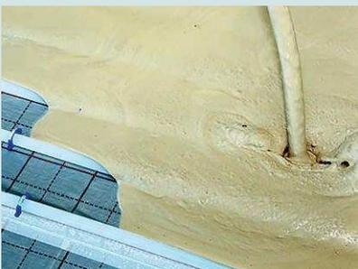
Heizungsrohre sind dicker und brauchen eine Mindestüberdeckung durch den Estrich
