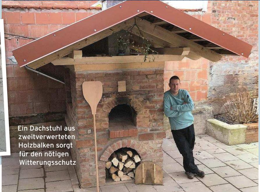
Ein Dachstuhl aus zweitverwerteten Holzbalken sorgt für den nötigen Witterungsschutz
