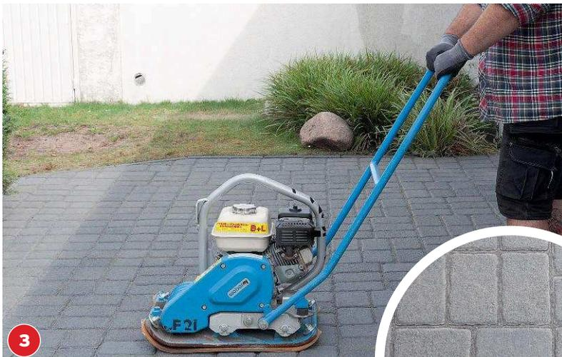
Mit der Rüttelplatte zweimal über die Terrasse gehen, um den Fugenmörtel zu verdichten. Schonmatte verwenden!
