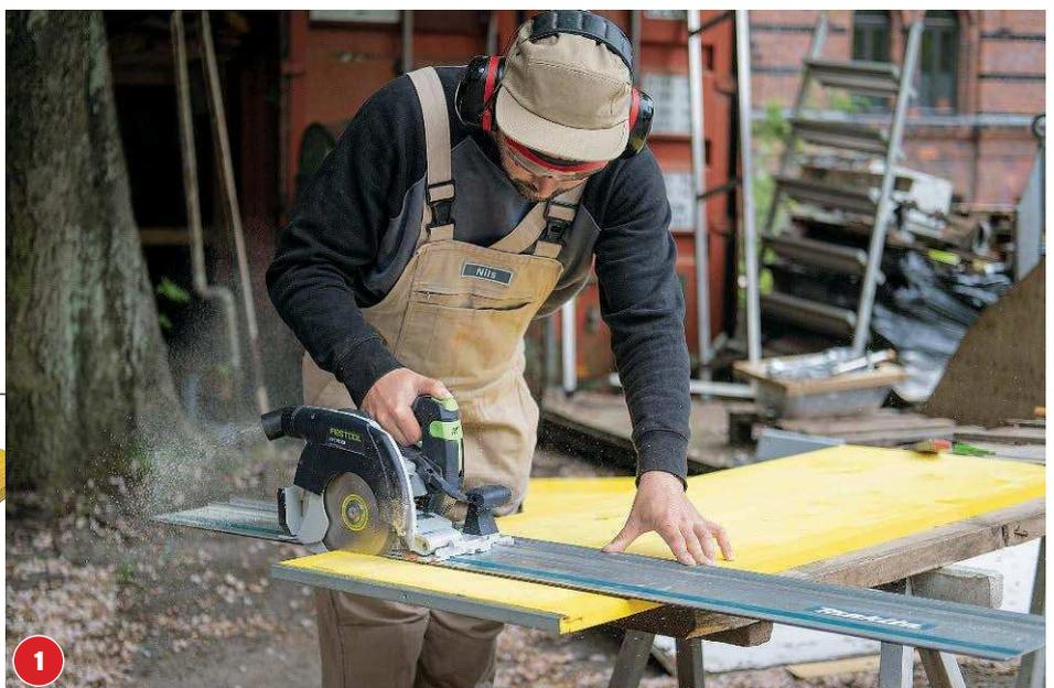
Mehrzwecktafeln für die großen senkrechten und waagrechten Elemente zusägen. Restabschnitte für senkrechte Zwischenbretter und Brett für Aufhängung ablängen (siehe Bauskizze).
