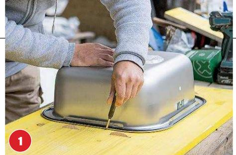
Spüle auflegen, zeichnen, umlaufend rund 5 mm abziehen. 45 cm von Außenkante Bohrloch-Mitte (Wasserhahn) zeichnen.
