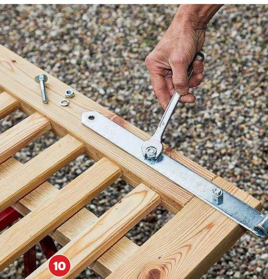
10 Montieren Sie die Ladenbänder, indem Sie die Schrauben in die Löcher drehen.
