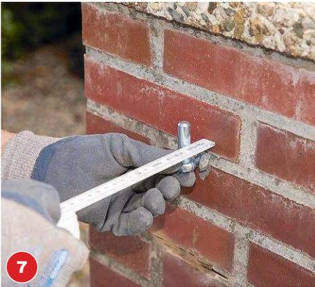
7 Stecken Sie das Torband in den frischen Mörtel. Richten Sie das Band aus und fixieren Sie es mit kleinen Keilen.
