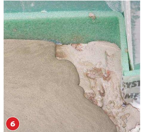
Ränder und Ecken vorspachteln, damit der Dämmstreifen an der Wand anliegt und keine Masse dahinter läuft.
