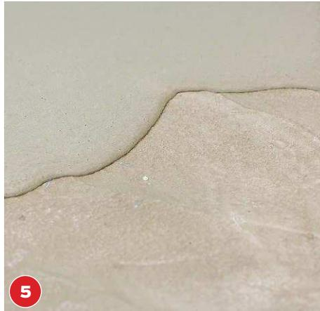
Die Masse verläuft zwar von selbst, aber diese Bewegung unterstützen Sie mit der Zahnkelle, damit es schneller geht.
