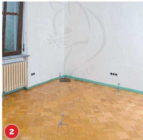
2 Hier sind Randdämmstreifen an allen aufgehenden Bauteilen zwingend. Mit Spachtelmasse rundum fixieren.
