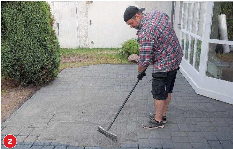
Mit weichem Besen den Mörtel gerade und diagonal in die Fugen kehren, bis kein Mörtel mehr auf der Oberfläche liegt.
