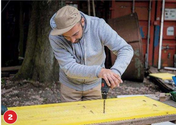
Mit 30-mm-Forstnerbohrer ein Loch für den Wasserhahn bohren. An den Ecken der angezeichneten Spülen-Aussparung Löcher bohren und als Einstieg...
