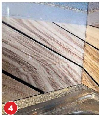
Zum Schluss verkleben Sie die beiden Teile über Eck und versiegeln die Fugen mit Silikon.
