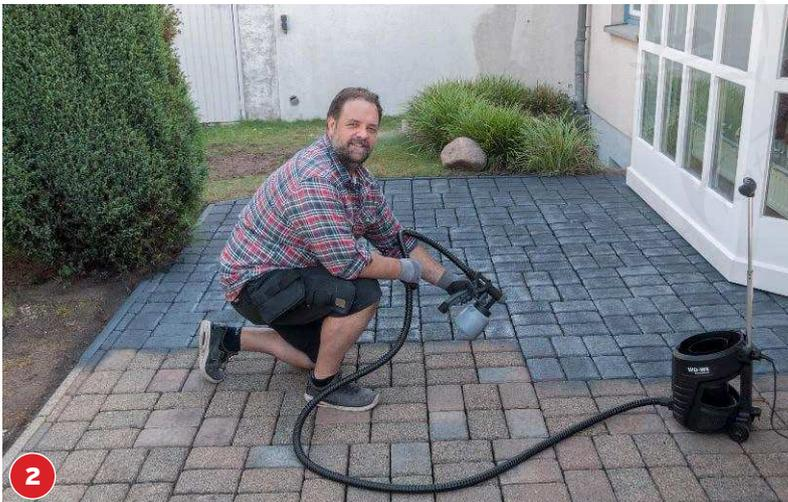
Betonlasur in Farbtank füllen und im Abstand von 30-50 cm aufbringen. 12-24 Stunden trocknen lassen. Alle Seiten der Steine und die Fugen mit Lasur besprühen.
