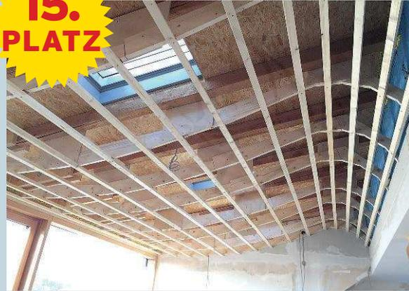
Anhand von genauen Zeichnungen fertigte Dieter Löschner die Rippen für die Unterkonstruktion
