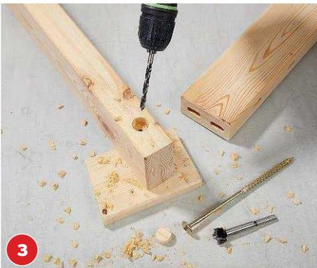
**3** Legen Sie die Ecken bündig aneinander und markieren die Positionen der Dübel mit 2,0 mm und der Verschraubung. So arbeiten Sie an allen zwölf Verbindungen.
