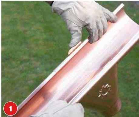
**1** Bevor die Rinne in die Rinneneisen gelegt wird, montiert man den Rinnenkessel einmal provisorisch. Die Position des Ablauflochs mit einem Nagel markieren.
