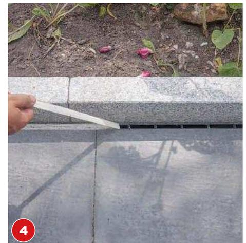
Nach dem Trocknen den Sand gut wässern und dann das Krepband vom Aufsatz der Regenwasserrinne abziehen.
