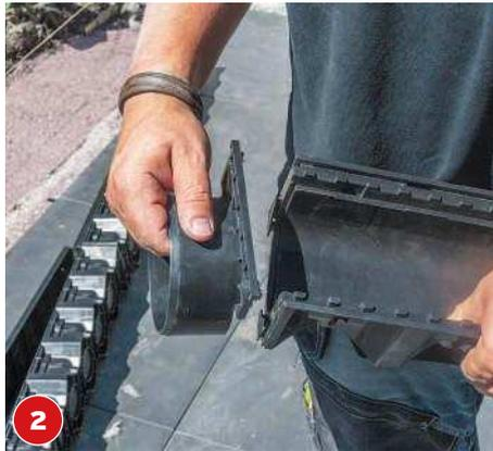
**2** Auf ein Ende der Rinne den Ablaufstutzen setzen, auf das andere Ende die Stirnwand. Über den Stutzen läuft Wasser ab.
