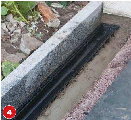
**4** Die Rinne so einlegen, dass die Stirnwand höher liegt als der Stutzen. Die Rinne eindrücken und Beton anziehen lassen.
