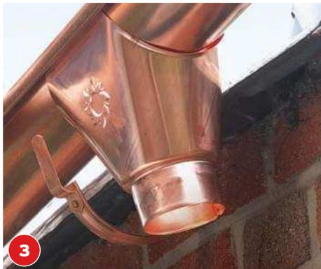
**3** Den Kessel einhängen und die Laschen um den Rinnenrand biegen. Die Rinne in die Eisen legen, ausrichten und mit den Laschen an den Haken festsetzen.
