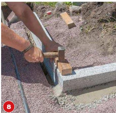
8 Die gesetzten Granitsteine mit Schlagholz und Hammer fest in den Beton klopfen; noch mal per Wasserwaage prüfen.
