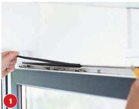
Die Gummidichtung am Fensterflügel wird mittig in einem Bereich von etwa 30 cm entfernt und der Bereich gereinigt.
