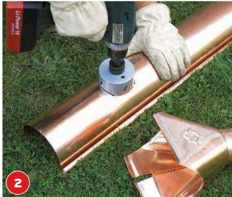
**2** Nachdem der Rinnenkessel wieder abgenommen wurde, den Ablauf von der Unterseite mit einer Bimetall-Lochsäge im Durchmesser des Fallrohrs sägen.
