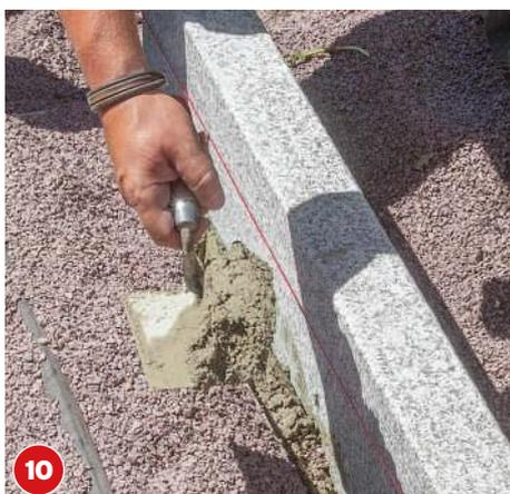
10 Sind die Steine fest ausgerichtet, von beiden Seiten Betonstützen formen, hierzu mit Maurerkelle Beton andrücken.
