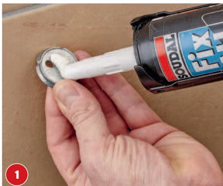
Glatte Oberflächen wie Metall und Fliesen lassen sich mit Klebstoffen auf Hybridpolymerbasis einfach verkleben.
