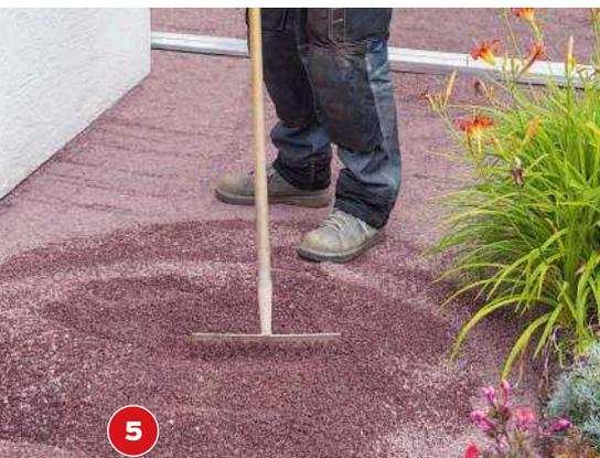
Auf die gesamte Tragschicht verteilen wir nun mit einer Harke eine 5-10 cm hohe, gleichmäßige Schicht Splitt.
