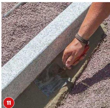
11 Die Stütze schräg noch oben zum Stein formen. Darauf achten, dass die Stütze später unterhalb der Plattenfläche liegt.
