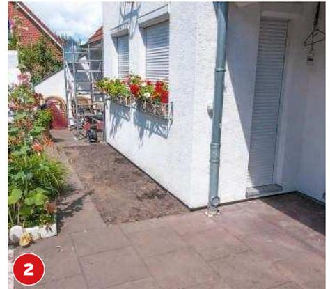
Am Übergang von der Terrasse zum Untergrund (Rand) die erste Platte herausnehmen. Von hier alle Platten entfernen.
