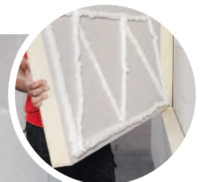
Auch Dämm- und Trockenbauplatten kann man mit Polyurethan verkleben
