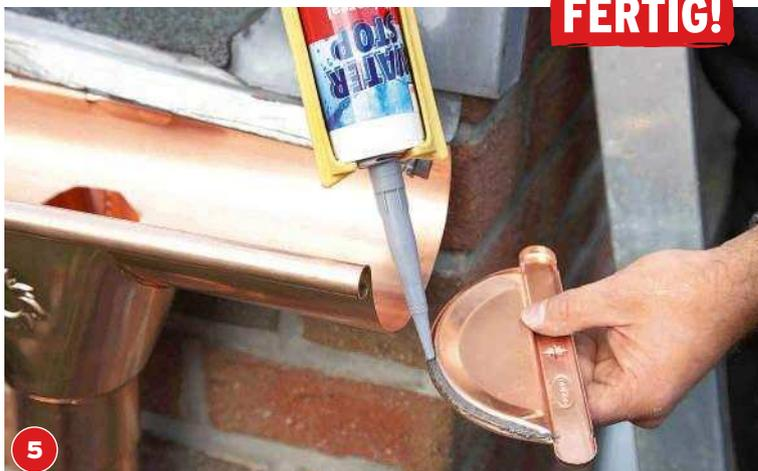
Zum Schluss werden die Rinnenböden mit Dichtmasse auf MS-Polymerbasis angeklebt. Ist die Rinne etwas verformt und unter Spannung, sollte ein Profil die Böden verlöten.
