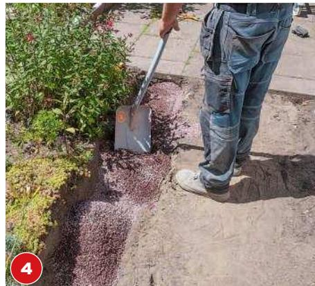
An den Rand kommt später die neue Seiteneinfassung. Damit sie stabil aufliegt, die Stelle mit Verlegesplitt auffüllen.
