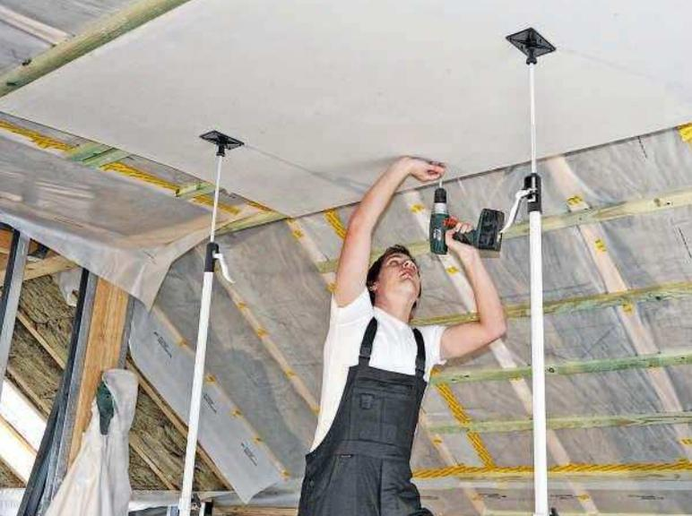
Bei Überkopf-Arbeiten oder auch in der Schräge ersetzen die Stützen einen Helfer
