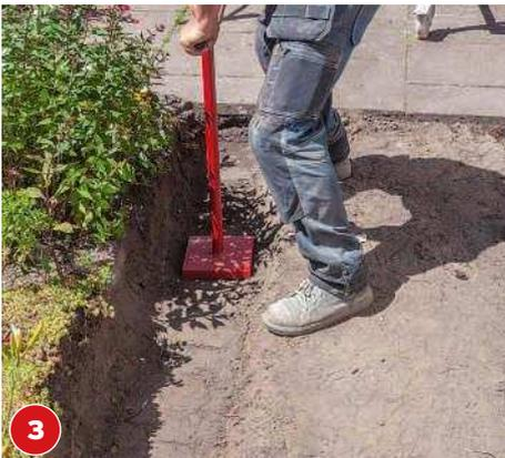
Darunter findet sich eine Tragschicht aus Schotter und Sand. Am Rand tiefer ausheben und die Schicht verdichten.
