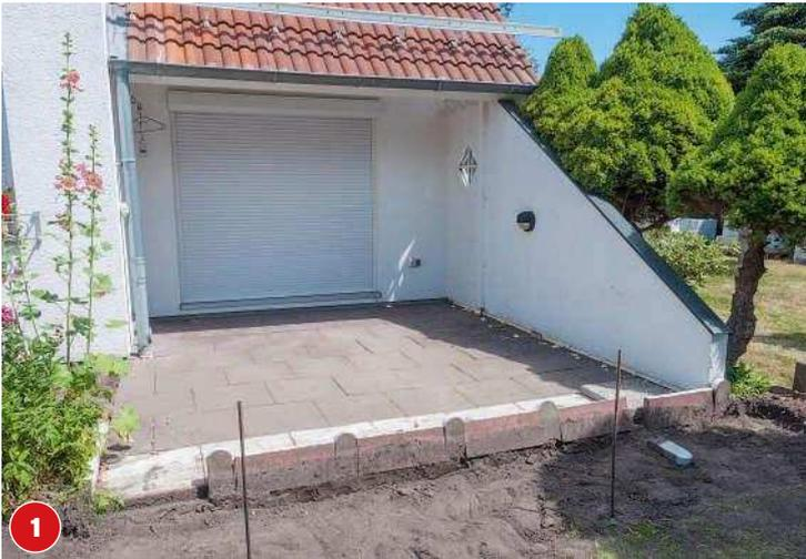
Die Witterung hat der Terrasse sichtlich zugesetzt: Sie ist an einigen Stellen abgesackt. Deshalb die alten Platten abnehmen.
