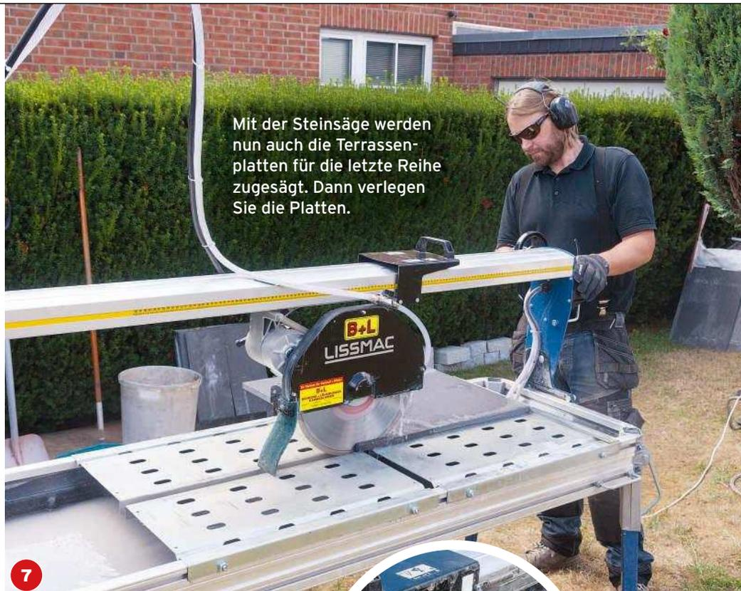
Mit der Steinsäge werden nun auch die Terrassenplatten für die letzte Reihe zugesägt. Dann verlegen Sie die Platten.
