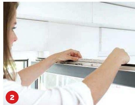
Den Fensterlüfter mit Klebestreifen oder Schrauben mittig am Fensterflügel anbringen. Er ist auch für Mieter geeignet.
