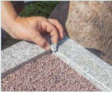
Die Randsteine sind gesetzt, da bricht ein Stück Stein ab. Den Randstein zu entfernen und einen neuen einzusetzen, ist keine Option.
