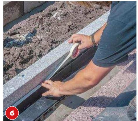
**6** Nun verschließen wir die Öffnung der Rinne mit Kreppband. So kann später kein Fugensand hineingelangen.
