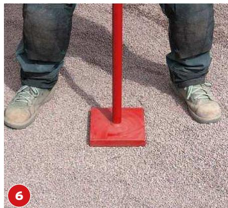
Anschließend muss der Splitt verdichtet werden. Dafür entweder einen Handstampfer oder eine Rüttelplatte nehmen.
