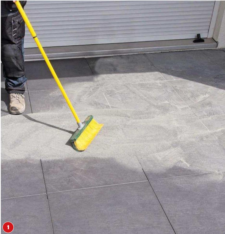
Mit einem weichem Besen den Fugensand in die Fugen kehren. Dann mit einem Gummihammer auf die Platten klopfen - so setzt sich der Sand fest.
