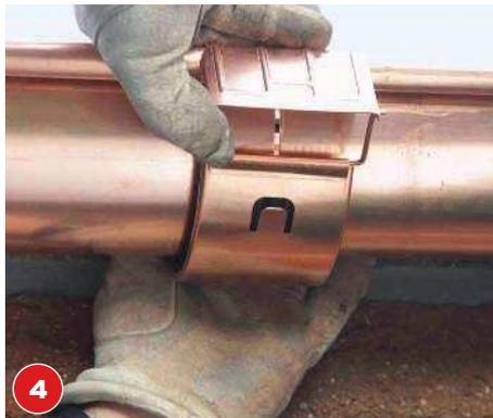
**4** Die Stöße der Rinnenteile werden mit den Verbindungsklammern verbunden. Auf der Innenseite sorgt ein Gummiprofil mit zahlreichen Dichtlippen für Wasserdichtigkeit.
