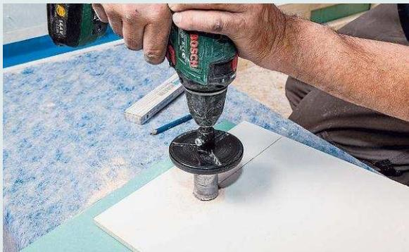
**Diamantbesetzte Bohrkronen** arbeiten sich durch jede noch so harte Fliese. Möglichst mit Bohrständer und bei langsamer Geschwindigkeit bohren
