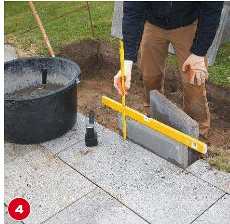
**4** Mit der Wasserwaage den Stand der Platten prüfen. Hat die Terrasse eine Neigung, Teich dieser Neigung anpassen.
