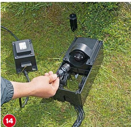
**14** Die Kabel einstecken und den Trafo, der vor Schlagregen geschützt liegen sollte, anschließen.
