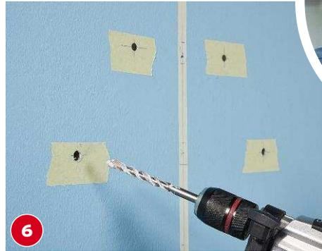
**6** Mit einem Steinbohrer bohren wir die Löcher für die Tablarträger und achten auf den Wandaufbau, hier: massive Steinwand.
