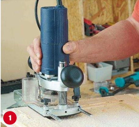
**1** Mit der Oberfräse rundum eine 15 mm breite Fläche mit 3 mm Stärke in die untere Leiste einklinken.
