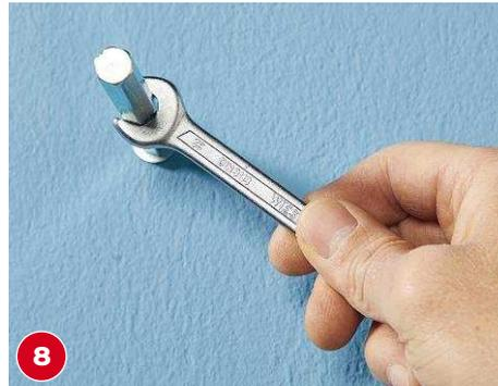
**8** Durch das Anziehen mit dem Maulschlüssel spreizt sich der Dübel in der Wand und sitzt dadurch fest.
