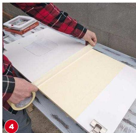
Den Ausschnittsbereich der Klappe mit Kreppband überkleben. Die durchscheinende Markierung übertragen.
