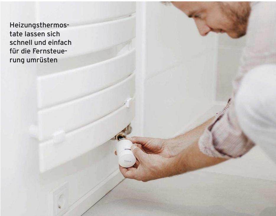
Heizungsthermostate lassen sich schnell und einfach für die Fernsteuerung umrüsten
