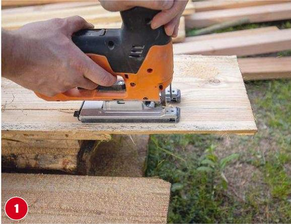
Für die Bretter der Innenseite müssen hier und da um die Pfosten herum Teile ausgeklinkt werden
