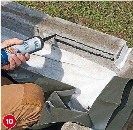
**10** Mit Spezialkleber zwei Klebestränge auf die Betonplatten spritzen, die Teichfolie ringsherum andrücken. Trocknen lassen.
