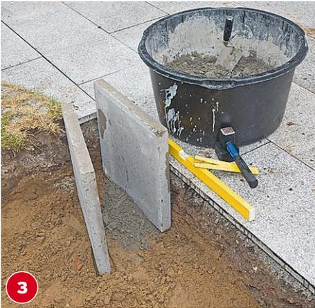
**3** Erde ausheben. Die Gehwegplatten in ein kleines Betonbett stellen und mit einem Plattenhammer in Position bringen.
