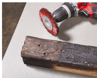
Ruß und weiche Holzbestandteile mit einer Nylonbürste ausbürsten
