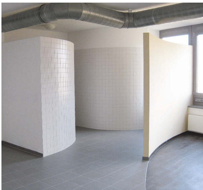
Geschwungene Wände im Bad oder Feuchtbereich lassen sich auch verfliesen. Die maximal einsetzbare Fliesengröße hängt aber vom Biegeradius ab.
