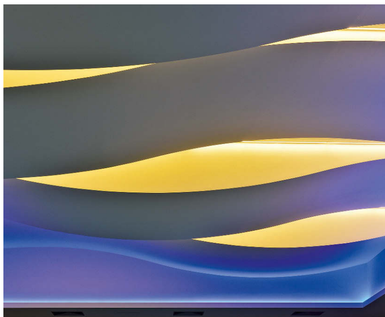
Auch an Decken lassen sich die Gipsplatten schwungvoll mit Licht gestalten. Allerdings ist hier die Unterkonstruktion sehr aufwendig.
