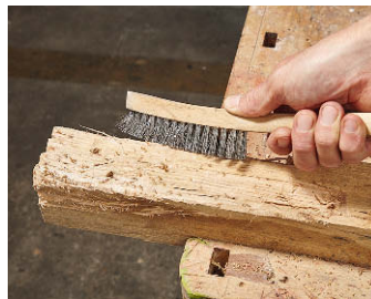
Lange Fasern werden mit einer Drahtbürste entfernt und die Oberfläche geglättet
