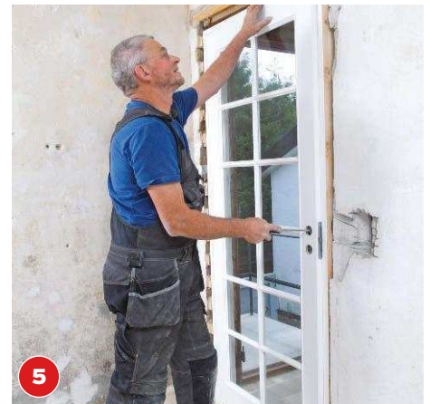
5 Tür einhängen. Zarge so mit Keilen ausrichten, dass der Abstand zur Tür überall gleich ist. Jetzt verschrauben.
