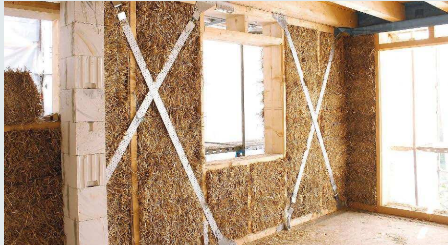
Beim Einbau pressen Rispenbänder das Stroh in die Wand. Sie werden später entfernt
