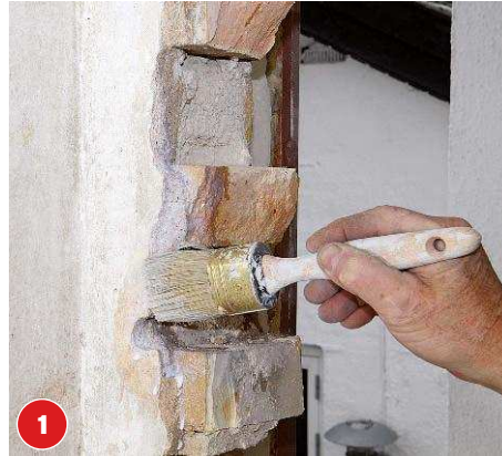
1 Streichen Sie das offene Mauerwerk als Vorbereitung für das Verputzen mit Acrylgrundierung.
