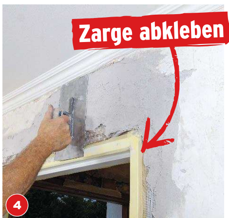
4 Den Gipsputz mit einer Glättkelle auftragen. Nach dem Trocknen mit Schleifmittel (60er-Körnung) grob abschleifen.
