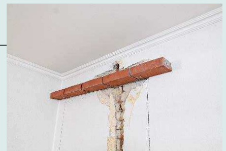
Die Tiefe des Auflagers auf dem Mauerwerk sollte mindestens 11,5 cm betragen
