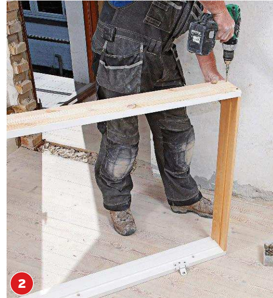
2 Verschrauben Sie die Zarge mit 4,5 x 70 mm großen Schrauben. Bohren Sie die Löcher für die Türschwelle vor.
