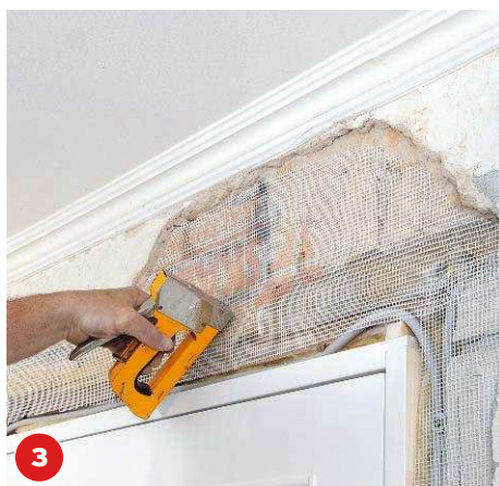
3 Bringen Sie auf dem Mauerwerk Armierungsgewebe aus Kunststoff an. Das sichert den Putz gegen Rissbildung.
