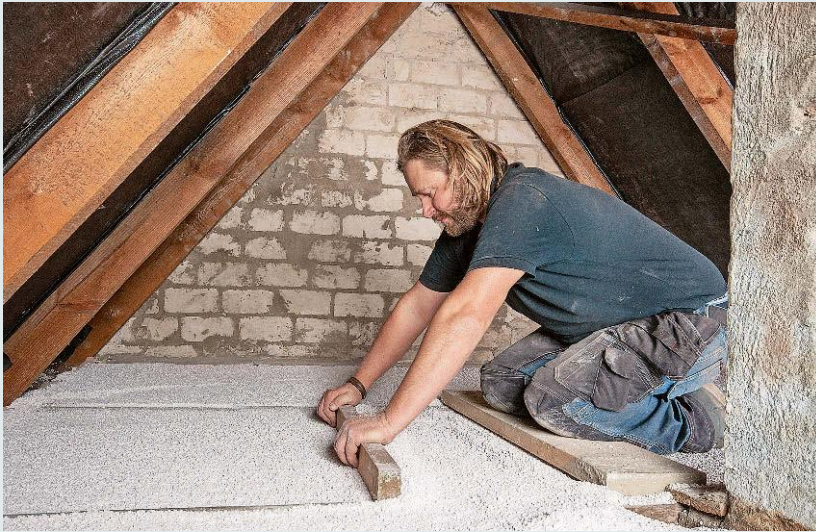
Die Perlite-Dämmung für die oberste Geschossdecke wird mit einer Latte glatt gezogen
