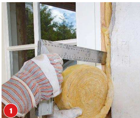
1 Die Lücke zwischen Zarge und Wand mit Mineralwolle verschließen. Das verhindert Zugluft und dämmt Geräusche.
