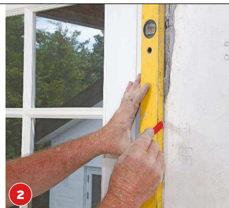
2 Blendrahmen der Zarge anzeichnen. So erkennen Sie, wie viel von der auszubessernden Fläche im Sichtbereich liegt.
