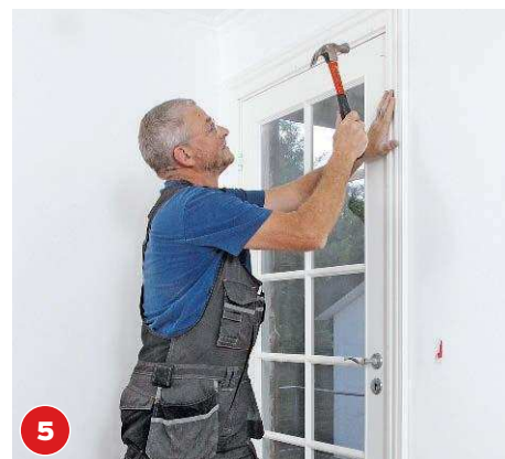
5 Die Zargeneinfassung mit 1,4 x 35 mm großen Leistenstiften befestigen. Die Eckverbindungen verleimen.
