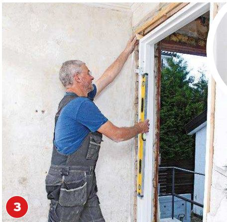
3 Legen Sie ein Holzstück unter die Zarge und fixieren Sie die Zarge mit einem Holzkeil. Die Bandseite exakt ausrichten.
