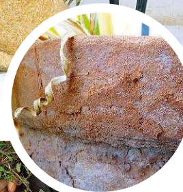
Gefriert die Feuchtigkeit im Topfmateriail, kommt es zu unschönen Abplatzungen
