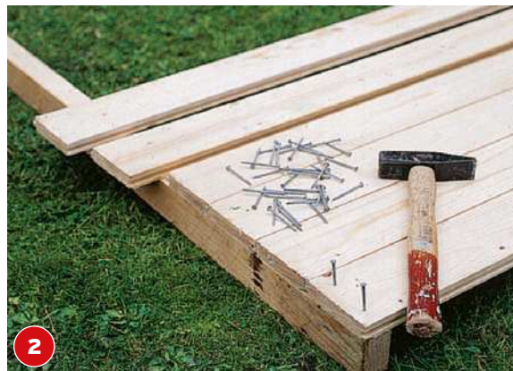
Das Dach wurde aus Rauspundbrettern gebaut, die dicht zusammengeschieben und auf Dachlatten genagelt werden.
