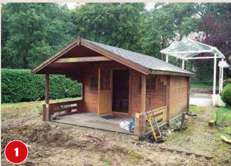
1 Dieses alte Gartenhäuschen wurde abgebaut: ein willkommener Materialspeicher für das neue Projekt.
