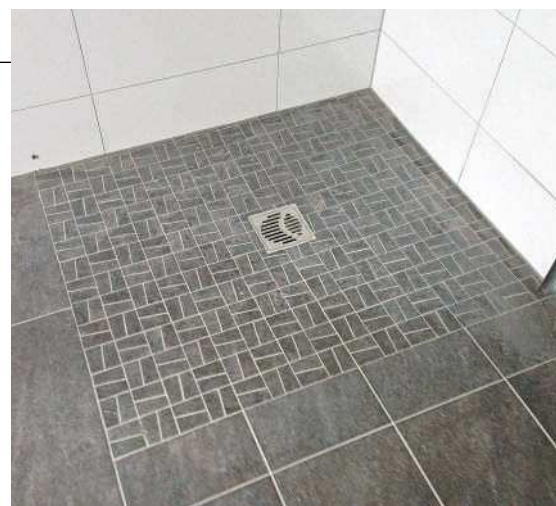
Ein gefliester Estrichboden bietet alle Möglichkeiten bei der Gestaltung der Dusche und bei der Platzierung des Abflufs
