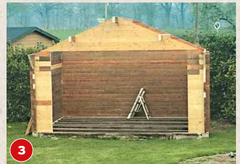
3 Das Grundgerüst ist aufgebaut, nur das Dach fehlt noch. Die meisten Bretter stammen von der alten Hütte.
