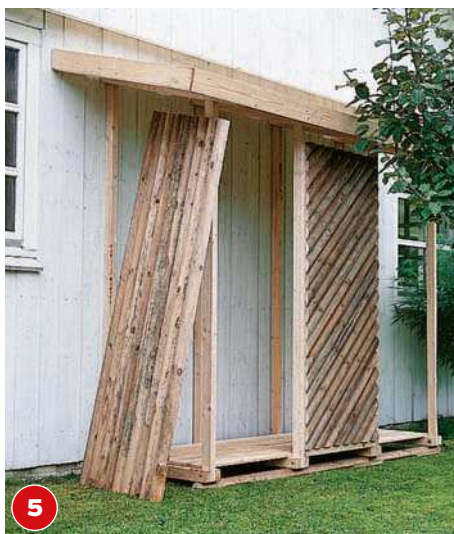
Die Seiten des Schuppens werden mit langen Jägerzaun-Querriegeln verkleidet, die 7 bis 8 cm stark sind.
