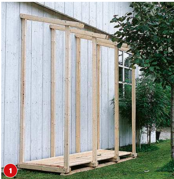
Die Ständerrahmen sind direkt am Haus oder an zwei querlaufenden, ans Haus gedübelten Leisten festgeschraubt.
