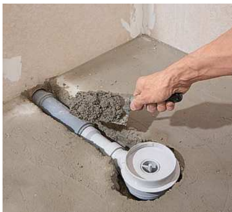
Der tiefergelegte Abfluss liegt oft noch ein Stück in der Bodenplatte. Er wird mit Estrichbeton abgedeckt
