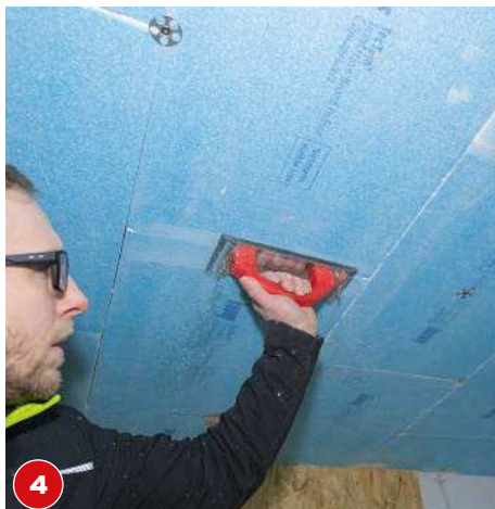
4 Die Stöße der Dämmstoffplatten werden im nächsten Schritt mit einem Handschleifer angeglichen.
