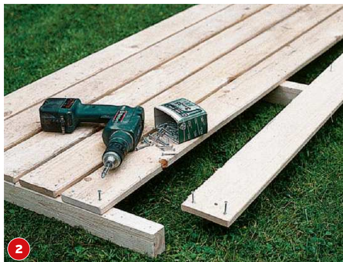
Sechs Bodenbretter von 10 cm Breite werden mit 1 cm Abstand voneinander außen bündig auf Dachlatten geschraubt.
