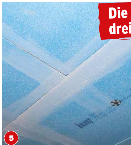
5 Die eingeebneten Dämmstoffplatten sollten eine möglichst plane Fläche ergeben. Entfernen Sie Schleifstaub.
