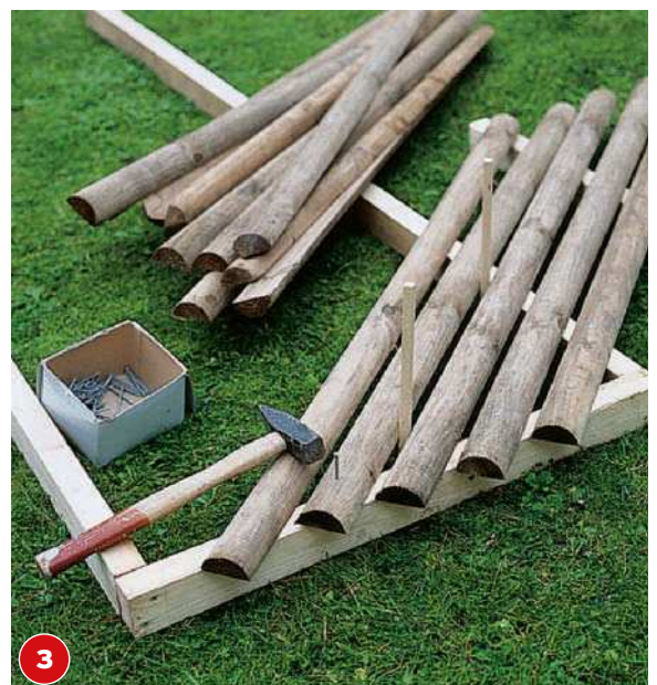
Leistenrahmen mit aufgenagelten Jägerzaunlatten bilden die Vorderfront. Zwei sind als Türen angebracht
