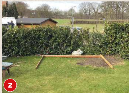
2 Die Planung steht. Jetzt ermittelt Thomas Bühren die genaue Position, bevor das Fundament erstellt.
