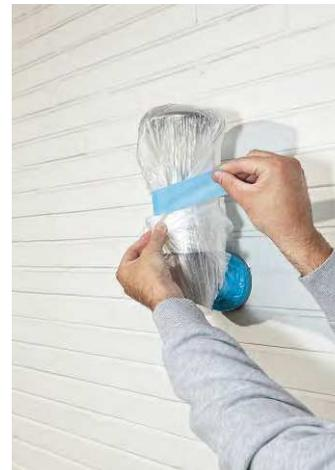
Außeninstallationen wie Lampen oder Steckdosen decken Sie mit Folie und Klebeband eng ab, damit Sie noch dahinter kommen
