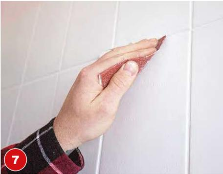
**7** Die grundierte Oberfläche mit feinem Schleifpapier (180er Körnung) anschleifen und Unebenheiten ausbessern.
