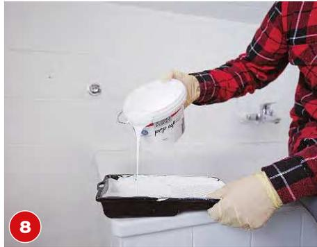
**8** Ist die Grundierung getrocknet, geht es mit der Renovierfarbe weiter. Zuerst gut aufrühren und portionieren.
