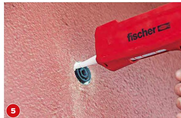
Nun wird die Bewegungsfuge um den Konus mit Kleb- und Dichtstoff abgedichtet und muss trocknen.
