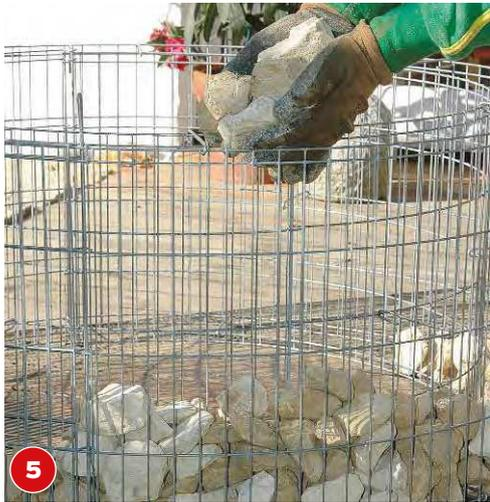
Den Drahtring an der endgültigen Position aufstellen und die Steine ohne große Löcher oder Zwischenräume einfüllen.
