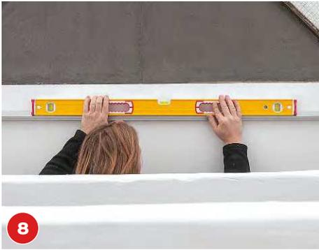
**8** Die Profile mit einer Wasserwaage an der Wand ausrichten. Tipp: Statt einer Leiter besser ein Gerüst verwenden.
