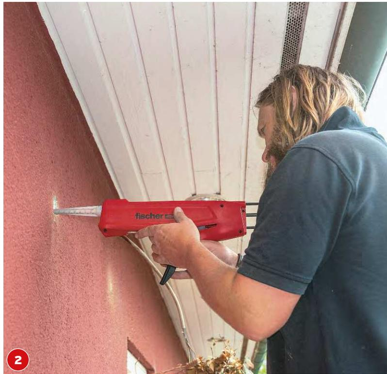
Die Mischdüse in das Bohrloch einführen, den Mörtel einpressen und dabei das Gerät immer ein Stück weiter langsam herausziehen. Die Menge ist abhängig vom Wandaufbau.
