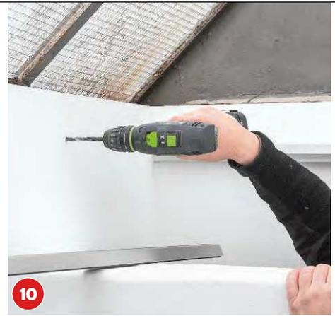
**10** Mit einem für das Wandmaterial (hier: Gipskarton) geeigneten Bohrer die Löcher für die Dübel vorbohren.
