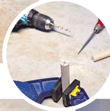
Für die Bohrungen die Mitte des Rundstabs mit einem Kreuz markieren
