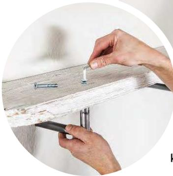
Zum Schluss die Rundrohrwinkel jeweils mit einer Senkkopfschraube befestigen.
