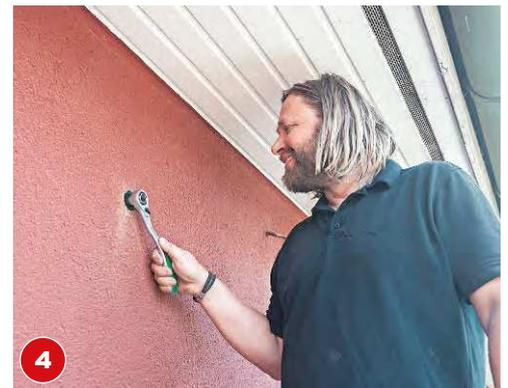
Wenn der Mörtel trocken ist, richten Sie den Konus mit Ringschlüssel oder Knarre aus - maximal 5 mm vor der Wand!
