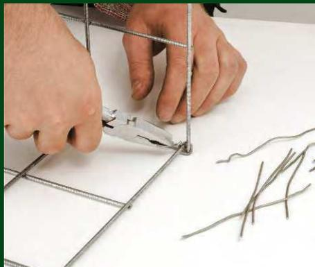
Mit Drahtstücken lassen sich alle Gabionen-Bauteile miteinander verbinden, nicht nur die Ecken
