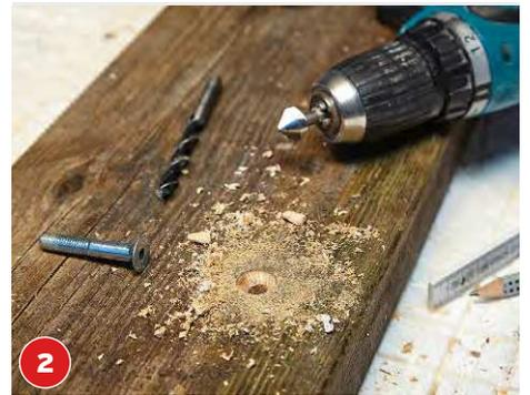
**2** Löcher mit 8 mm Durchmesser für die Rundrohrverbindung anzeichnen und bohren. Anschließend senken.
