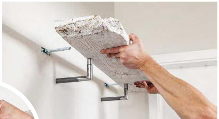
Vorboren, Dübel einsetzen und Rundrohrwinkel in die Wand drehen. Im nächsten Schritt die Tablarträger montieren und das Brett aufstecken.
