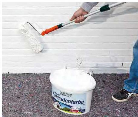
Mit der Rolle streichen Sie die Wand zunächst horizontal. Im Anschluss ein zweites Mal 90 Grad versetzt
