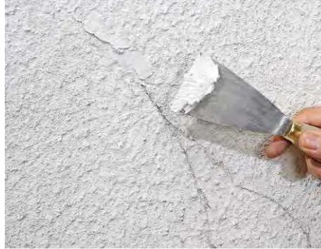
Anschließend verfüllen Sie die entstandenen Öffnungen mit einem Füllspachtel
