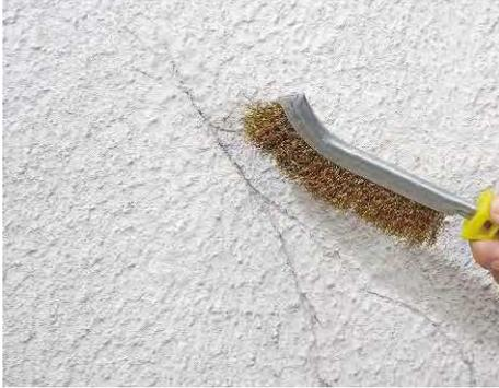
Entstandene Risse mit einem Spachtel öffnen oder kleinere einfach gut ausbürsten
