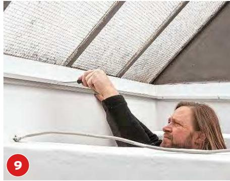
**9** Sind die Profile waagrecht an der Wand ausgerichtet, markieren Sie die Stellen für die Bohrlöcher.
