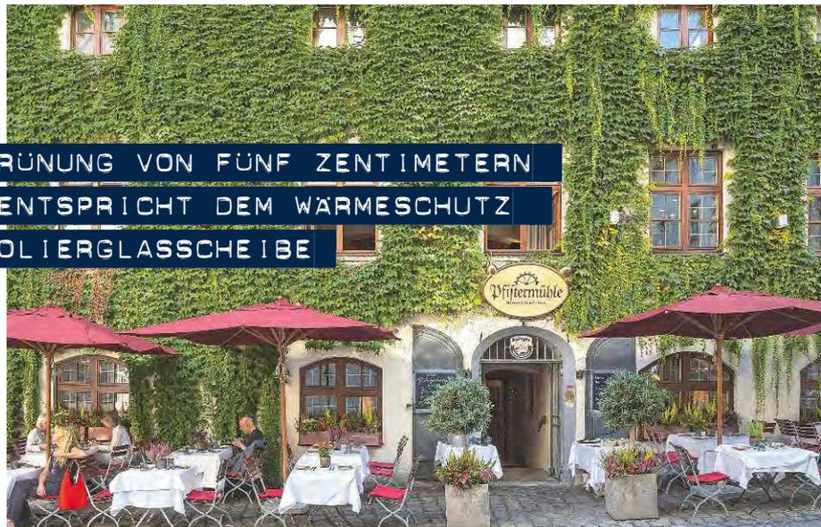
EINE BEGRÜNUNG VON FÜNF ZENTIMETERN „DICKE“ ENTSPRICHT DEM WÄRMESCHUTZ EINER ISOLIERGLASSCHEIBE
