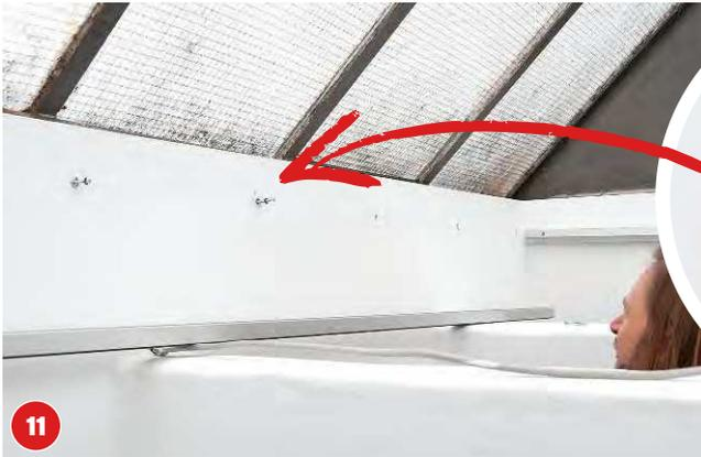
**11** In die Löcher werden die passenden Dübel (abhängig vom Wandmaterial) eingesetzt. Hier: Metall-Hohlwanddübel.
