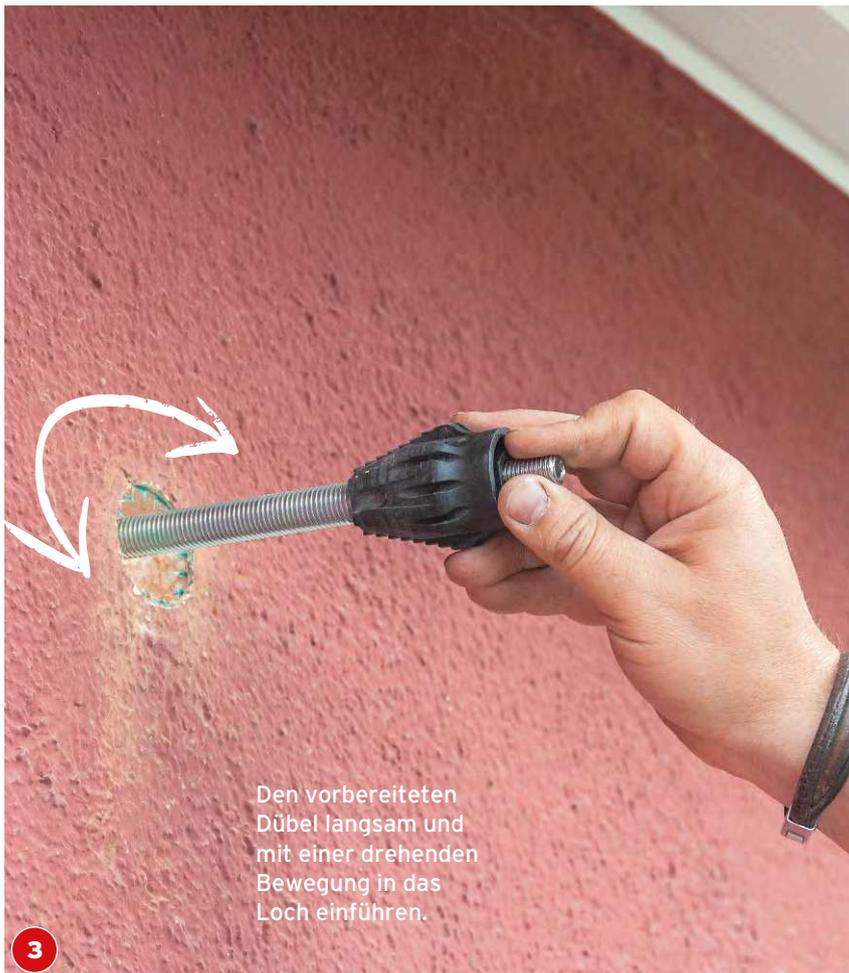
Den vorbereiteten Dübel langsam und mit einer drehenden Bewegung in das Loch einführen.
