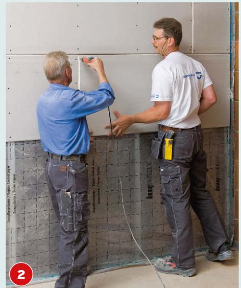
Die Gipsplatten verschraubt man am Ständerwerk, die Plattenfugen müssen verspachtelt werden.
