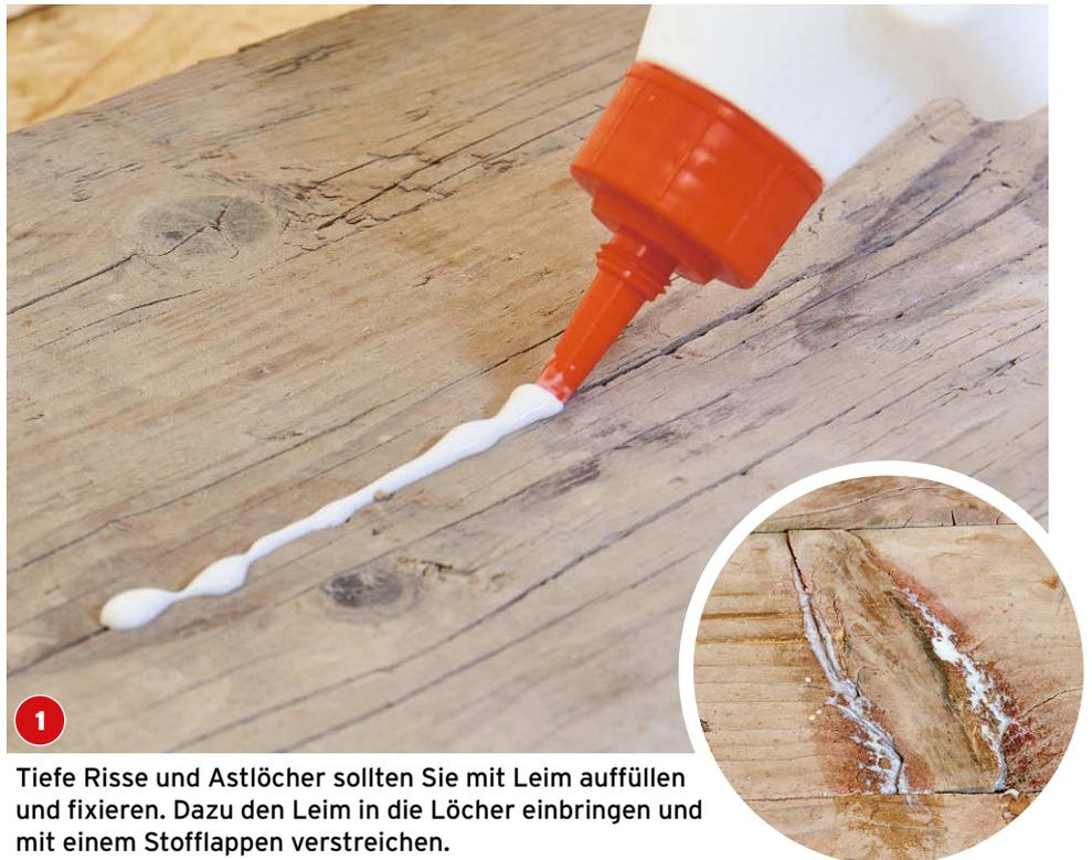
Tiefe Risse und Astlöcher sollten Sie mit Leim auffüllen und fixieren. Dazu den Leim in die Löcher einbringen und mit einem Stofflappen verstreichen.
