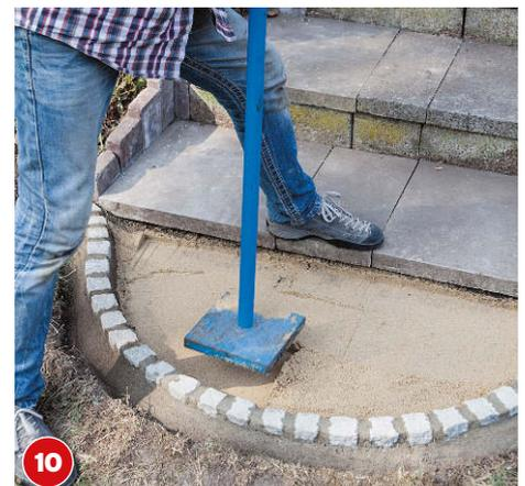
**10** Nach zwei Tagen füllen Sie die Fläche etwa 2 cm hoch mit Sand auf und verdichten sie die Fläche leicht.
