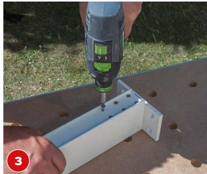
Die Füße an den Stützen festschrauben. Dann die Stützen mit dem Querträger verbinden und alles aufstellen.
