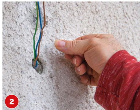
**2** Mit entsprechendem Bohrer vorbohren und die mitgelieferten Dübel eindrücken.
