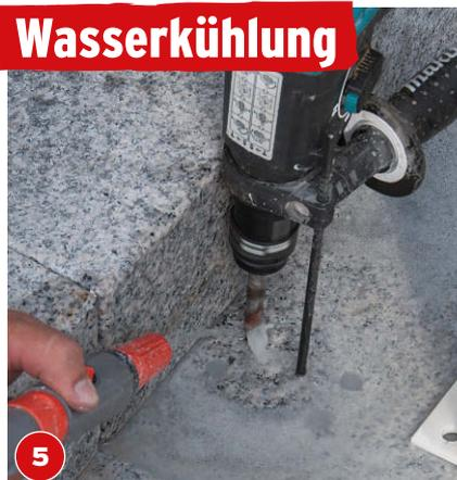
Die Befestigungslöcher in das Fundament (hier: Granitstufen) bohren. Dabei den Bohrer mit Wasser kühlen.
