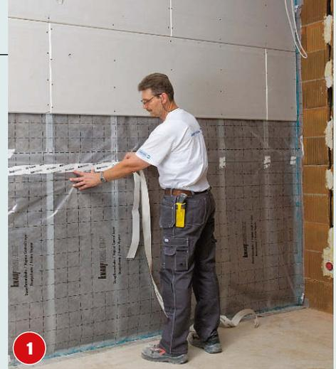
Ist die Dämmung eingebaut, muss man die Folie sorgfältig abkleben, damit keine Luft hinterströmt.
