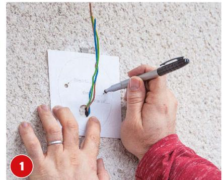
**1** Die Bohrschablone an der Aussenwand anlegen und die Bohrlöcher markieren.
