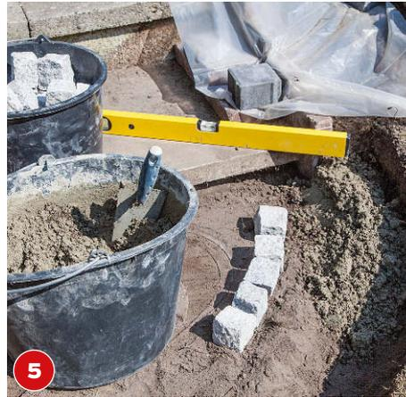
**5** Füllen Sie den frisch angemischten Mörtel in die Rinne und setzen Sie den ersten Stein (angefeuchtet) hinein.
