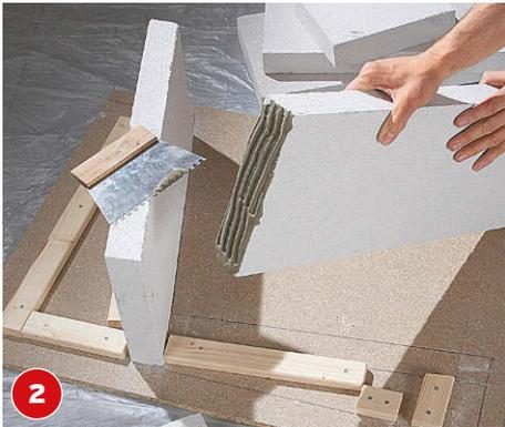
2 Um die Platten aus Porenbeton zu verbinden, benötigen Sie speziellen Porenbetonkleber. Diesen tragen Sie gleichmäßig mit dem Zahnpachtel auf.
