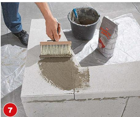
7 Für die Oberflächenbehandlung eine dünne Putzschicht mit dem Quast auftragen und gut eintrocknen lassen.
