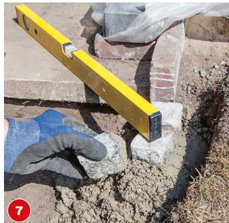
**7** Übertragen Sie die Höhe für die Pflastersteine mit einer Wasserwaage von der letzten Trittstufe.
