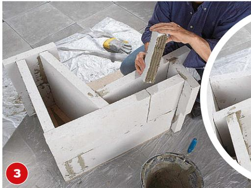
3 Die zweite Lage auf Stoß „aufmauern“. Damit die Konstruktion stabil bleibt, verstärken Sie die Hohlräume in der Sitzfläche sowie der Rückenlehne mit eingeklebten Keilen.
