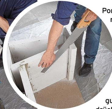
Porenbetonkleber muss man etwa zwei Stunden abbinden lassen und Überstände dann mit einer Betonsäge bündig absägen. Für gute Führung drückt man das Sägeblatt mit der freien Hand eng an die Fläche
