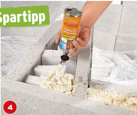
4 Um Zeit und Geld zu sparen, ist es sinnvoll, gleichmäßig Styroporplatten in den Hohlräumen zu verteilen. Den Rest bis zum Rand mit Bauschaum auffüllen.
