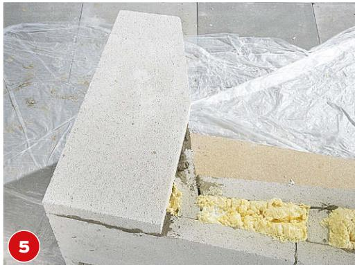
5 Haben Sie die Seitenteile aufgeklebt, drehen Sie den Sitz, um die andere Seite zu verfüllen. Um die Seitenteile zu verschließen, setzen Sie jetzt die Seitenteile auf.
