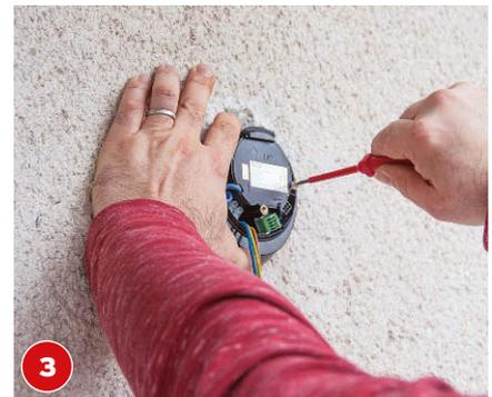
**3** Die Trägerplatte mit den zum Lieferset gehörenden Schrauben festschrauben.
