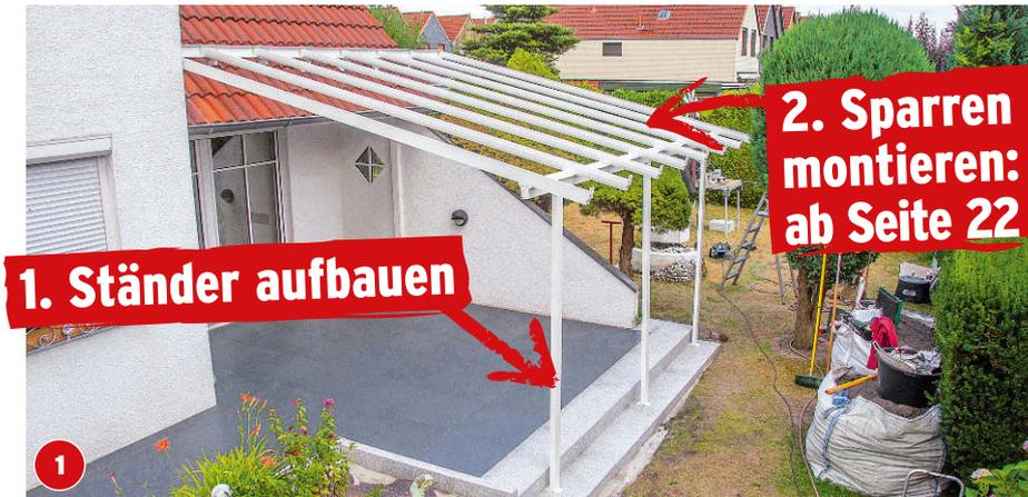
So sehen unsere ersten Schritte aus: Die montierte Sparrenhalterung am Dach und die Bodenstützen halten die Sparren. Die Stützen müssen wir fest verankern und die Sparren gerade ausrichten.
