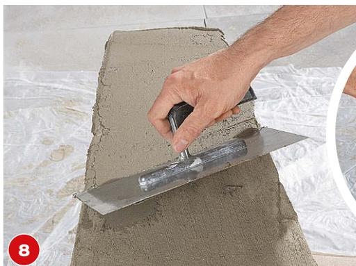
8 Nach dem Eintrocknen eine zweite Schicht Putz mit der Glättkelle aufbringen und mit einem Schwammbrett in leicht kreisenden Bewegungen glätten.
