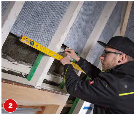
2 Zuerst die neuen Fenstermaße an den Sparren markieren. Tipp: mit Wasserwaage auf die anderen Sparren übertragen.
