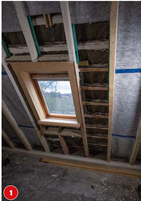
1 Das alte Dachfenster war nur eine Luke. Für den späteren Dachausbau muss zuerst ein größeres Fenster her.
