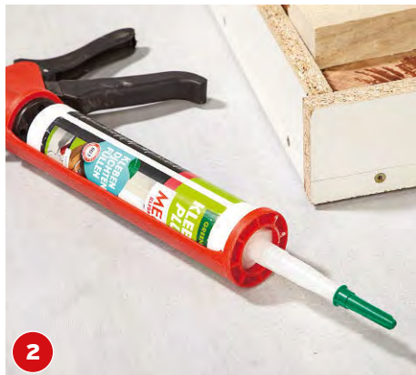
2 Alle Fugen des Gussrahmens mit Silikon abdichten. Die Qualität des Silikons ist dabei nicht entscheidend. Sie können also selbst billiges Silikon verwenden.
