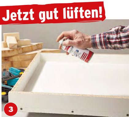
3 Die Form gründlich entstauben und großzügig mit Teflonspray als Trennmittel einsprühen. Sorgen Sie für eine gute Belüftung.
