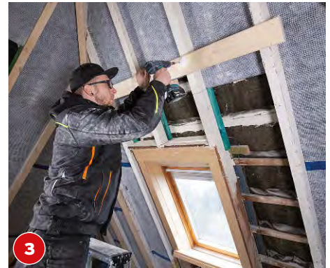
3 Ein Holzbrett sichert die oberen Sparrenden, bevor wir das Fenster ausbauen und die Sparren abgesägt.
