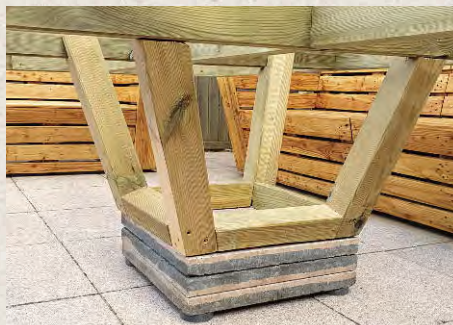
Anstelle von vier Füßen trägt eine zentrale Sockelkonstruktion die Last der Tischplatte
