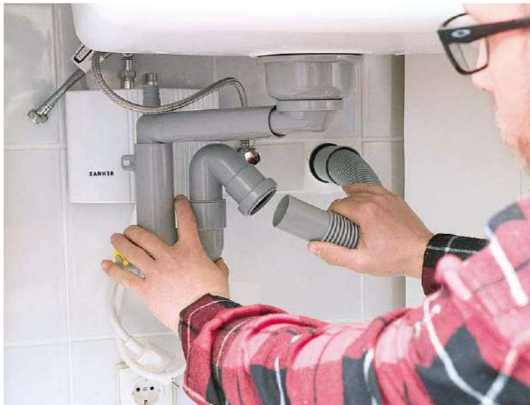
Waschbecken und Durchlauferhitzer einbauen
