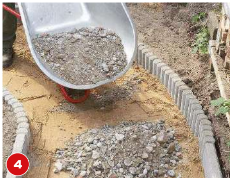
4 Als Mittelschicht wird ein Mineralgemisch mit der Körnung 16/32 etwa 7 bis 10 cm hoch auf der Wegefläche verteilt.
