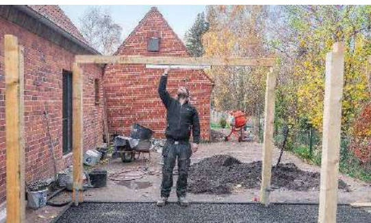
An der querliegenden Dachsparre lässt sich gleich erkennen, ob ein Pfosten zu hoch oder zu niedrig ist
