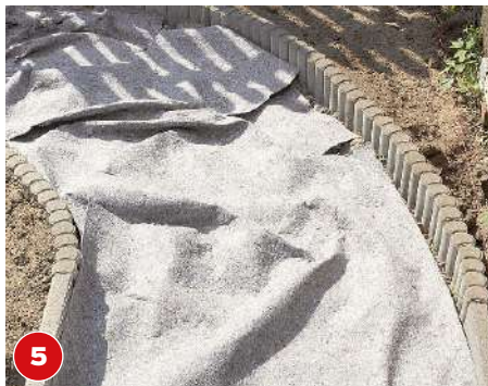
5 Eine Lage Gartenvlies zwischen Mittel- und Oberschicht verhindert, dass Gras und Kräuter durch den Kies wachsen.
