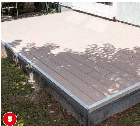
5 Im „wilden Verbund“ fallen die Dehnungsfugen an den Stößen kaum auf. Optional: Dielenkanten anfasen.
