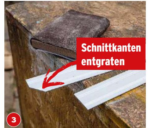
3 Die Abschlussprofile an den Ecken mit einem 45°-Gehrungsschnitt anpassen und entgraten.
