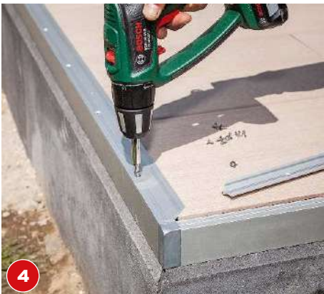
4 Die Profile über den Rahmen und die Abschlussdiele schrauben. So sitzt die Diele fest und kann nicht verrutschen.
