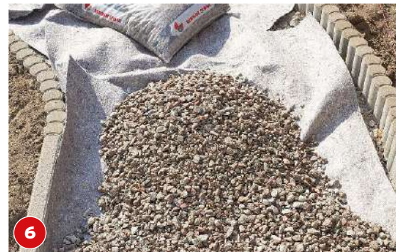
6 Zuletzt füllt man den Kiesbelag in entsprechender Farbe und Form bis etwas unterhalb der Rasensteinkanten ein.
