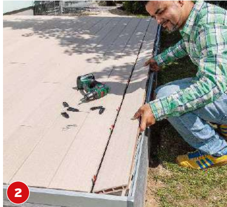
2 Die hinten überstehenden Enden der clipmaster kürzen, die Spitzen unter die Diele schieben.
