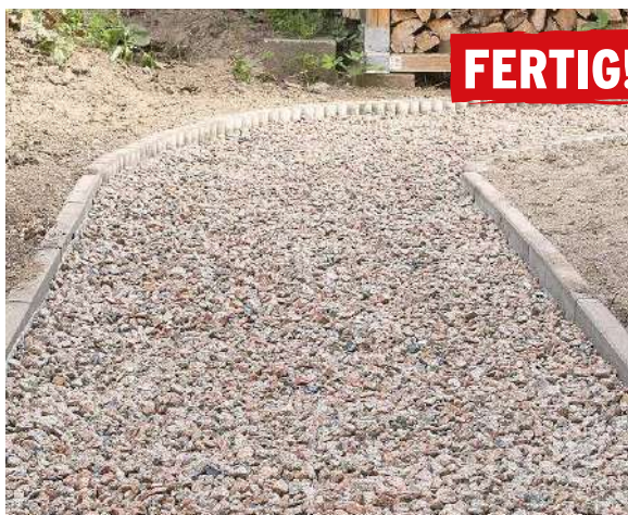
Der fertige Kiesweg hat den Vorteil, dass sich keine Pfützen auf der Oberfläche bilden, da Regenwasser selbst bei starkem Regenfall abfließen kann.
