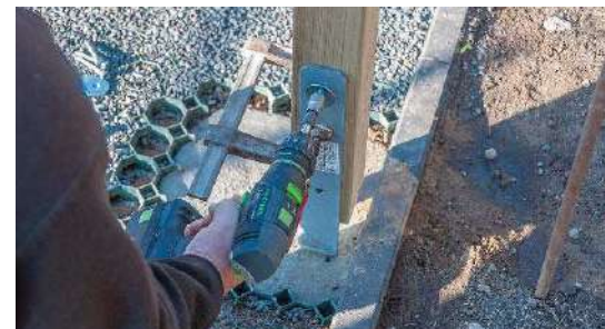
Wenn die Seitenbalken angebracht sind, können auch die Standpfosten an den H-Pfostenträgern befestigt werden
