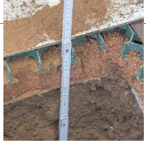
Das Loch für das Fundament sollte mindestens 80 cm tief sein. So ist das Betonfundament vor Frostschäden geschützt
