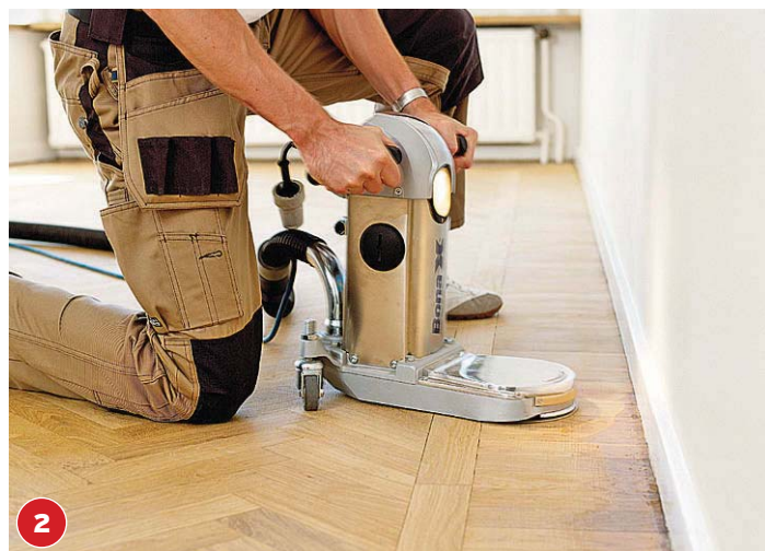
Mit dem Randschneider über die Randbereiche gehen. Damit kommt man auch unter Heizkörper. Dann folgen Schleifgänge mit 80er- und 100er-Körnung mit Walze und Randschleifer.
