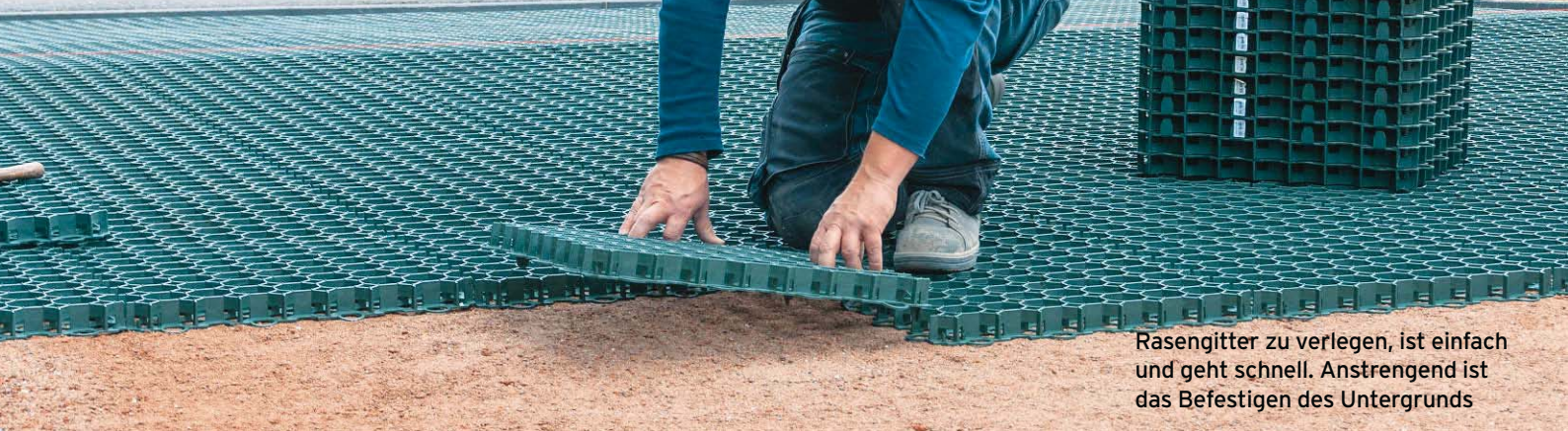
Ein Parkplatz aus Rasengitter ist robust, versiegelt aber die Fläche nicht
