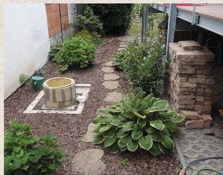
Der Ofen – ein mit Steinwolle gedämmter Blumentopf auf einem Fundament
