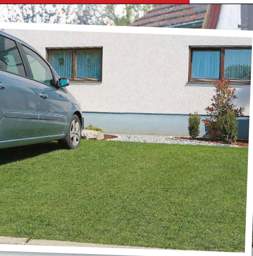
Ein Parkplatz aus Rasengitter ist robust, versiegelt aber die Fläche nicht
