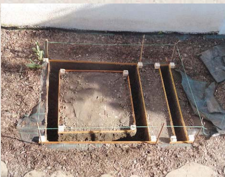
Das Streifenfundament aus Porenbeton stützt die Konstruktion aus Backsteinen
