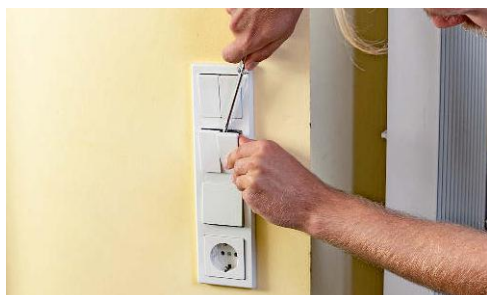
Mit einem Schlitzschraubendreher vorsichtig unter den Schalter fahren und abhebeln
