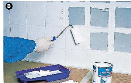
Haftgrund aufbringen und trocknen lassen. Erst Farbe, dann Klarlack auftragen.
