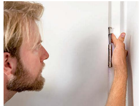
Gesonderte Distanzringe auf den Türbolzen heben das Türblatt insgesamt etwas an
