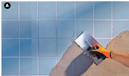
Unter zwei Schichten Feuchtraumputz lassen sich die Fliesen nicht einmal errahnen.
