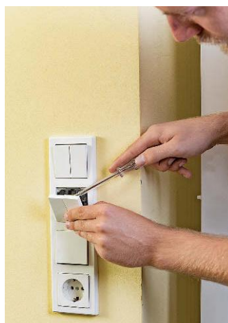
Mit einem Schlitzschraubendreher vorsichtig unter den Schalter fahren und abhebeln
