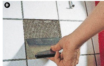
Mit einem Zahnspatel neuen Fliesenkleber auftragen und die Fliese einkleben.
