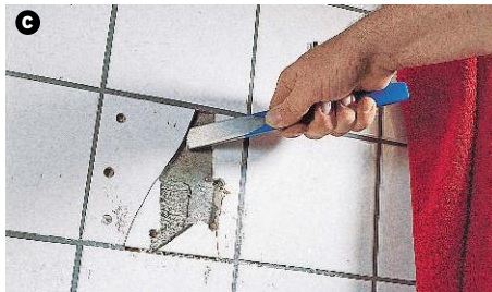
Die Bruchstücke der angebohrten Fliese sowie Fliesenkleberreste entfernen.
