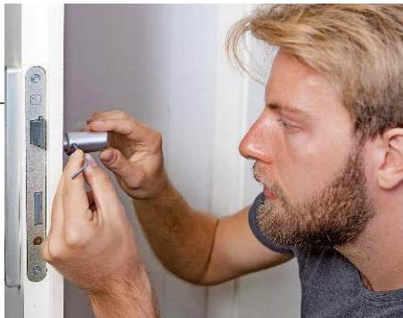
Mit dem Inbusschlüssel die Schraube am Griff (seitlich oder unten) festziehen
