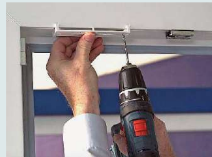
Den Fensterfalz-Lüfter (meiste mehrere) schraubt man an den Fensterrahmen
