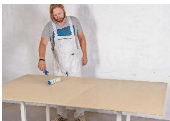
Auf die Gipskartonplatten wird vor dem Tapezieren Tiefgrund aufgetragen
