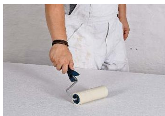
Zu guter Letzt rollen wir die Fläche und Stöße mit einem Andrückroller
