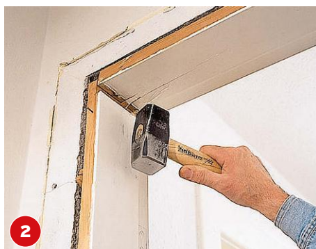
2 Mit dem Fäustel lösen Sie zunächst den Zargensturz – der ist nicht mit der Mauer verbunden. Es folgen die Laibungshölzer.
