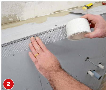
Die Plattenstöße versehen Sie mit einem selbstklebenden Armierungsband, das Risse verhindern soll.
