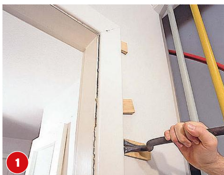
1 Die Bekleidung der alten Tür am besten mit dem Kuhfuß abhebeln. Unterlagshölzer schützen die Wand gegen Schäden.
