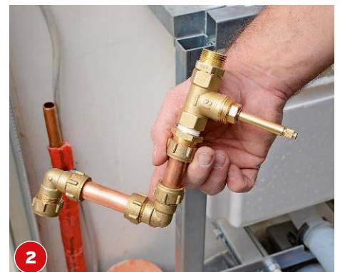
Wichtig: Bauen Sie einen Absperrhahn für die Wasserversorgung im Bad ein, den Sie später noch erreichen können.
