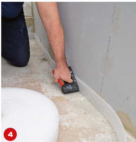
Bevor Sie den Boden mit Ausgleichsmasse nivellieren, müssen Sie ringsum einen Randdämmstreifen anbringen.
