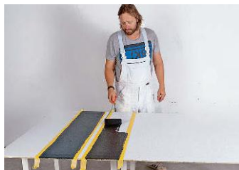
Anschließend wird der abgeteilte Bereich zweifarbig gestrichen
