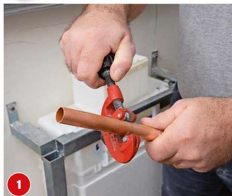
Messen Sie die nötigen Längen der Kupferrohre ab und bringen Sie sie mit einem Rohrschneider auf Länge.
