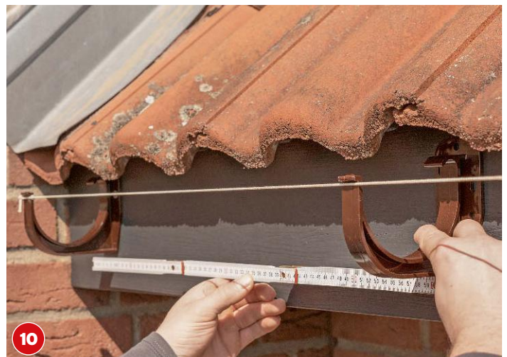
10 Die weiteren Rinnenhalter montiert man in einem Abstand von 60 cm. Dabei wird die korrekte Höhe jedes Halters mithilfe der Schnur ermittelt.
