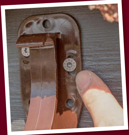
Die Rinnenhalter besitzen Langlöcher für das Nachjustieren des Gefälles
