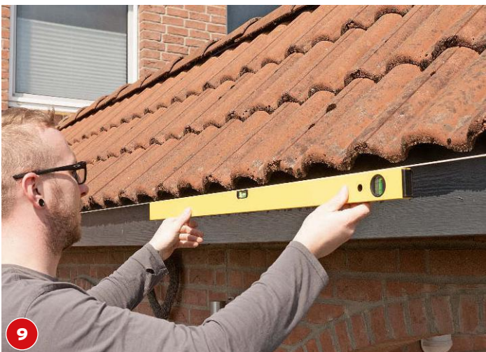
9 Das Gefälle der Schnur kontrolliert der Selbsterbauer mit einer Wasserwaage nach, um sicherzustellen, dass das Wasser später auch wirklich abfließt.
