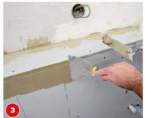
Im direkten Spritzwasserbereich spachteln Sie die Fugen mit einem flexiblen Fliesenkleber.
