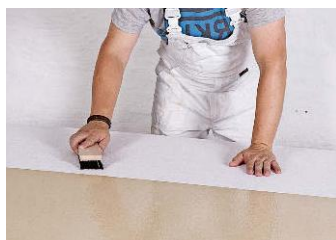
Die Tapeten werden bahweise aufgeklebt und mit einer Tapetenbürste glattgestrichen
