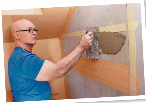
Ziehen Sie den Fliesenkleber nur in Fliesenbreite auf und kämmen Sie ihn gut durch
