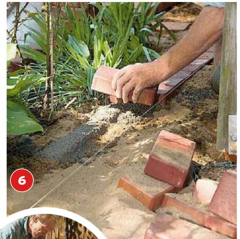
**6** Mit einem Klopffholz die verlegte Pflasterfläche eibnen (siehe Bild im Kreis). Anschließend Sand in die Fugen fegen und mit Wasser einschlämmen.
