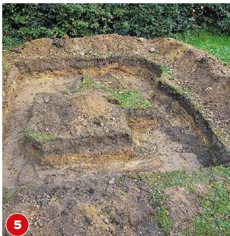
Wir haben das Loch etwa 20 cm tief ausgehoben. Die benötigte Sandmenge lässt sich leicht berechnen (LxBxT).
