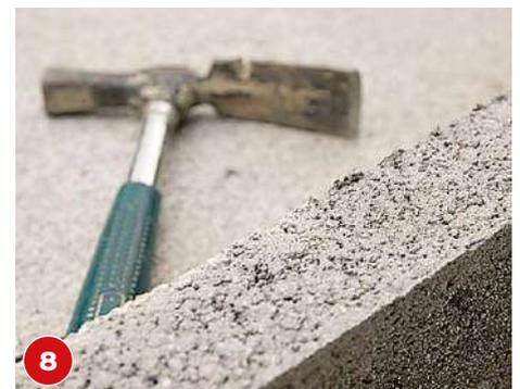
Damit die Betonstürze später sehr dicht aneinanderliegen können, werden die Überstände an den Kanten mit einem Hammer vorsichtig entfernt.
