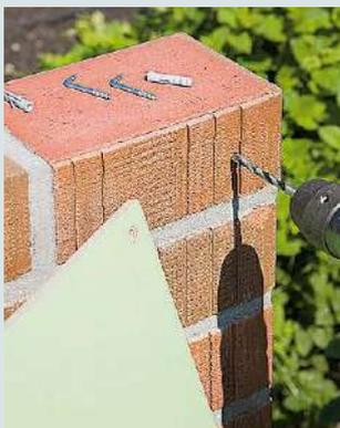
Die Löcher in den Mauersteinen werden mit einem Betonbohrer, aber ohne den Schlagmodus (Schlagbohren) hergestellt, da sonst Stücke herausbrechen können.
