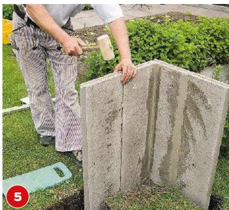
Mit einem Gummihammer werden die Rasenkanten auf eine exakte und gleichmäßige Höhe gebracht.
