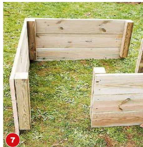
Auch die Eck-Elemente werden vormontiert, wobei die Bretter an der Ecke stumpf gestoßen werden.
