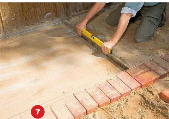
**7** Wenn die Randsteine fest liegen, kann die Terrassenfläche gepflastert werden. Dazu das verdichtete Sandbett per Richtscheit oder Brett und Wasserwaage gleichmäßig glatt abziehen. Niveauhöhe und Gefälle einhalten.
