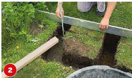
Von dem Betonestrich wird so viel eingefüllt, dass bis zur Grasnarbe 34 cm verbleiben. Mit einem Holz wird der Betonestrich noch zusätzlich verdichtet.
