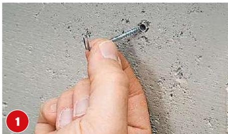
**1** Zur Befestigung der Dekorplatten und der Regalbodenaufleger werden Löcher in die Rasenkantensteine gebohrt und mit Dübeln versehen. Die Haken selbst werden erst nach dem Anstreichen eingedreht.
