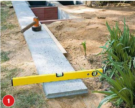
**1** Auch der Beton-Bordstein als Mähkante wird mit der Wasserwaage im Sandbett gerade ausgerichtet.
