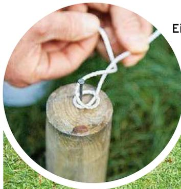
Eine einfache Doppelschlinge hält die Schnur straff gespannt. Dafür wird in jeden Pflock ein Nagel eingeschlagen
