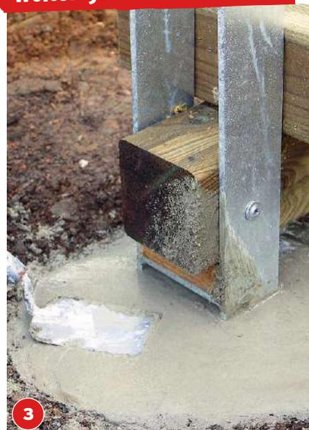
Schraubzwingen. Für die H-Anker werden 60-80 cm tiefe Löcher gegraben. Anschließend alles mit der Wasserwaage waagrecht und senkrecht ausrichten und mit Estrichbeton einbetonieren.
