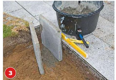
Die Gehwegplatten werden in ein kleines Betonbett gestellt und mittels Plattenhammer (kräftiger Hammer mit Gummiaufsatz) in Position gebracht.
