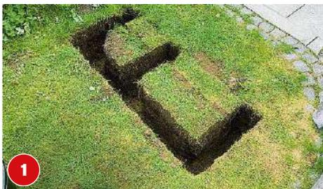
Die Rasenkantensteine stecken zu 1/3 ihrer Länge im Boden, also gut 34 cm. Schichten Sie dazu den Boden spatenbreit 40 cm tief aus.
