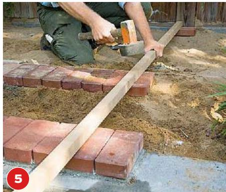
**5** Die Pflastersteine gerade von oben einsetzen. Weder kippen noch schieben, sonst leidet das Sandbett. Möglichst wenig Kreuzfugen setzen, um einen festen Verbund zu erzielen.
