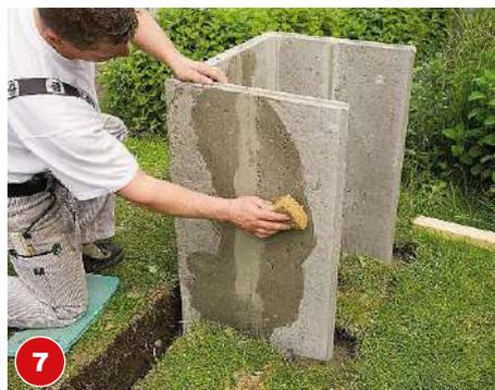
Überschüssiges Material des Fliesenklebers wird nur kurze Zeit nach dem Verkleben mit einem Schwamm und klarem Wasser abgerieben und abgewaschen.
