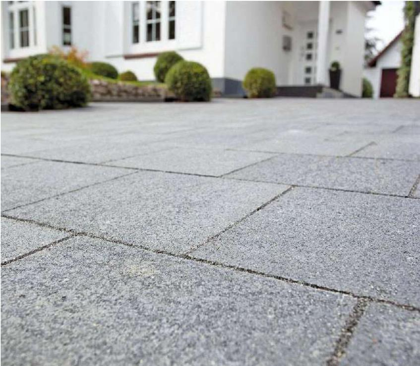
**Dichte Fugen** Die Fugen wurden mit einem Einkomponenten-Pflaster-Fugenmörtel eingeschlemmt. Der Mörtel ist nach dem Abbinden hart, fest und unkrautresistent
