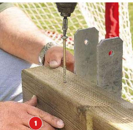
Damit die H-Anker an der richtigen Stelle und exakt senkrecht einbetoniert werden, wird zuerst aus den 90 x 90 mm starken Balken eine Konstruktion erstellt, die den Abmessungen ...
