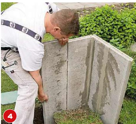
Den Betonestrich verdichten und eine Rasenkante nach der anderen aufstellen. Mit flexiblem Fliesenkleber verkleben.
