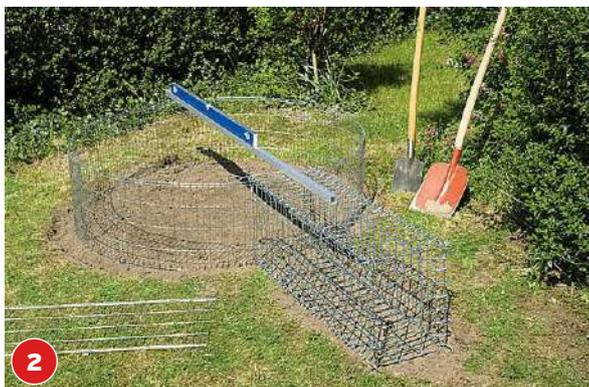
Die Fläche, auf der der Minitéich und die Bank später stehen sollen, wird von Bewuchs befreit, geebnet und mit einem Stampfer oder schweren Hammer verdichtet. Das ist notwendig, damit die Konstruktion später beim Befüllen des Beckens nicht punktuell absackt.
