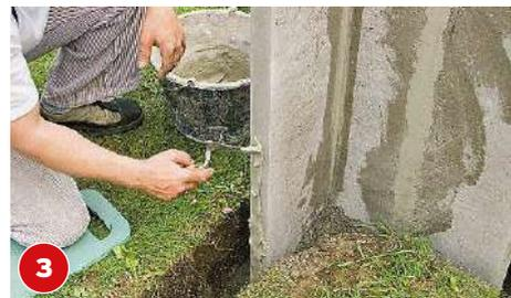
Die Rasenkantensteine auf das Betonbett stellen, mit der Wasserwaage ausrichten und seitlich mit Betonestrich bis kurz unterhalb der Grasnarbe auffüllen.
