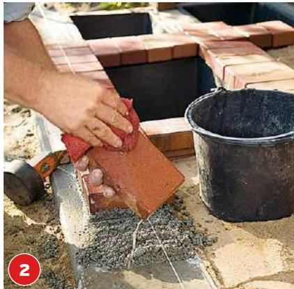
**2** Dann die Pflaster-Randsteine mit Fertigmörtel darauf verlegen. Dazu Platte und Steine anfeuchten.
