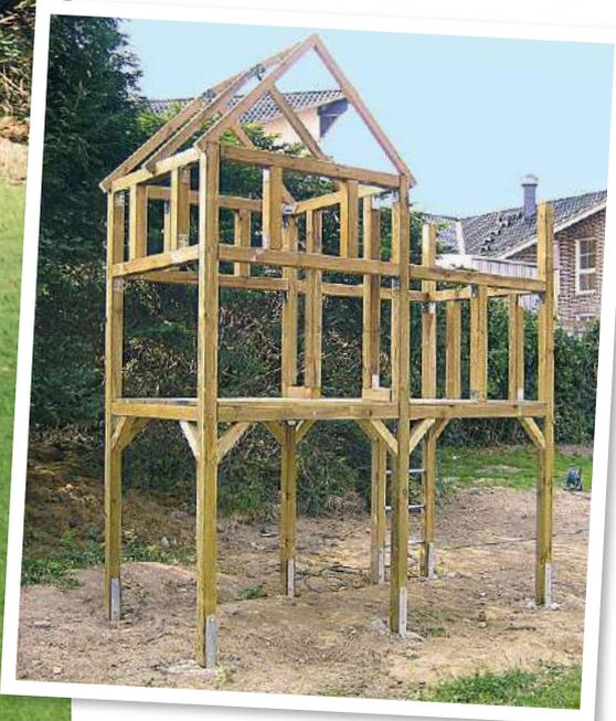
Auf Punktfundamenten mit einbetonierten H-Ständern ruht das Ständerwerk des Spielhauses
