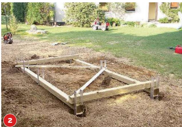
... des Ständerwerks entspricht. Dazu die Längsbalken in den H-Ankern fixieren und anschließend daran die Querbalken festschrauben. Die Konstruktion steht im rechten Winkel, wenn die Diagonalen zwischen den Innenpfosten die gleiche Länge aufweisen. Stimmt der Winkel, stabilisieren Sie die Konstruktion mit zwei Querlatten und
