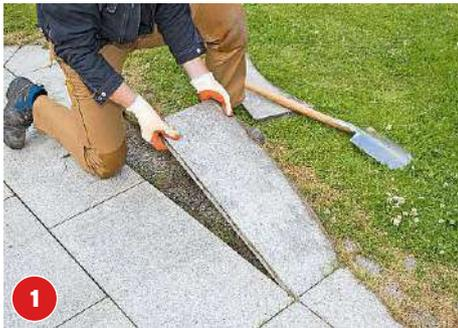
Ist die Platzierung des Teiches festgelegt, werden die Terrassenplatten mit einem Plattenheber herausgenommen oder einfach mit dem Spaten angekippt und per Hand abtransportiert.
