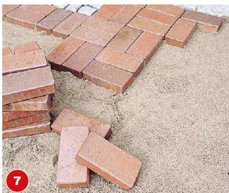
**7** Für die erste Klinkerfläche werden die Steine am Hausanschluß gegen die Randsteine gelegt. Als Muster je zwei quer und zwei lang.
