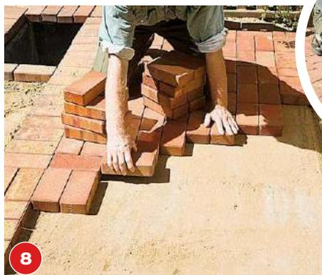
**8** Die Pflastersteine gerade von oben einsetzen. Weder kippen noch schieben, sonst leidet das Sandbett. Möglichst wenig Kreuzfugen setzen, um einen festen Verbund zu erzielen.
