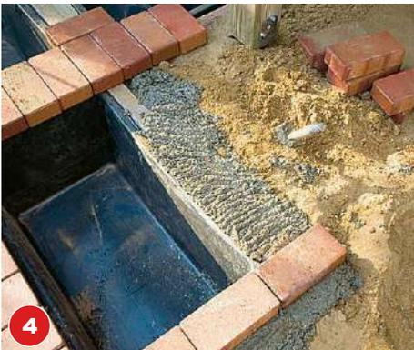
**4** Alle Klinker, die nicht im Verband liegen, werden mit Mörtel festgesetzt. Ausnahme: der Steg auf den schmalen Kanten zwischen den Becken. Immer Richtung und Gefälle überprüfen.
