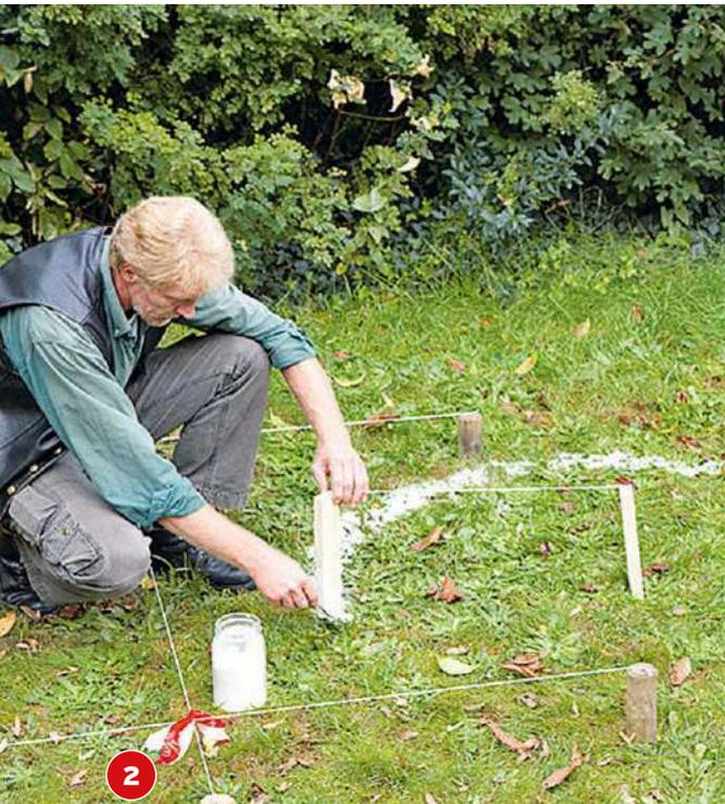
Der runde Sandkastenteil wird markiert, indem man im Mittelpunkt einen Pflock setzt, von dort in der Länge des Radius eine Schnur spannt und am anderen Ende eine sandgefüllte Tüte hält, der eine untere Ecke abgeschnitten wurde.
