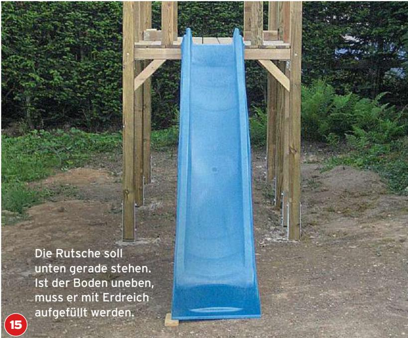
Die Rutsche soll unten gerade stehen. Ist der Boden uneben, muss er mit Erdreich aufgefüllt werden.
