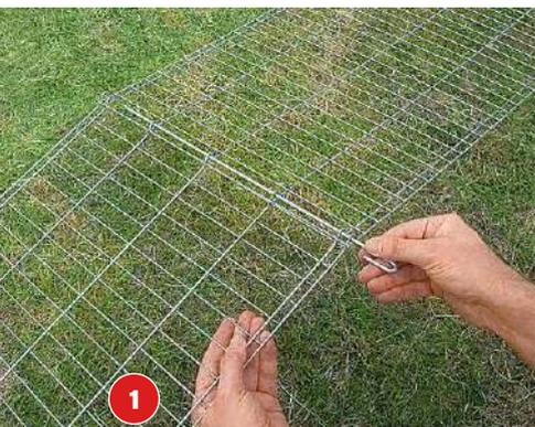
Die in Teilen angelieferten Gabionen werden mittels Spannankern untereinander verbunden, aufgestellt und anschließend der genaue Standort markiert.
