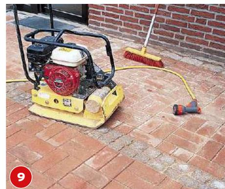
**9** Wenn der Vorplatz am Haus fertig ausgelegt ist, wird feiner Fugensand eingekehrt. Dann wird mit dem Rüttler die Fläche verdichtet.
