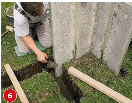
Das seitliche Auffüllen mit dem Betonestrich erfolgt stets, wenn eine Rasenkante ausgerichtet ist.
