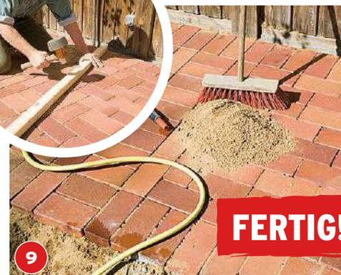
**9** Mit einem Klopffholz die verlegte Pflasterfläche eibnen (siehe Bild im Kreis). Anschließend Sand in die Fugen fegen und mit Wasser einschlämmen.
