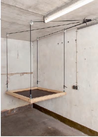
Bereit zum Beladen: Mit den stabilen Befestigungen trägt die Regalplattform locker 30 kg.
