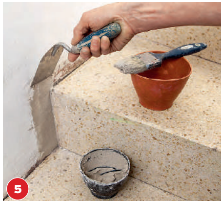
5 Die Spachtelmasse nach Herstellerangabe mit Wasser anrühren. Mit dem Spachtel auftragen und glätten.
