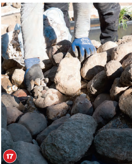
17 Auch am Rand eignen sich partiell gestreute Kiesel hervorragend, um eine realistische Struktur zu schaffen.
