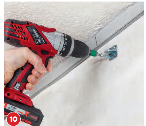
10 Die Ösenplatte für den Flaschenzug verschrauben Sie mit 4 x 40 mm großen Halbrundkopfschrauben.
