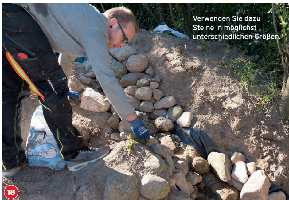
15 Im Bachlauf selbst können Sie mit unterschiedlich großen Steinen das Fließen des Wassers beeinflussen.
