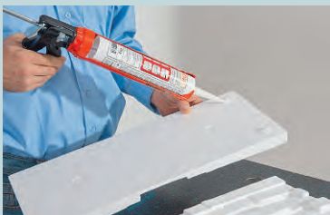
Die einzelnen Paneel-Elemente werden mit Styropor- oder Universalkleber versehen und ...
