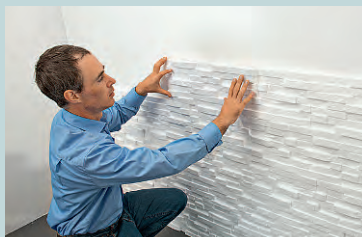
... von Hand an der Wand angebracht. Feste drücken. Jetzt nur noch farbig streichen. Fertig!
