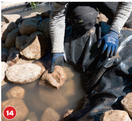
14 Das obere Becken wird anschließend mit Feldsteinen verkleidet, bis keine Teichfolie mehr zu sehen ist.
