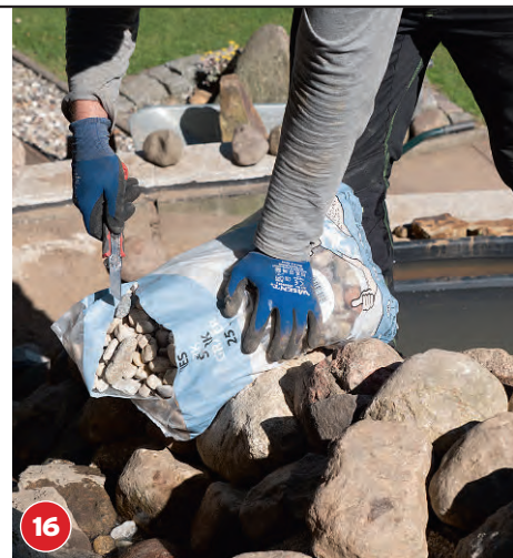
16 Für ein natürliches Gesamtbild verteilen Sie Kiesel im Bachlauf. Diese bedecken auch den letzten Fleck Teichfolie.
