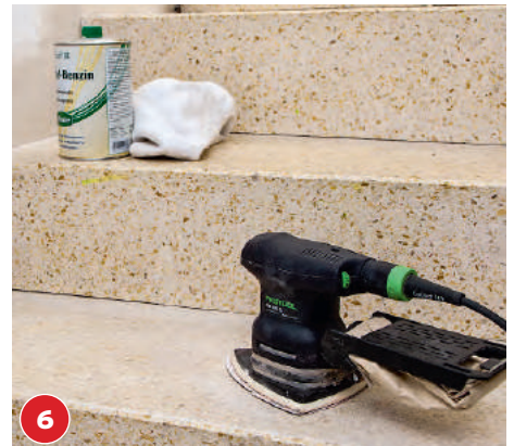
6 Die Oberflächen und Ecken der Setz- und Trittstufen anschleifen, entstauben und mit Reinigungsbenzin säubern.
