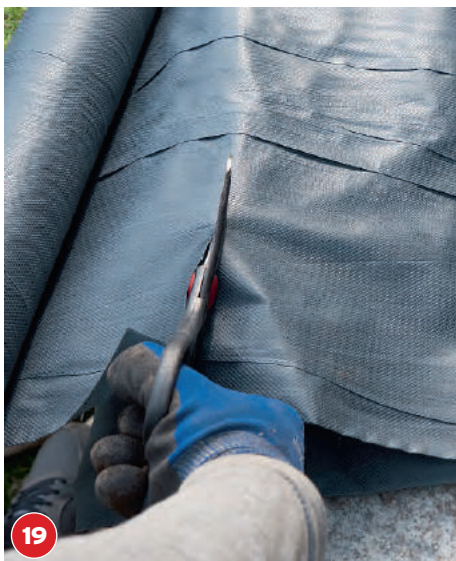
19 Schneiden Sie ein etwa 1 m 2 großes Stück Unkrautfließ zurecht, um den Aufstellort des Durchlauffilters damit abzudecken.
