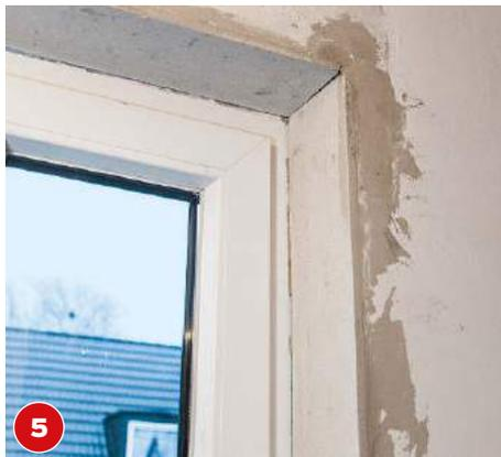
**5** Faserzementplatten verbergen die zuvor an der Mauerlaibung noch sichtbaren, verdübelten Eindrehanker.
