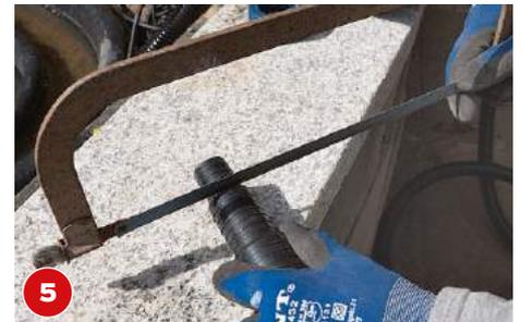
5 Jetzt wird es Zeit für die Vorbereitung der Technik. Sägen Sie den Schlauchadapter auf den richtigen Durchmesser.
