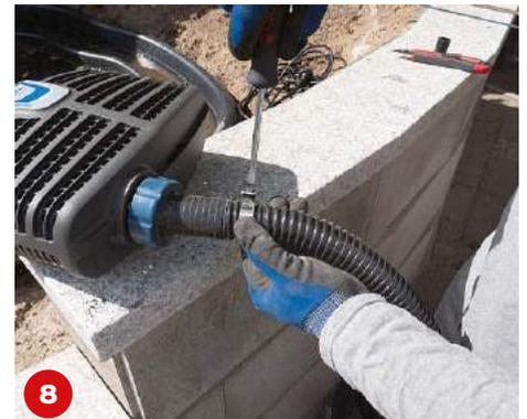
8 Ziehen Sie die Schlauchschelle nicht zu fest an, damit der Kunststoffadapter nicht bricht oder der Schlauch einreißt.
