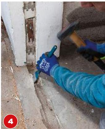
**4** Schaum, Mörtel und Silikon möglichst vollständig aus den Türfugen entfernen.
