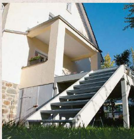
Die Treppe wurde aus einzelnen Elementen zusammengebaut und mit Rispnbändern am Balkon befestigt
