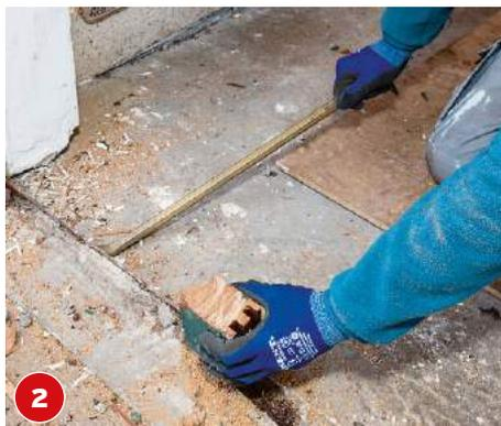
**2** Nachdem die Türschwelle gelockert ist, lässt sich auch das untere Profil des Rahmens herausheben und entfernen.
