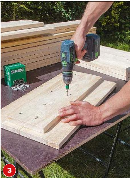
**3** Die Elemente des Innenkorpus werden mithilfe der aufgeschraubten (4,5 x 40 mm) Verbindungsbrettern montiert.
