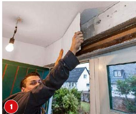
1 Entfernen sie alle störenden Verkleidungsteile, die beim Ausbau des Türrahmens im Weg sind.
