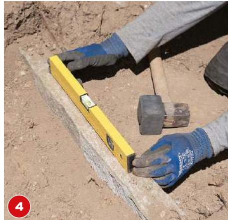
4 Damit das Wasser nicht zu sehr aus der Bahn läuft, sollten die Stufen waagrecht sein. Korrigieren Sie bei Bedarf.
