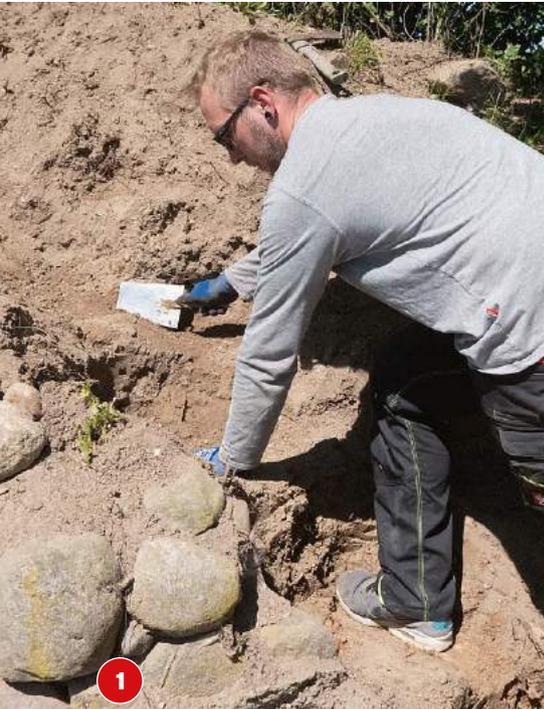
1 Bereiten Sie die Stufen für den Bachlauf vor, indem Sie längs zur Flussrichtung kleine Gräben anlegen.
