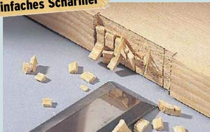
Die Position des Beschlags anzeichnen und das Material bis auf die richtige Tiefe glatt abtragen (Stechbeitel).
