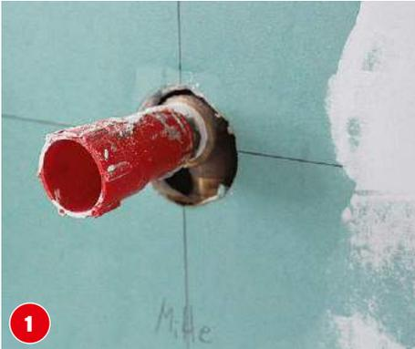
Während der Bauphase sind die Wasseranschlüsse mit Baustopfen verschlossen, vor dem Herausdrehen Wasser abstellen!
