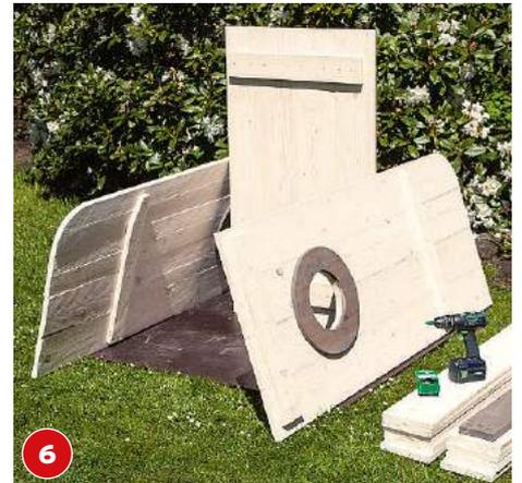
**6** Jetzt sind die beiden Wände, die Rückwand und der Deckel des Außenkorpus bereit, verbunden zu werden.
