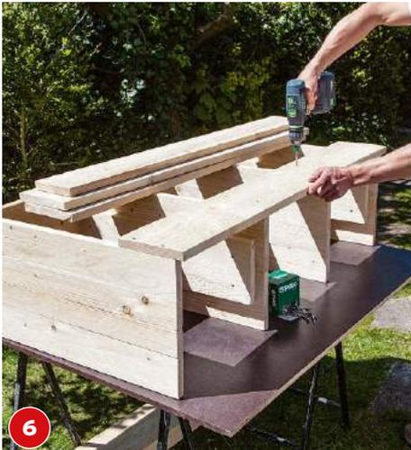
**6** Vor dem Verschrauben der Bretter als Deckel und Boden die Länge einmessen, zusägen, schleifen und streichen.
