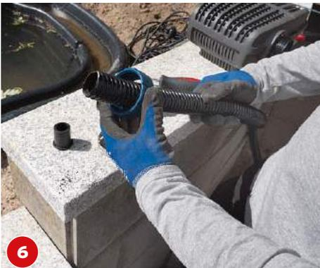
6 Führen Sie anschließend Schlauchschelle und Schraubmuffe über den Schlauch zurück und stecken ihn auf die Pumpe.
