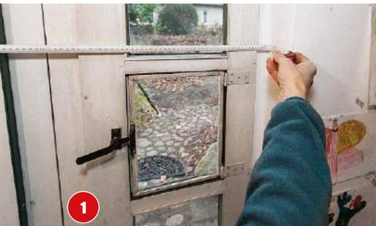
1 Mit dem Maßband bestimmen Sie die Breite der Maueröffnung. Von dieser ziehen Sie die benötigte Einbauluft ab.
