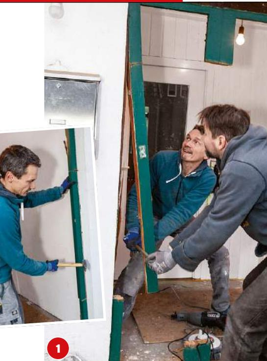
**1** Lockern Sie den Rahmen zunächst mit einem Hammer und lösen Sie ihn dann mit einem Brecheisen von der Wand.
