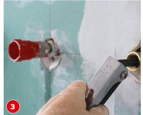
Je nach Armatur endet der Anschluß bündig mit oder knapp vor der fertigen Wandfläche. Mit dem Innensechskant eindrehen.
