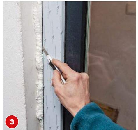
**3** Nach dem Aushärten wird der überschüssige Schaum mit einem Cutter bündig am Rahmen abgeschnitten.
