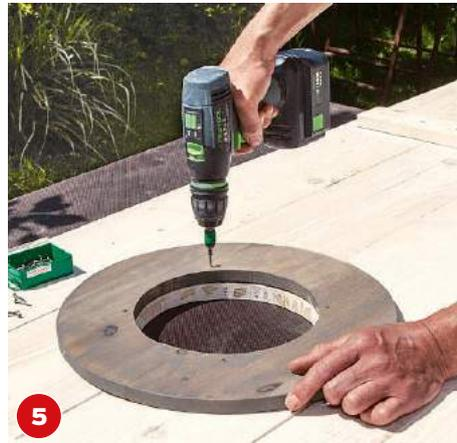
**5** Als Aufdopplung und optischen Akzent schrauben Sie (3 x 25) die Holzringe an die Innenseite des Bullauges.
