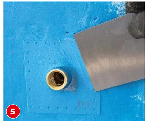
**3** Die Dichtmanschette soll an dem durchdringenden Objekt umlaufend mindestens drei Millimeter anliegen.
