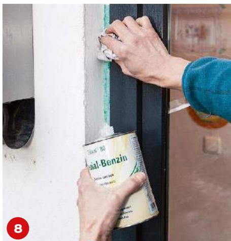
**8** Vor dem Auftrag des Klebers muss man die Haftfläche unter den Dekorleisten mit Waschbenzin fettfrei reinigen.
