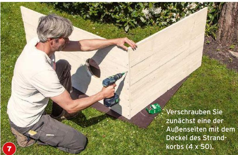
**7** Verschrauben Sie zunächst eine der Außenseiten mit dem Deckel des Strandkorbs (4 x 50).
