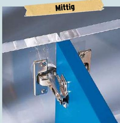
Zwischen den Türblättern bleibt zum Öffnen der Türen eine Fuge, das Scharnier ist leicht gekröpft
