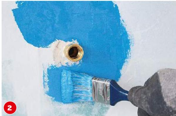
**1** Im Bereich um die Messingverlängerung wird mit Rolle, Spachtel oder Pinsel Dichtmasse auf die Gipskartonfläche aufgetragen. Die Beschichtung gleichmäßig und deckend ohne Fehlstellen verteilen.
