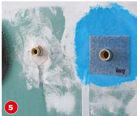
Die Dichtmanschetten des Systems schützen den Bereich rund um die halbzölligen Rohrverlängerungen.
