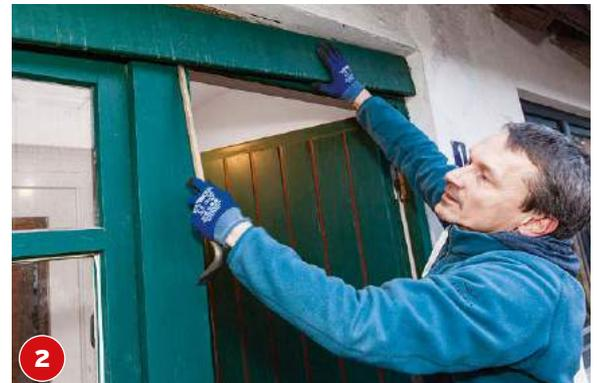
2 An der Außenseite hebeln Sie mit einer Brechstange die Verkleidungsbretter oberhalb der Tür Stück für Stück lose und heben diese von der Wand ab.
