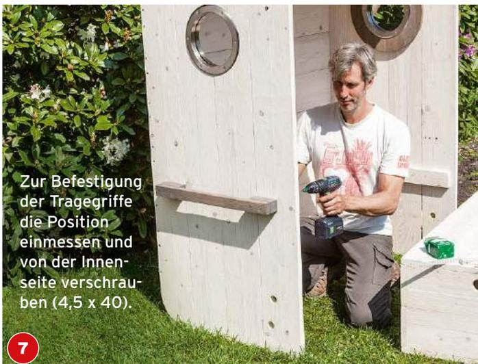
**7** Zur Befestigung der Tragegriffe die Position einmessen und von der Innenseite verschrauben (4,5 x 40).
