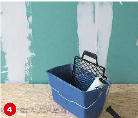
Nach dem Spachteln und Schließen der Fugen mit kurzfloriger Rolle die Flächen grundieren, etwa mit Knauf Spezial-Haftgrund.
