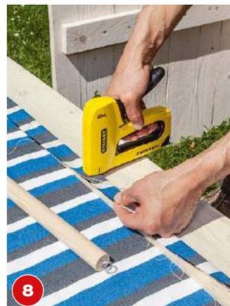
**8** Markisenstoff an der Befestigungsleiste festtackern und Ösen am Rundstab eindrehen.
