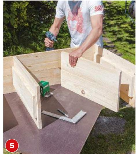
**5** Dann messen Sie die Position der beiden Mittelwände ein, bevor Sie diese ebenfalls an der Rückwand verschrauben.
