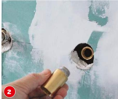
Messingverlängerungen mit halbzölligem Gewinde, in Längen ab 10 bis 100 mm, mit Hanf und Dichtpaste versehen.
