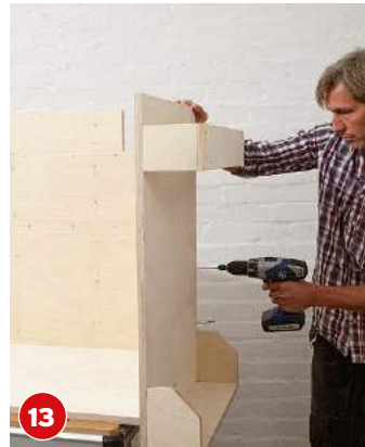
13 Durch das Verschrauben der Rückwand mit Seite und Boden steht der Tisch im Winkel.
