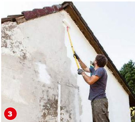
3 Die verdünnte Fassadenfarbe mit einer Rolle für Fassadenfarbe vorstreichen. Den Voranstrich gut durchtrocknen lassen.
