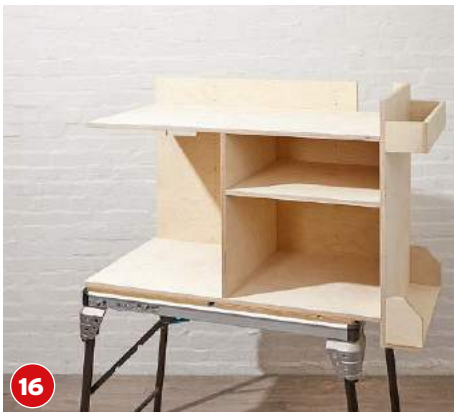
16 Der Zwischenboden muss zwingend parallel zur Oberkante der Rückwand verlaufen, sonst schließt die Tür später nicht.
