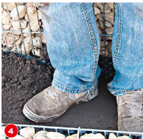
4 Mit jeder Lage muss, zum gleichmäßigen Setzen, die Erde verdichtet werden. So verhindert man ein späteres Absacken.
