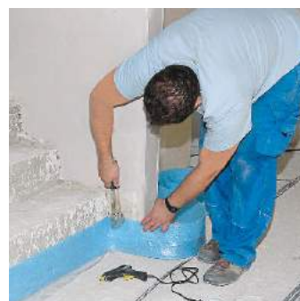
1. Im ersten Schritt den Randdämmstreifen umlaufend im ganzen Raum befestigen.
