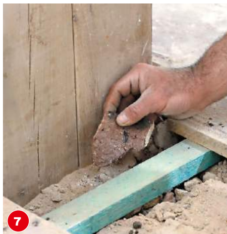
7 Der Hohlraum unter den Latten kann mit den Stein- und Mörtelresten und etwas Estrichbeton gefüllt werden.
