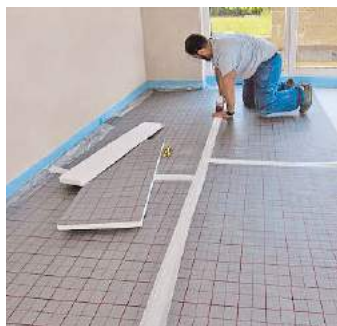
3. Als Nächstes die Tacker-Systemplatten verlegen und an den Plattenstößen verkleben.
