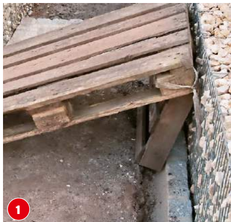
1 Zum leichteren Einbringen des Oberbodens mit der Schubkarre haben wir uns eine Rampe aus zwei Paletten gebaut.
