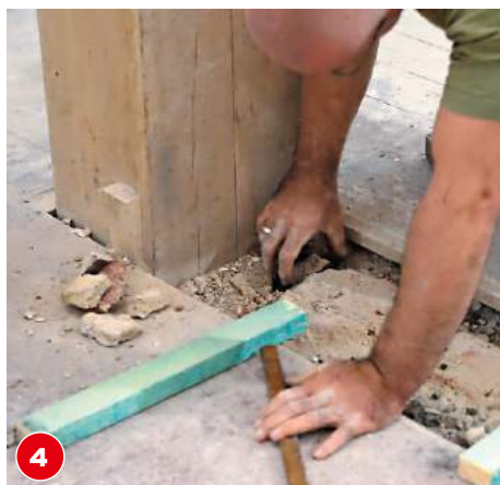
4 Den freigestemmen Bereich von größeren Brocken freiräumen, auch etwa 10 cm weit unter den alten Dielen.
