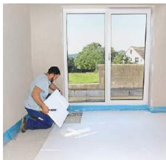
2. Die Zusatzdämmung passgenau zuschneiden und auf sauberem Untergrund verlegen.
