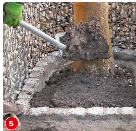
5 Auch das kleine Beet am Baumstamm wird mit Erde aufgefüllt bis der Stützkell der Pflastersteine verdeckt ist.
