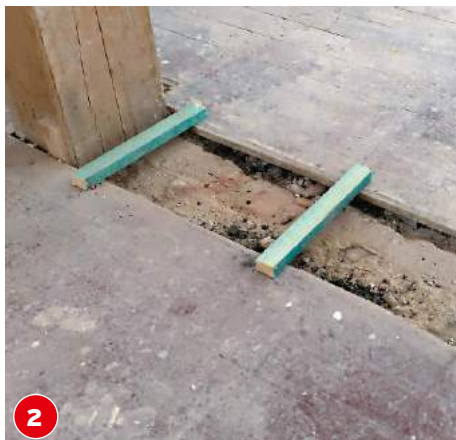
2 Als Tragkonstruktion dienen alte Dachlatten, die an den beiden Enden jeweils etwa 5–6 cm länger sind.
