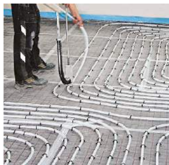
4. Beginnend am Heizkreisverteiler, die Heizrohre auf den Systemplatten fixieren.
