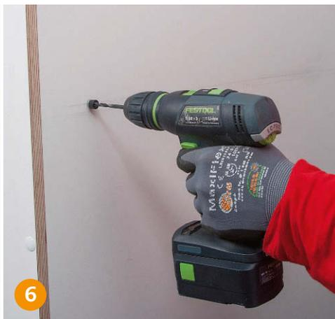
An der gewünschter Regalhöhe bohren Sie an der Seitenwand des Korpus Löcher in entsprechender Tiefe für die Einschraubdübel.
