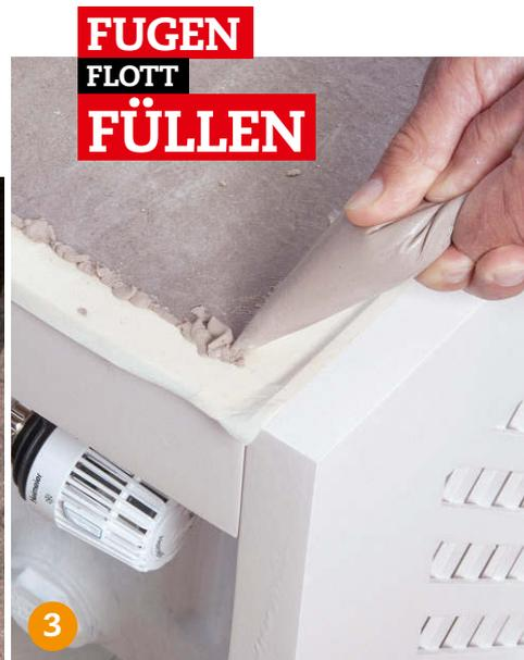
**Die gereifte Masse** bringt man mithilfe einer Spritztüte in die schmalen Fugen ein. Dabei ist eine nicht zu feste Konsistenz von Vorteil.
