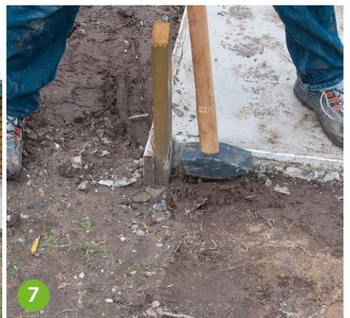
**Nach einer Trocknungszeit** von etwa zwei bis drei Tagen können Sie die Folie und Schalung entfernen.
