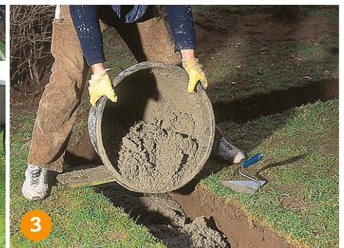
**3** Die Fundamentfläche schichtweise mit frisch angemischtem Beton aus der Mörtelbutt auffüllen.
