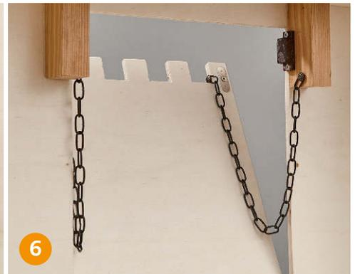
**6** Ein Magnetschnapper hält die Zugbrücke geschlossen. Zum Öffnen des Fachs einfach zwischen die Zinnen greifen und leicht ziehen.
