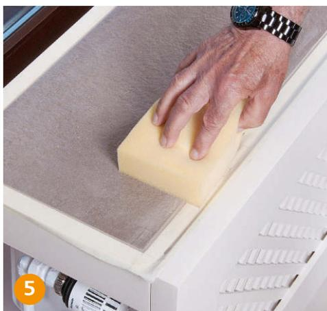
**Die Reinigung** erst vornehmen, wenn der Fugenmörtel angetrocknet ist. Verwenden Sie wenig Wasser, sonst waschen Sie die Fugen aus.
