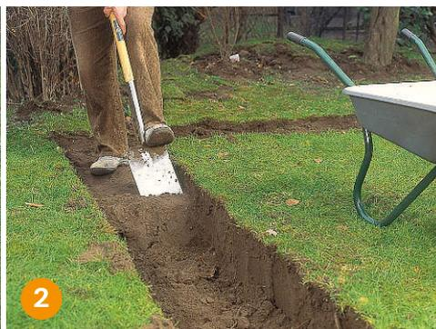
**2** Den Fundamentgraben 80 cm tief entlang der Schnur ausheben. Bei kleinen Mauern reichen auch 40 cm mit einer Drainageschicht aus Kies.
