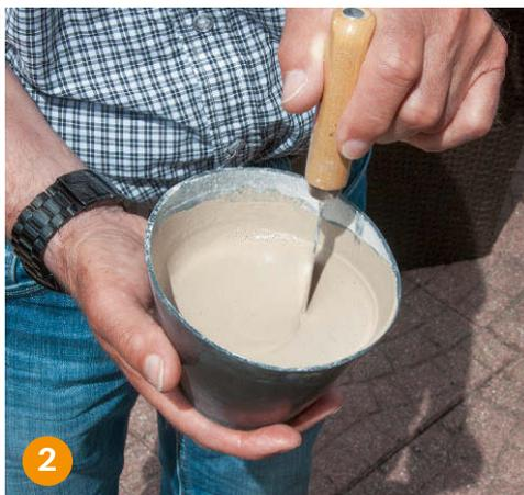
**Für die Verfugung** rühren Sie Fugenmörtel nach Herstellerangabe an. Wir wählen Deko-Flex-fugenmörtel von Knauf (5 kg etwa 15 Euro).
