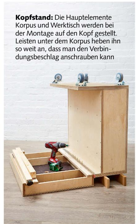
**Kopfstand:** Die Hauptelemente Korpus und Werkttisch werden bei der Montage auf den Kopf gestellt. Leisten unter dem Korpus heben ihn so weit an, dass man den Verbindungsbeschlag anschrauben kann
