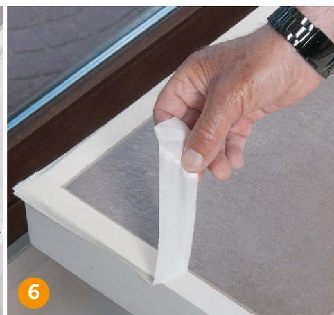
**Zum Schluss** wird nach dem Trocknen noch das Klebeband entfernt. Dann waschen Sie zur Sicherheit noch einmal nach.
