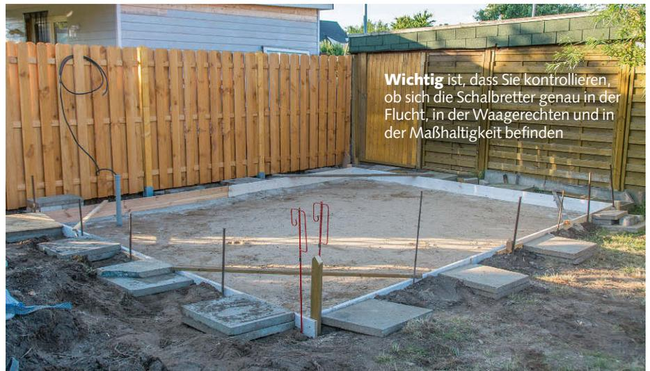
**Wichtig** ist, dass Sie kontrollieren, ob sich die Schalbretter genau in der Flucht, in der Waagerechten und in der Maßhaltigkeit befinden
