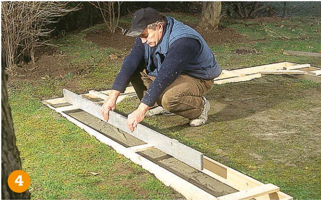
**Ist der Graben fast gefüllt**, wird die Fundamentalschalung eingesetzt und mit der Waage ausgerichtet. Sie sollte nicht unter Bodenniveau liegen.
