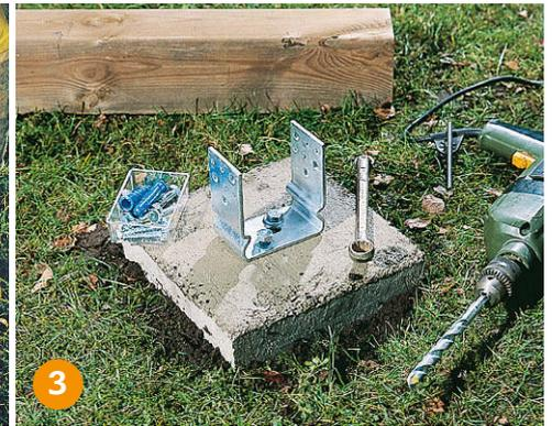
**3** Stützschuhe befestigen Sie mit verzinkten Schlüsselschrauben und Dübeln auf dem ausgehärteten Betonfundament. Das Fundament braucht fünf bis sieben Tage zum Abbinden.
