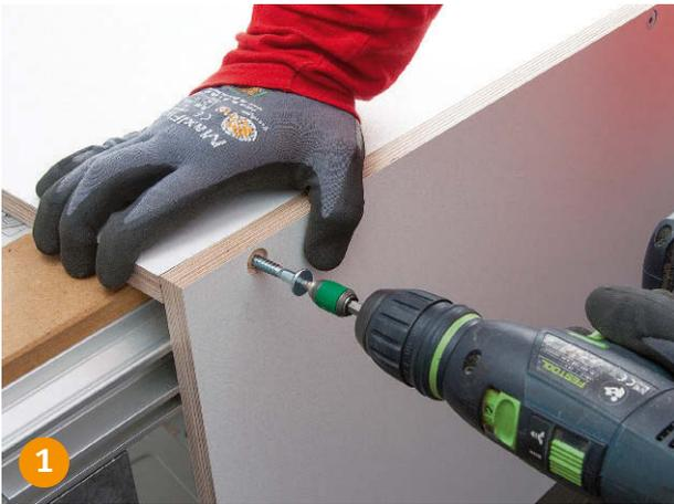
Mit einem Akkuschrauber können Sie dann die Schrauben eindrehen. Die ersten Korpussteile sind damit schon zum Aufstellen bereit (siehe Bild rechts).
