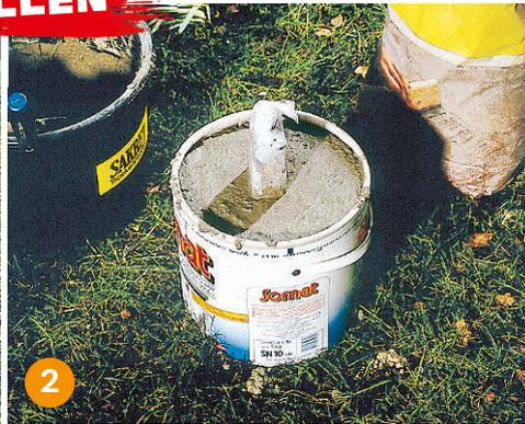
**2** Sockel können Sie in einem Plastikeimer gießen, den Sie als verlorene Schalung mit eingraben. Die Leiste wird später herausgezogen. Sie formt das Loch für die Döle.
