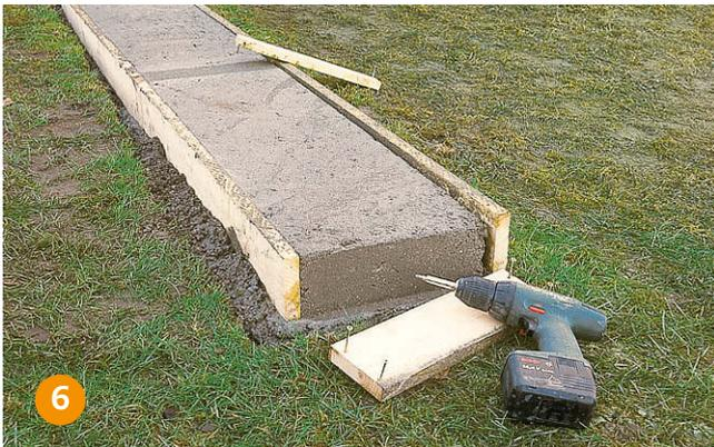
**Nach dem Abbinden des Betons** das Fundament ausschalen, möglichst ohne dass die Kanten des Betons brechen.
