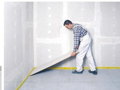
Ist keine Kellerdeckendämmung von unten möglich, können Sie Ihren fußkalten Boden auch von oben dämmen. Mit einer sogenannten Schüttung ist das am einfachsten. Das Schüttmaterial ist Perlit, ein hochwärmedämmendes, wasserabweisendes, nicht brennbares, unverrottbares und druckbelastbares Gestein. Die zuvor auszulegenden Wabenplatten erhöhen diese Druckbelastbarkeit und sichern zugleich eine gleichmäßige Schütthöhe. Diese Dämmart macht es allerdings eventuell nötig, Türen und Zargen zu kürzen.
