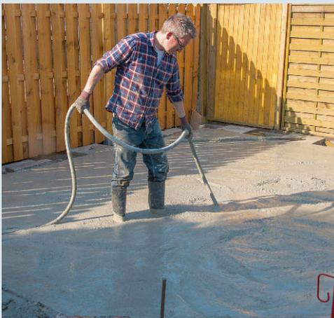
**Nur steifer und plastischer Beton** lässt sich noch bis zum Faktor 1,45 verdichten. Fließfähiger Beton wird gerüttelt, damit Luftblasen entweichen
