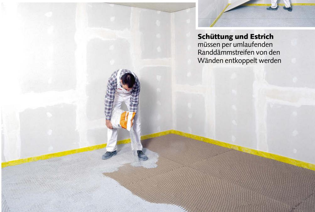
**Schüttung und Estrich** müssen per umlaufenden Randdämmstreifen von den Wänden entkoppelt werden
