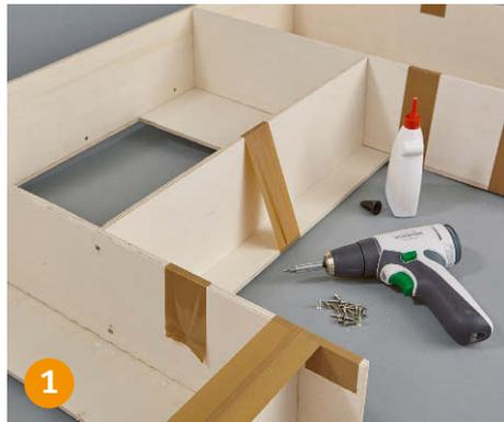
**1** Bei der Montage der Burg presst Klebeband die Leimstellen zusammen. Zusätzlich verbinden Schrauben die Bauteile.
