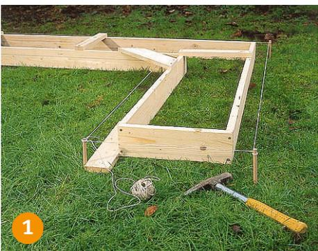
**1** Die Verschalung wird ausgelegt und ausgerichtet, die Richtschnur für den Fundamentgraben mit etwa 5 cm Abstand gespannt.
