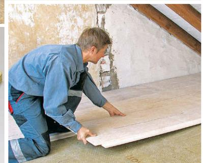
**Ein Trockenstrich** aus Gipsfaserplatten macht die druckfeste Dämmung begehbar, ohne sie zu beschädigen. Die Estrichplatten sind aber nicht für Wohnzwecke geeignet
