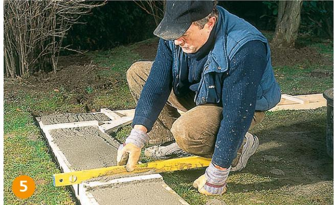
**Die Schalung** bis zur Oberkante auffüllen und verdichten. Mit Wasserwaage oder Kartätsche die Oberfläche bündig abziehen.
