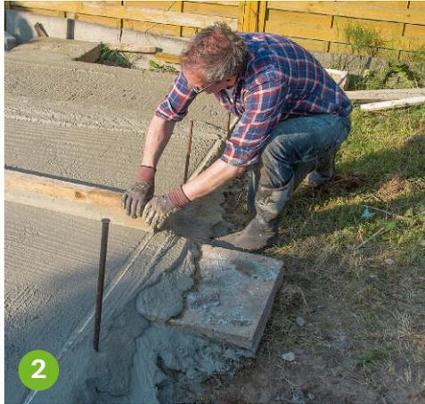
**Die diagonalen Latten** entfernen. Dann mit einem langem Brett, das breiter als das Fundament ist, den Beton waagrecht abziehen.
