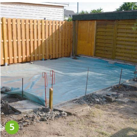
**Ist der Beton** etwas angezogen, sollte man die Oberfläche, gerade bei warmer oder frostiger Witterung, mit einer Folie abdecken.
