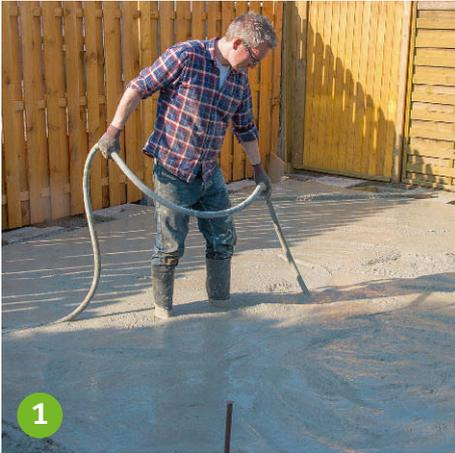
**Mit einem Betoninnenrüttler** den Beton verdichten, sobald er bis zur Oberkante der Schalung eingefüllt ist.
