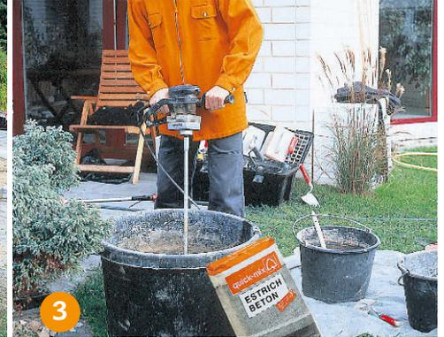
**3** Größere Mengen Beton oder Mörtel können Sie mit einer leistungsfähigen Bohrmaschine (ab 800 Watt) und einem großen Rührquirl vermischen.
