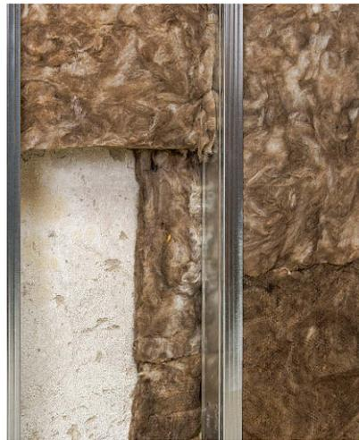
**Die Dämmmatten** müssen an der Innenwand anliegen, damit keine Luftschicht bleibt. Gedämmt wird hinter und zwischen den Ständern
