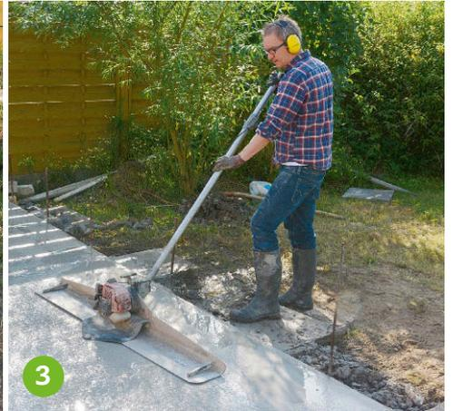
**Mit einer Rüttelplatte** die Betonoberfläche in schiebenden oder ziehenden Bewegungen verdichten und einnivellieren.
