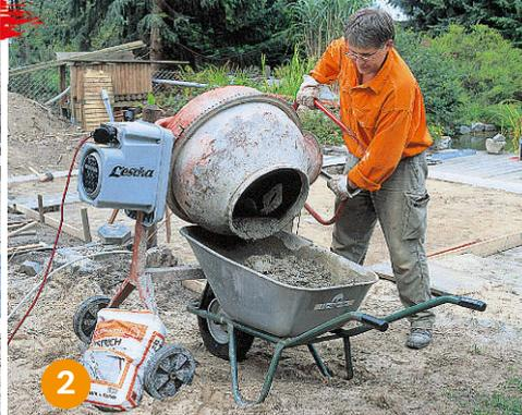
**2** Für größere Mengen Mörtel oder für grobkörnigen Beton lohnt es sich, eine Betonmischmaschine aus dem Baumarkt zu leihen.
