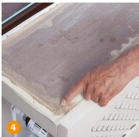
**Der Mörtel** wird daraufhin mit dem Finger in die Fuge gedrückt, um Lufteinschlüsse zu vermeiden.
