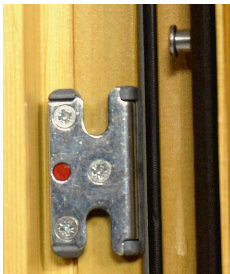
Die Kopfplatte des Pilzkopfbolzens schiebt sich bei der Verriegelung dieses Fensters nach unten, hinter die Aussparung des Schließblechs
