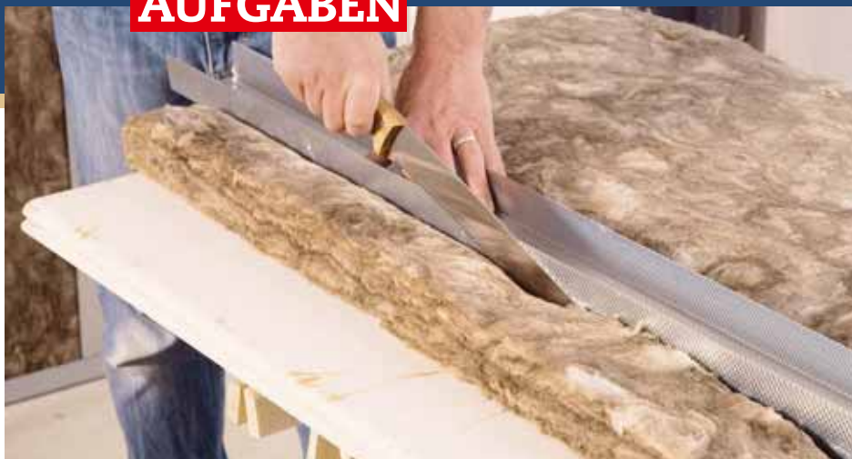
Der Zuschnitt der Dämmstoffmatten gelingt mit einem Dämmstoffmesser am besten. Nehmen Sie sich einfach ein Stück übrig gebliebenes Metallprofil als Richtschiene
