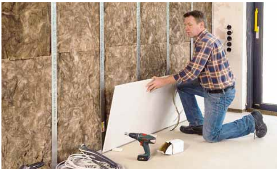
Ist die Dämmung eingebaut, beplankt man die zweiten Seite. Mit einer zweiten Gipskartonplattenlage lässt sich der Schallschutz zwischen den Räumen noch weiter steigern
