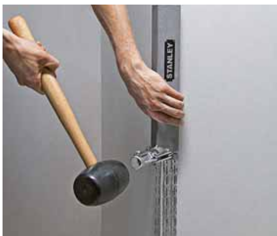
Ein Schlag reicht , um das weiche Profil so zu verbiegen, dass es sich im Gipskarton verkrallt
