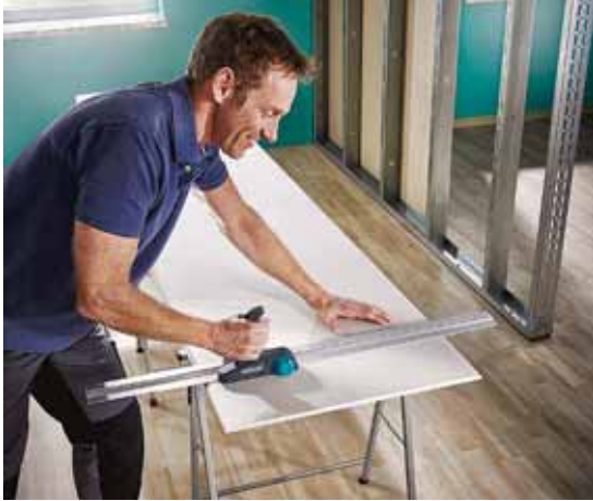
Die exakte Führung des Messers ist an der Schiene keine Herausforderung mehr
