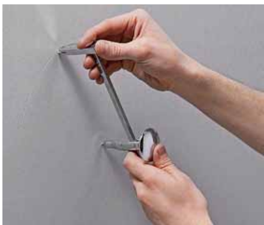
Wie beim normalen Zuschnitt ritzt man den oberen Karton an. Dazu mehrmals einen Kreis schlagen
