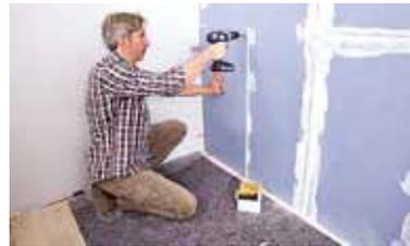
**Günstig und gut:** Der Trockenbau ist die einfachste Art, leichte Trennwände und Deckenflächen mit einer absolut ebenen Oberfläche herzustellen, ganz ohne Mörteln und Putzen
