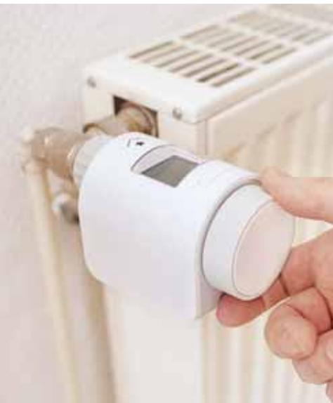
**Heizkörperregler:** Der smarte Thermostatkopf erhält seine Befehle per Funk, bleibt aber weiterhin von Hand bedienbar
