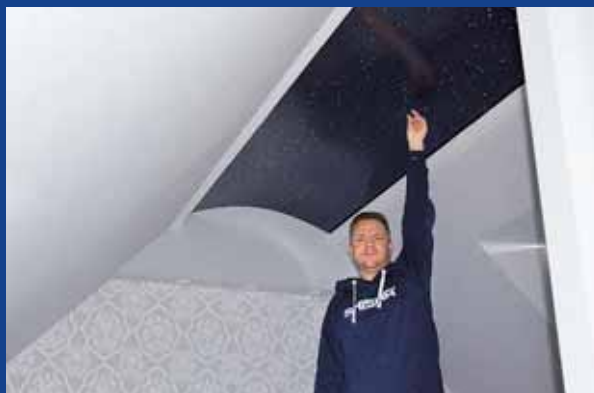
Griff nach den Sternen: Jürgen Lorenzen hat in mühevoller Kleinarbeit einen Sternenhimmel aus 800 Lichtfaserkabeln in die Deckenverkleidung des neuen Schlafzimmers gebaut.
