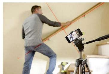
**Schräge Sache:** Das Prisma lässt sich auch arretieren, um gekippt zu werden. Mittels Displayraster auf einem Fotohandy lässt es sich z.B. für eine Handlauf-Montage an der Treppenachse ausrichten
