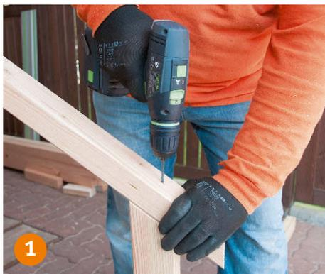
**Für die Verschraubung des Handlaufs** bohren Sie die Löcher vor. Achten Sie dabei auf eine senkrechte Ausrichtung der Bohrspitze.
