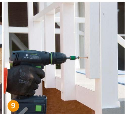
**9** **An der Rückseite der Pfosten** bringen Sie den Seitenrahmen in der gewünschten Höhe mit Holzschrauben an.
