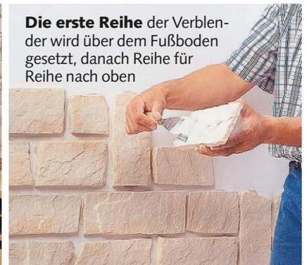
Die erste Reihe der Verblender wird über dem Fußboden gesetzt, danach Reihe für Reihe nach oben
