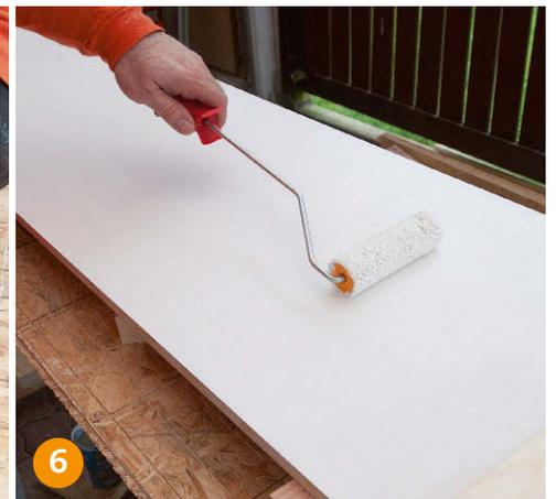
**6** **Vor dem Auftragen** des Isoliergrundes verspachteln Sie die entstandenen Schraublöcher und schleifen nach dem Trocknen die Platte.
