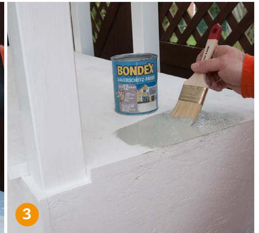
**3** **Eine Dauerschutz-Farbe** im gewünschten Ton bildet einen deckenden und strapazierfähigen Film auf der Grundierung.
