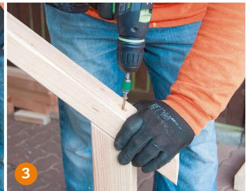
**Mittels Holzschrauben** befestigen Sie den Handlauf mit dem Akku-Bohrschrauber auf den Pfosten und versenken die Schraubenköpfe.
