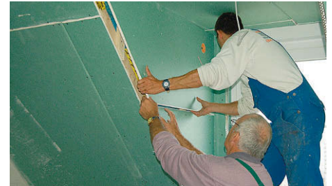
Fotos: BCBau, Christian Bordes, Hersteller
