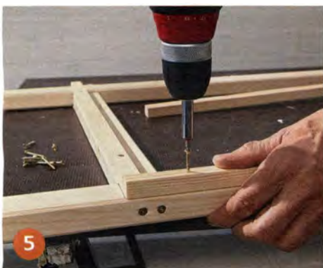
Auf den Grundrahmen einen feineren Außenrahmen setzen, damit die Matten dort hinein eingelassen werden können.
