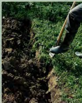
Schritt 2: Für den zweiten Stich setzen Sie das Spatenblatt neben dem ersten Einstich parallel zur Rasenfläche an. Stellen Sie einen Fuß auf die obere Blattkante.
