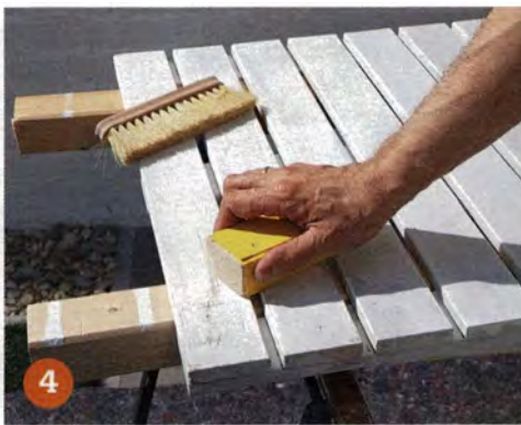
4 Die Grundierung ebenfalls mit 180er Körnung anschleifen und mit einer Bürste sorgfältig den Schleifstaub entfernen.
