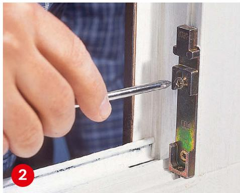
**Schrauben Sie** Metallbeschläge nach Möglichkeit aus dem Fensterrahmen heraus, damit sie nicht mit Farbe verschmiert werden.
