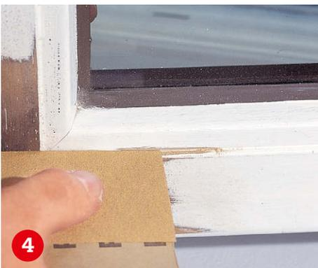
**Schmale Kanten** und Innenecken werden per Hand geschliffen. Achten Sie darauf, dass die Glasversiegelung nicht verletzt wird.
