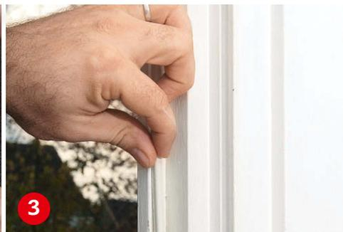
**Setzen Sie in einer Ecke** an und pressen Sie die Dichtung bis zur nächsten Ecke. Dort etwas länger abschneiden und genau ins Eck einpassen.
