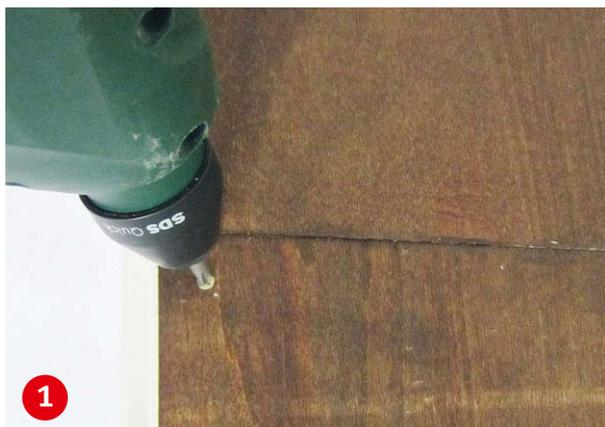
**Befestigen Sie** die auf das Regalmaß zugeschnittenen und anschließend im Farbton Nussholz lasierten Sperrholzplatten (DIN A2 Format) mit jeweils acht Schrauben.
