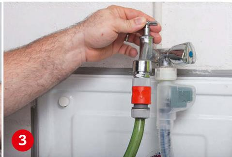
**3** Das andere Schlauchende verbinden Sie mit dem Wasserhahn. Öffnen Sie langsam Ventil und Hahn, bis der schwarze unter dem roten Zeiger ist.
