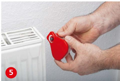
**5** Setzen Sie einen Entlüftungsschlüssel an das Entlüftungsventil. Mit einem Behälter fangen Sie austretendes Heizungswasser auf. Tipp: Lappen!
