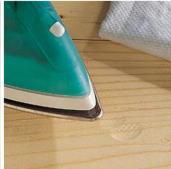
**Kleine Druckstellen** beseitigen Sie mit heißem Wasserdampf oder alternativ handwarmem Holzwachs.
