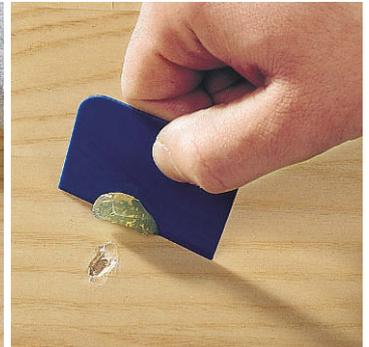
**Größere Vertiefungen** lassen sich mit Reparaturharzen füllen. Diese tragen Sie mit einem Spachtel auf.
