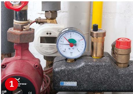
**1** Bei zu niedrigem Wasserdruck (schwarzer Zeiger) kann die Umwälzpumpe der Heizungsanlage nicht mehr richtig arbeiten.
