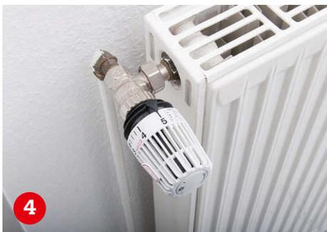
**4** Vor dem Entlüften der Heizkörper stellen Sie die Umwälzpumpe für eine Stunde ab. Dann drehen Sie das Thermostat auf Maximum.
