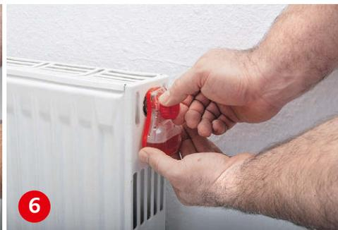
**6** Drehen Sie den Schlüssel langsam, bis die heiße Luft zischend entweicht. Kommt ein konstanter Wasserstrahl, schließen Sie das Ventil.
