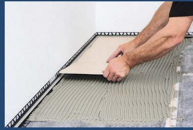
Mit einem **Flexkleber** und einer 4er-Zahnung wird zunächst die Entkopplungsmatte auf dem Estrich verklebt und fest angedrückt.
