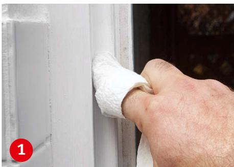
**Nach dem Entfernen** alter Isolierbänder mit dem Spachtel befreien Sie das Holz mit Lappen und Spiritus von Kleberückständen und Fetten.
