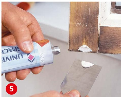
**Sprödes und weiches Holz** mit einem Beitel entfernen und die entstandenen Löcher mit Universalspachtel flächig verfüllen und glätten.
