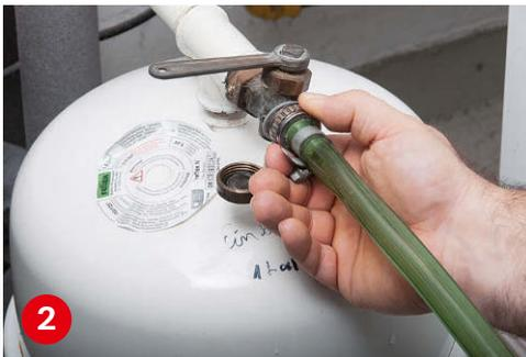
**2** Zum Nachfüllen schließen Sie einen Schlauch an das geschlossene Ventil des Heizwasserkessels an. Befüllen Sie ihn mit Wasser.
