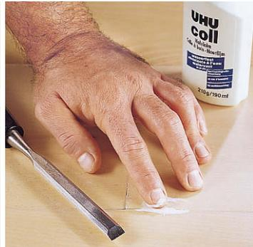
**Abgesplittertes Holz:** Splitter mit Stechbeitel anhebeln, wasserfesten Holzleim verteilen und andrücken.
