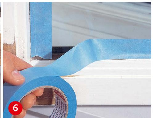
**Glasscheiben und Dichtungen** mit einem speziellen Kleband für Fenster (Outdoor) gegen unbeabsichtigte Pinselstriche schützen.
