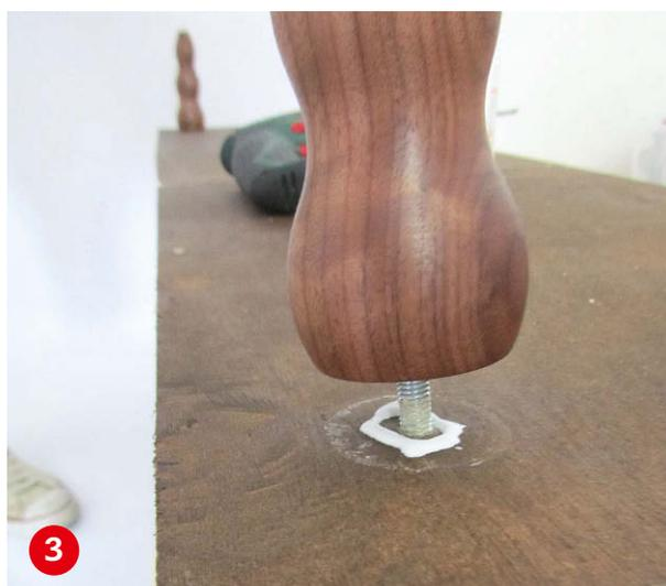
**Die Möbelfüße** mit dem Gewinde in die vorgebohrten Löcher stecken und den Leim austrocknen lassen. Dann das Sideboard wieder umdrehen und auf die neuen Füße stellen.
