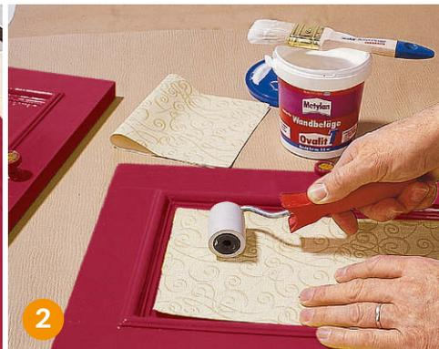
**... bevor Sie sie zuschneiden.** Nach dem Weichen drücken Sie das Tapetenstück mit einer Gummivalze blasenfrei auf der Türfüllung an.
