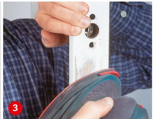
**Die breiten Flächen** der Rahmen- und Flügelkanten schleifen Sie am besten mit einem Deltaschleifer und 180er Schleifpapier ab.
