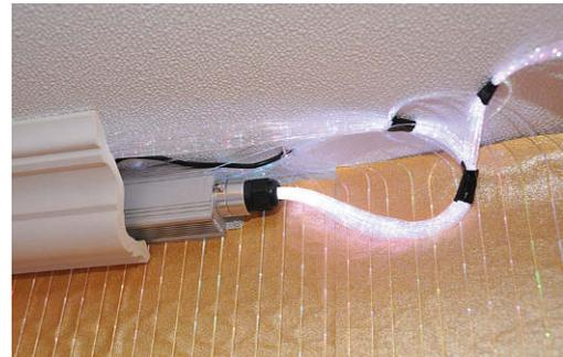
Die Lichtquelle wird mit den gebündelten, dünnen Kunststofffasern verbunden und abschließend durch eine Stuckleiste abgedeckt.
