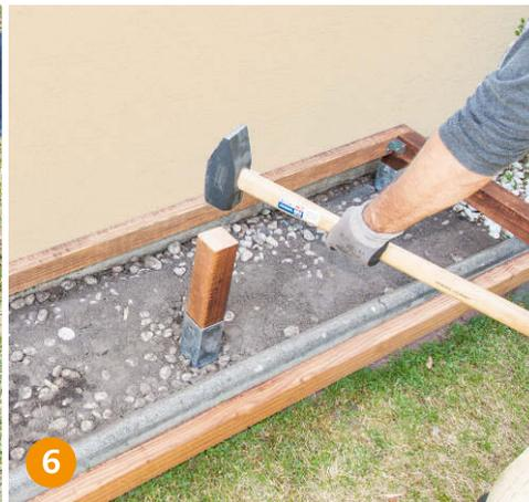
**Mittig zum Rahmen** setzen Sie noch einen Pfosten, um das spätere Gewicht zusätzlich abzufangen.
