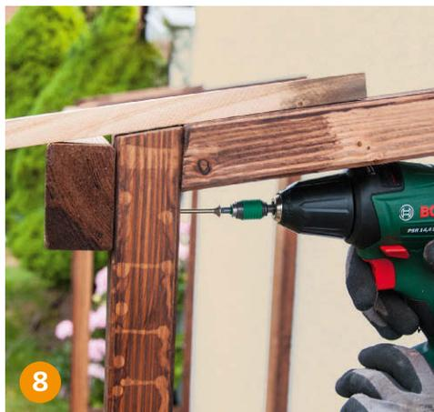
**8** **Die Stirnseite** wird mit einem Kantholz verschraubt. Ein weiteres Kantholz wird an der Wand eingepasst und mit Winkeln verschraubt.
