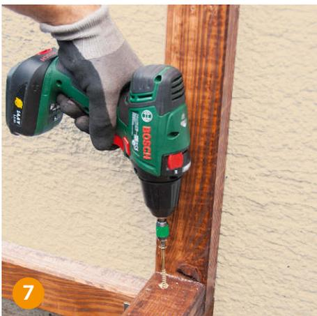
**7** **Anschließend** verschrauben Sie den Seitenrahmen mit dem Grundrahmen. Dies schafft Stabilität.
