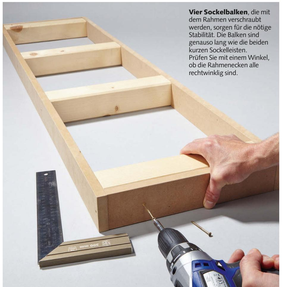
**Vier Sockelbalken**, die mit dem Rahmen verschraubt werden, sorgen für die nötige Stabilität. Die Balken sind genauso lang wie die beiden kurzen Sockelleisten. Prüfen Sie mit einem Winkel, ob die Rahmenecken alle rechtwinklig sind.
