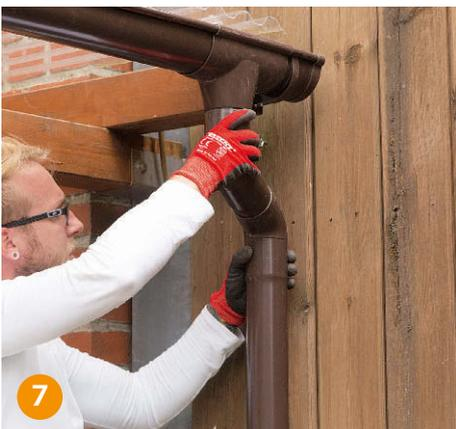
**7** Die angepassten Rinnenbögen können Sie nun zusammen mit dem Fallrohr an den Einhangstutzen montieren und ausrichten.
