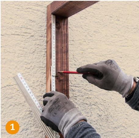
**1** **Markieren** Sie den Befestigungspunkt. Verschraubt man den Seitenrahmen mit einer Wand, reichen drei geeignete Schrauben aus.
