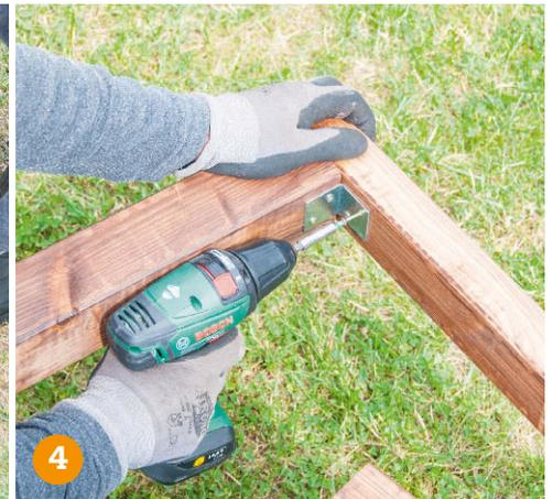
**Verschrauben** Sie den Rahmen mit Winkelverbindern. Diese bieten unserer Konstruktion zusätzliche Stabilität.
