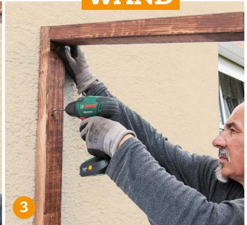
**3** **Mit einem Holz- oder HSS-Bohrer** bohren Sie den Rahmen für die Schraube vor. Jetzt können Sie die dahinter liegende Wand markieren.
