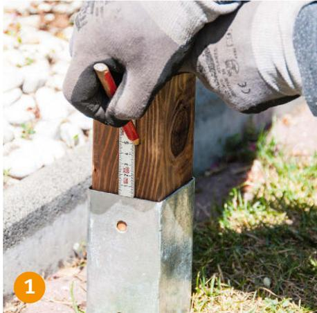
**Als Auflage** für den Grundrahmen dienen passende Balken. Diese müssen nun auf die gewünschte Länge gebracht werden.
