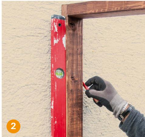
**2** **Achten Sie darauf**, dass der Rahmen vertikal steht. Dies überprüfen Sie mit einer Wasserwaage und reißen den Stand an der Wand an.
