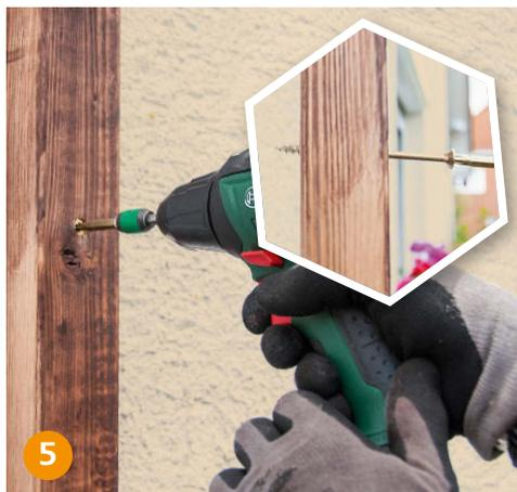
**5** **Die Schraube** drehen Sie ein kleines Stück durch das Holz. So ist es leichter, die Dübel in der dahinterliegenden Wand zu treffen.
