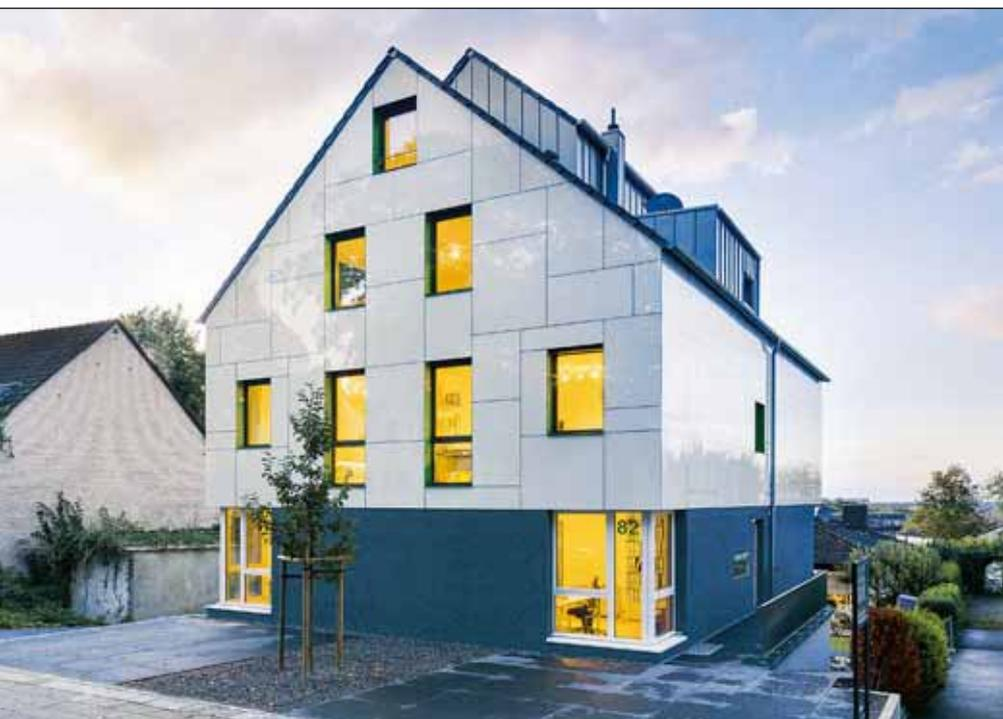
Dämmung mit Glasoberfläche
