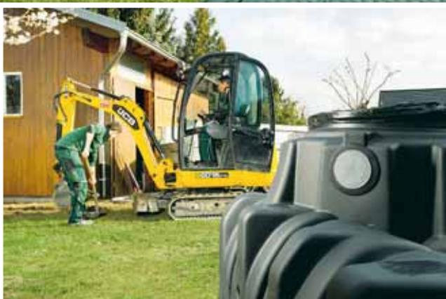
**Mit einem Mini-Bagger** heben Selber Machen und Graf die Grube für den Tank aus. Den übrig bleibenden Aushub können Sie zum Beispiel für eine Natursteinmauer wie oben nutzen
