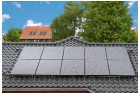
**Hybridmodule:** Die „2Power“-Module von Nelskamp – hier klassisch auf Schienen montiert – erzeugen gleichzeitig Strom und Wärme.
