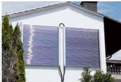
**Vakuum-Röhrenkollektoren** (hier von AkoTec) sind teurer als die flachen, bringen aber höhere Erträge. Eine Option für kleinere Flächen.
