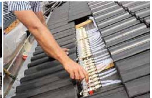
**Fast unsichtbar:** Die Alu-Dachpfannenkollektoren „SolarPowerPack“ von Nelskamp leiten die Sonnenwärme in den Warmwasserspeicher.
