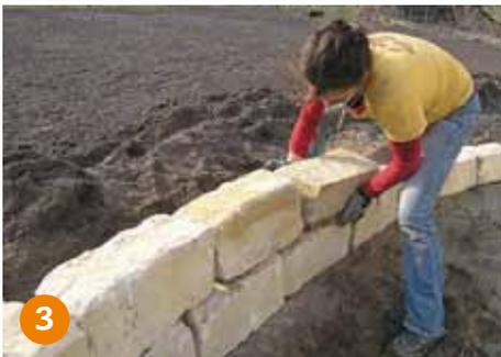
**Die zweite Schicht** der Steine beginnt mit einem halben Stein. Das bedeutet also, die Steine werden so geschichtet, dass keine Kreuzfugen entstehen. Zuletzt wird das Erdreich rückseitig angeschüttet, leicht verdichtet und die Mauerfugen von oben mit Pflanzen versehen. Fertig ist die mediterrane Mauer aus Sandstein-Quadern. In Summe sollten Sie sich für das Bauvorhaben mindestens zwei bis drei Wochenenden frei halten.
