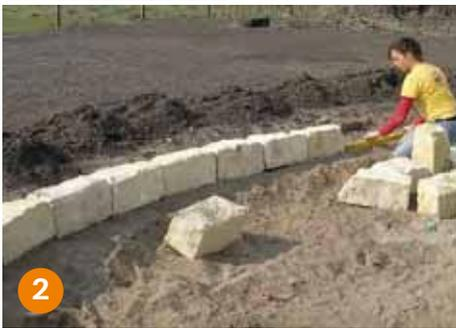
**Bei längeren Mauerabschnitten** oder wenn die Mauer sich durch den Garten schlängeln soll, ist eine stetige Kontrolle der waagerechten Ausrichtung wichtig. Lassen Sie sich genügend Zeit für die Ausrichtung der ersten Schicht und planen Sie den Mauerverlauf vor Baubeginn möglichst genau. Denn ist die erste Reihe erst mal gelegt, haben Sie bei der zweiten keine einfache Regulierungsmöglichkeiten mehr. Vorbereitung ist bei diesem Projekt die halbe Miete.
