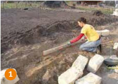
**Für den Unterbau** muss die Erde abgetragen und Verlegesand mit einer ungefähren Körnung von 0 bis 4 mm eingebracht werden. Dieser Unterbau sollte etwa 20 cm tief angelegt und mit einem schweren Handstampfer ordentlich verdichtet sein. Bevor die erste Steinschicht angesetzt wird, muss der lose Sandunterbau waagrecht ausgerichtet werden. Erst wenn der Sand gerade liegt, kann die erste Schicht aus den behauenen Sandsteinquadern verlegt werden.
