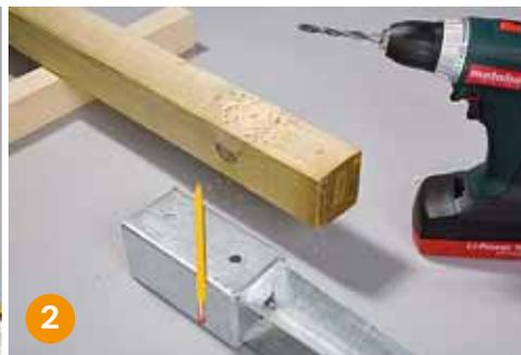
**Einschlaghülsen** über unteres Pfostenende führen, Bohrlöcher markieren und 2 mm größer als der Bolzendurchmesser misst vorbohren.
