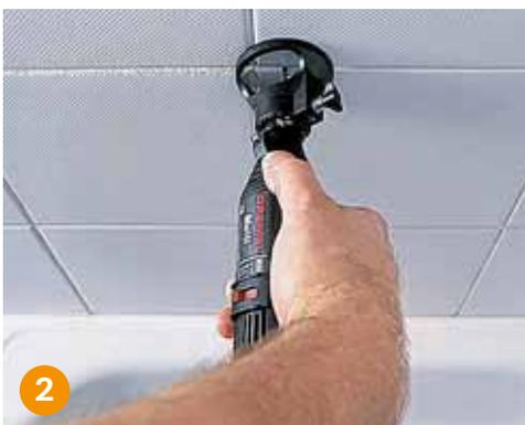
**Einfacher** geht es mit einem kleinen Elektrofräser oder einem Multitool. Hier gilt: genau arbeiten, sonst werden Fliesen zerstört.
