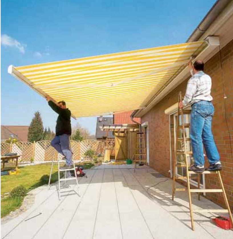
**Je größer die Markise**, desto schwerer wird sie auch. Nicht jede Wand ist gleich gut zur stabilen Befestigung des Sonnenschutzes geeignet
