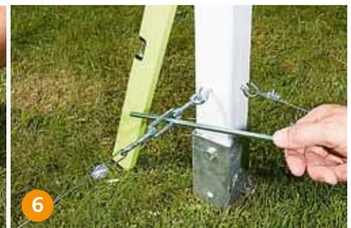
**Alle Drahtseile einhängen** und mit dem Seilspanner auf Spannung drehen. Achten Sie dabei auf das Lot.
