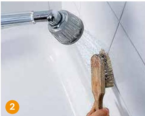
**Nach einigen Minuten** wird mit Wasser und Bürste abgewaschen. Wenn nach mehrmaligem Anwenden der Schmutz bleibt: Sanieren!
