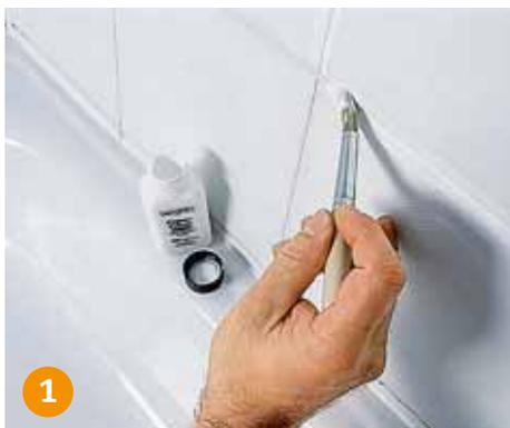
**Mit einem Pinsel** die Fugenfarbe auftragen und etwa eine Stunde trocknen lassen. Wichtig: Der Untergrund muss porös sein.
