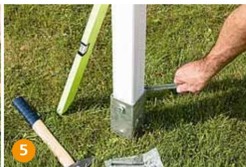
**Stellen Sie die Pfosten** in die Einschlaghülsen und sichern Sie diese unbedingt mit beiden (!) Bolzen, sonst halten sie Wind nicht stand.
