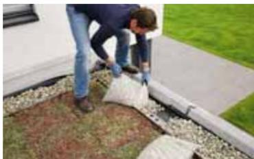
Zur Dachbegrünung gehört auch Wurzelschutzfolie. Kiesfangleisten trennen Pflanzen exakt vom Kies
