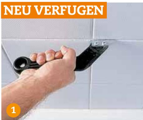
**Neu verfugen:** Wenn keine kosmetischen Mittel mehr helfen, werden kleine Bereiche im ersten Schritt mit einer Fugenraspel vertieft.
