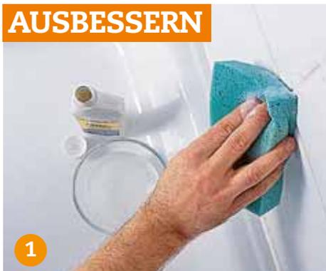
**Spezielle Fugenreiniger** werden mit einem Sprüher oder mit dem Schwamm aufgetragen. Achtung: Einige Reiniger greifen Wandfarbe an.
