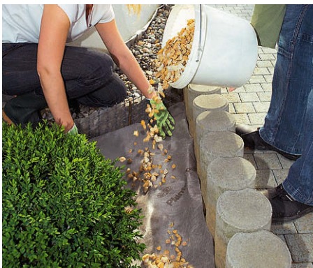
Unkrautvlies (Gutta Werke), versteckt unter Kies, hält unerwünschte Pflanzen in Schach.
