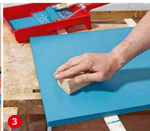
**Nach der Trocknung** (über Nacht) schleifen Sie Flächen und Kanten mit 220er-Schleifpapier und lackieren das Ganze ein zweites Mal.
