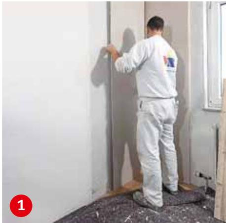
**Beginnend in einer Raumecke** werden die Platten vollflächig auf die Wände geklebt. Die Elemente sind raumhoch.
