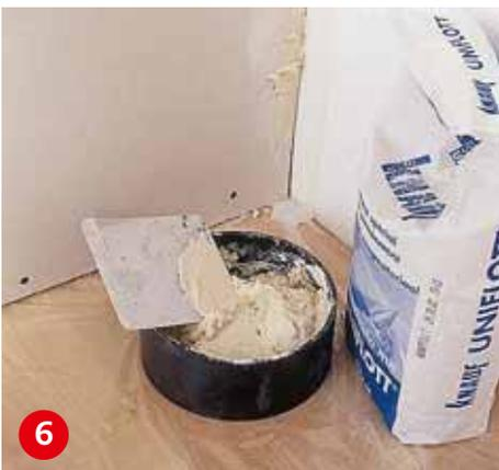
**Der Wandanschluss**, der selten perfekt ist, wird mit Spachtelmasse ausgefüllt, die sich anschließend leicht glattschleifen lässt.
