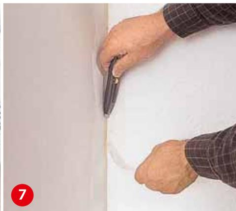
**Bevor die Spachtelmasse** durchgetrocknet ist, wird das Klebeband am Wandabschluss mit einem Cuttermesser abgeschnitten.
