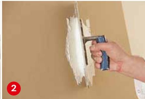
**Kalkfeinputz** ist nur wenige Millimeter dick und wird mit dem Glätter aufgezogen. Er ist mit Kalk- und Dispersionsfarben überstreichbar.
