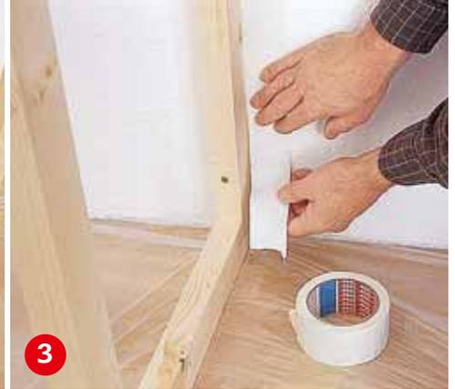
**Im Bereich des Wandanschlusses** bringen Sie an beiden Seiten ein Klebeband mit glatter Oberfläche auf, das sich leicht wieder lösen lässt.
