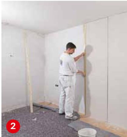
**Zwischen die Elemente** setzen Sie Federn ein, die das flächenbündige Ausrichten erheblich vereinfachen.
