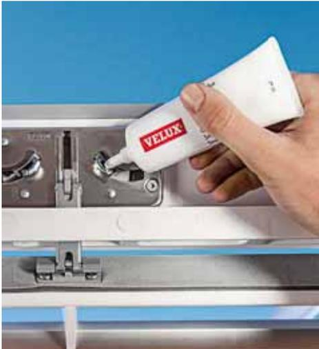
Mit dem speziellen Scharnierfett werden die Dachfenster wieder leichtgängig.
