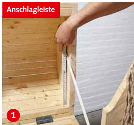
**Die Länge** für die rechte Anschlagleiste an der Endplatte des Deckels messen Sie millimetergenau aus.
