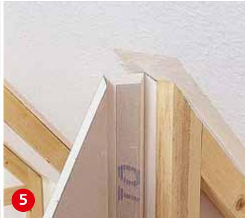
**Die V-Nut**, die in Auftragsarbeit eingefräst wird, bietet im Ergebnis eine perfekte Kante. Das erleichtert die Arbeit, da das Spachteln entfällt.
