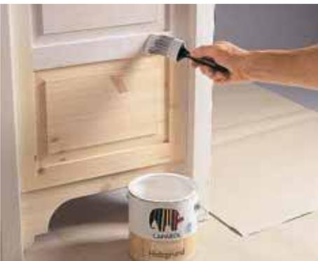
**Acryllacke auf Wasserbasis** werden mit synthetischen Borsten aufgetragen, Naturborsten sind ungeeignet, sie würden aufquellen.
