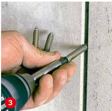
**Spezielle Schrauben** sichern die Platten zusätzlich. Sie werden nach dem Vorbohren in die Plattenfugen gesetzt.
