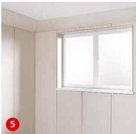
**Am Übergang** von der Wand zur Decke wird ein Dämmkeil montiert, der eine Wärmewanderung über die Decke verhindern soll.
