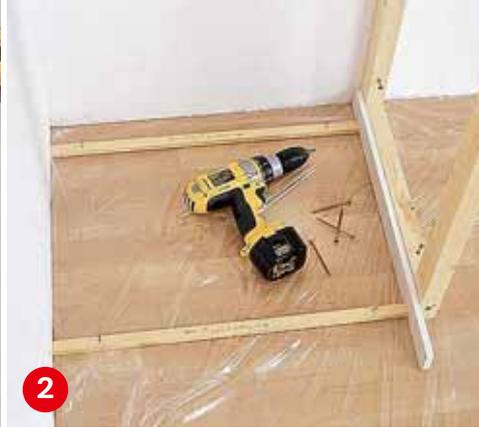
**Zu Beginn** wird der Boden mit Folie abgedeckt. Beim Aufstellen der Rahmen helfen Leisten in Bordbreite, den Abstand zu halten.
