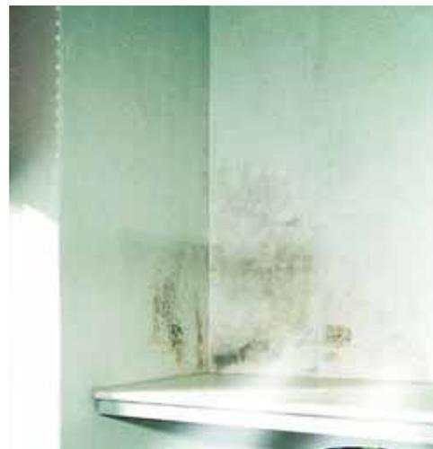
**In Raumecken** bilden sich gern Schimmelflächen, weil hier der Wärmedurchgang nach außen am größten und die Wandoberflächentemperatur am geringsten ist
