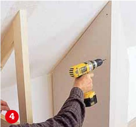
**Die vorgefrästen Gipskartonplatten** mit passenden Schrauben anbringen. Den Schraubenkopf bündig abschließen lassen.
