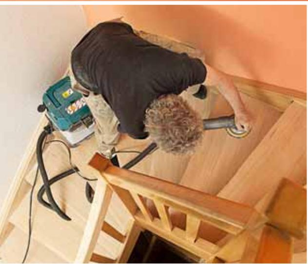
**Gründliches Abschleifen**, am besten mit einer Absaugung, ist der erste Schritt zur Treppe in neuem Glanz.
