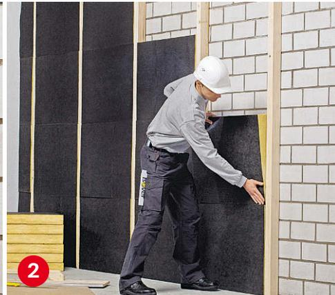
**Die Fassadendämmung** mit 1 cm Überbreite zwischen die Hölzer klemmen. Die schwarze Kaschierung ist wasserabweisend.
