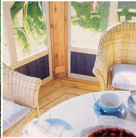
**Im Inneren** des Pavillons ist es dank der Verglasung immer hell und freundlich. Da die Bodenbretter nicht mit Nut und Feder verlegt werden, kann durch die entstehenden Fugen die Luft optimal zirkulieren
