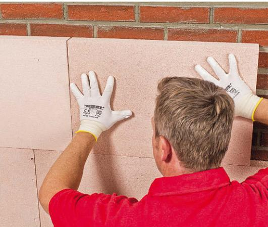
**Achten Sie** beim Ansetzen der Platten auf einen ausreichenden Fugenversatz. Die Fugen zwischen den Platten müssen dicht sein.
