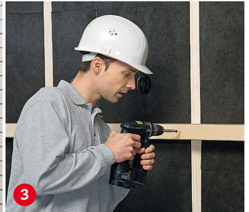
**Die Querlattung** ist für die zweite Dämmschicht gedacht. So werden durchgehende Wärmebrücken durch die Hölzer verhindert.
