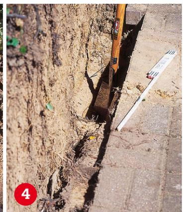
**4** Das Erdreich ausheben und zur Einbautiefe noch die Kiesschichtdicke (10–20 cm) berücksichtigen.
