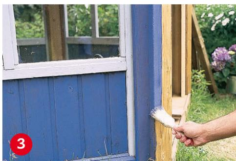
**Die bereits** imprägnierten Fensterelemente erhalten einen zweifarbigem Anstrich in Form einer Lasur. Alle Teile zweimal streichen.
