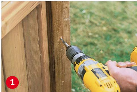
**Die äußeren Halteleisten** sind breiter als die inneren und werden ebenfalls mit Spaxschrauben an den Pfosten verschraubt.
