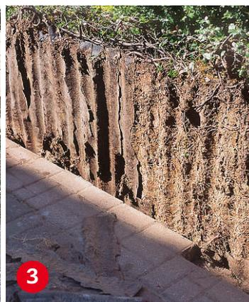
**3** Da die neuen Palisaden eine Drainage erhalten, muss der Graben vorne verbreitert werden.
