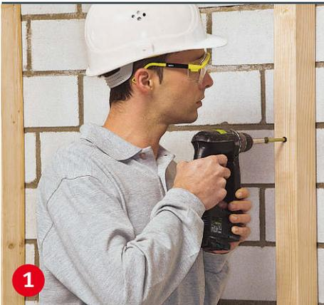
**Die Holzkonstruktion** kann direkt im Mauerwerk verdübelt werden. Die Verankerungstiefe beträgt mindestens 5 cm (ohne Putz!).
