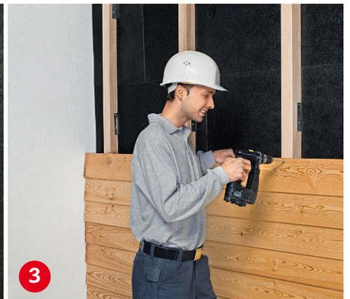
**Als Fassadenbekleidung** kommen witterungsbeständige großformatige Platten genauso in Frage wie einfache Profilhölzer.
