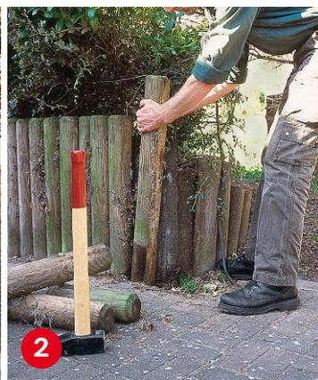
**2** Mit einem Hammer die Palisaden seitlich losschlagen und per Hand vorsichtig nach oben herausrütteln.
