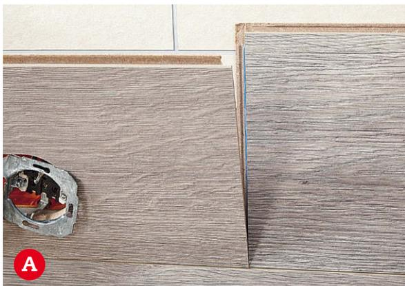
**Die Kopfseite** wird hinuntergedrückt. Dabei wird bei den meisten Herstellern eine Kunststoff-Feder (hier blau) zur Seite gedrückt und verriegelt anschließend.
