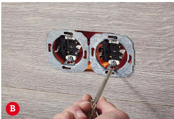
**Die Krallen** der Steckdosen können bei waagerechter Zuführung (!) die Leitungen beschädigen. In so einem Fall drehen Sie die Einsätze um 90 Grad.
