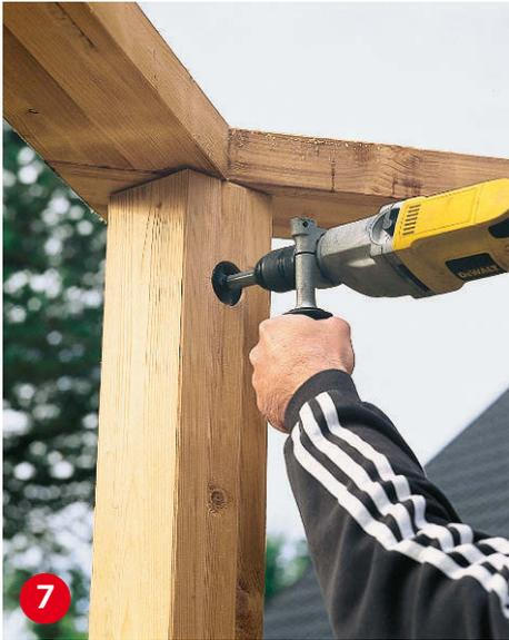
**Mit einem** 40-mm-Forstnerbohrer bohren Sie ein Sackloch in die Innenseite der Pfosten, bis Sie das zuvor gebohrte Langloch treffen.
