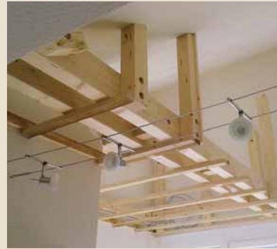
**Die Konstruktion** für die Schlafebene entstand aus Brettschichtholz
