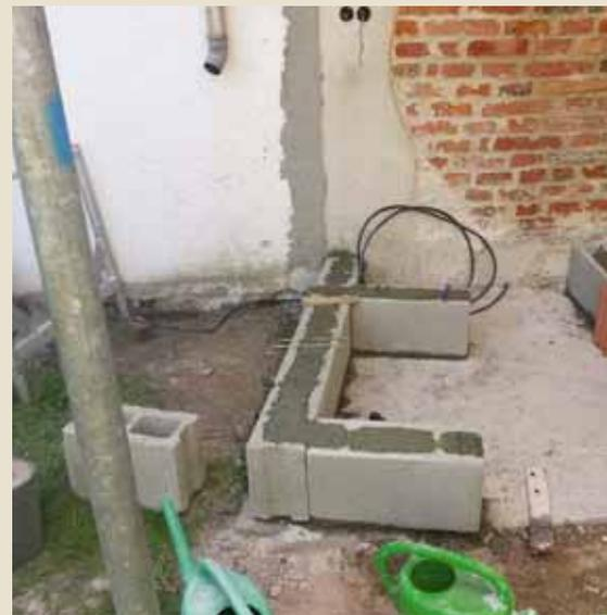
**Die Arbeitsplatten** der Küche ruhen auf gemauerten Sockeln aus Gasbetonsteinen
