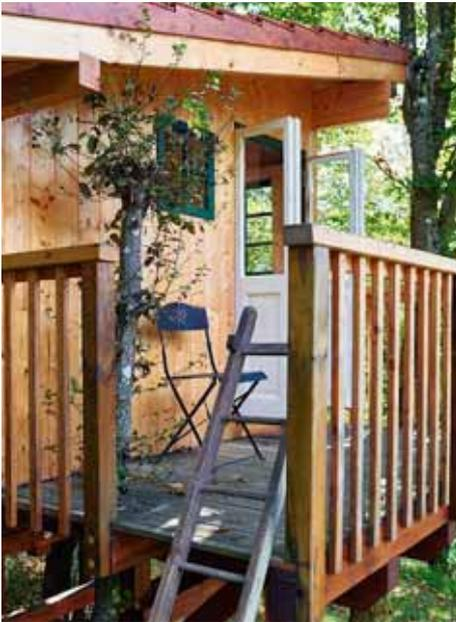
**Widerstandsfähiges** Douglasienholz wurde für den Bau der Terrasse verwendet
