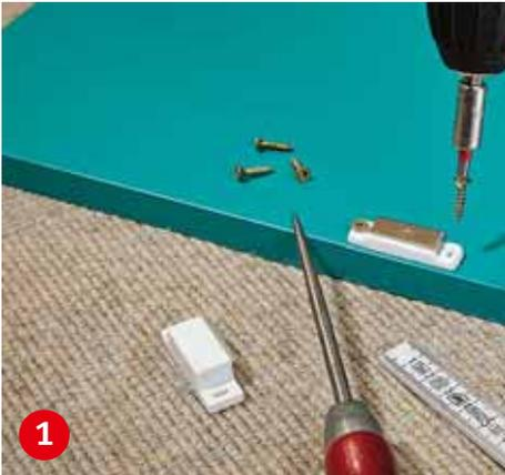
**Die Metallplatte** des zweiteiligen Magnetschnäppers verschrauben Sie an den beiden Rändern der Klappenschraubenlöcher.
