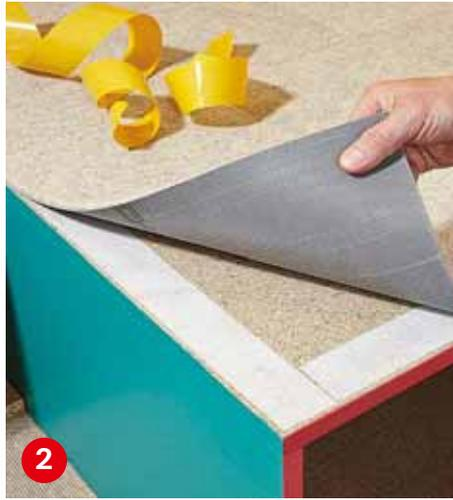
**Nach dem Abziehen der Schutzfolie** drücken Sie die Teppichfliesen auf die Klebänder. Fliese genau ausrichten.
