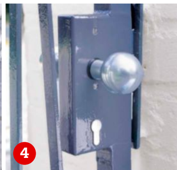
Blende. Das niedrige Tor erhielt nur ein Blindschloss. Anschließend folgt Rostschutz und Lack für alle Flächen.
