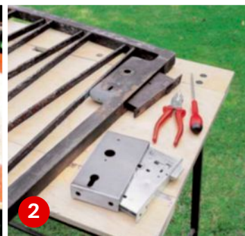
Schlossruine. Der alte Schlosskasten wird mit dem Winkelschleifer herausgeschnitten. Der neue ...
