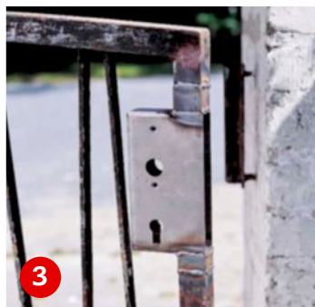
... wird vom Schlosser mit Passstücken in den Rahmen der alten Pforte eingeschweißt.
