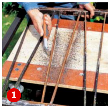
Altlast. Mit dem Farbschaber wird (ziehend!) Rost und alte Farbe von den Flächen gelöst.
