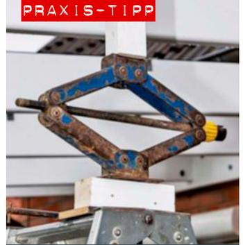
**Helfende Hand** Beim Ausrichten ist ein Wagenheber auf einer Leiter sehr hilfreich. Nun alle Schrauben festziehen.
