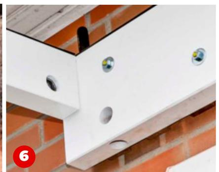
**Sparren ansetzen.** Zu zweit heben Sie den ersten, äußeren Dachsparren an den Hausträger und stecken ihn auf die Schraube dort. Mutter handfest anziehen. Kleiner Trick: Hinten einen Schraubendreher einstecken: sichert die Schraube gegen Verrutschen. Sparren muss bündig sitzen.
