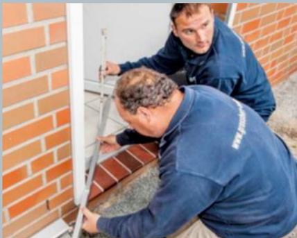
**Übergang vermessen.** Mit Zollstock und Wasserwaage übertragen Sie das bestehende Fußboden-Niveau im Haus auf die Außenwand.
