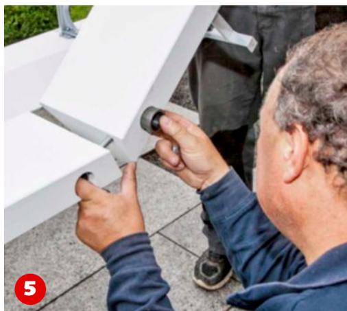
**Winkel verbinden.** Der schräge Abschnitt der Traufe wird mit runden Daderukdübeln und Schrauben angesetzt und festgezogen.
