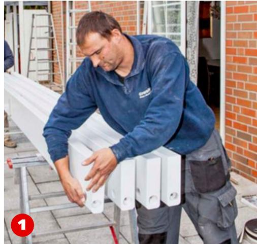
**Sparren ausrichten.** Legen Sie sich alle Dachsparren zurecht, die Unterseite erkennen Sie an den abgerundeten Kanten. Randsparren nach außen, alles mit einem Winkel ausrichten.
