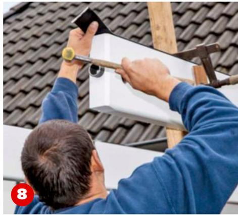
**8 Sparren ausrichten.** Unterleghölzer schützen vor Klemmspuren. Zwingen gut festziehen, damit die Latten nicht wegknicken. Dann werden an der Stirnseite der Sparren die Daderuks mit einem Kunststoffhammer eingeschlagen. Hier werden dann die Traufbalken montiert.
