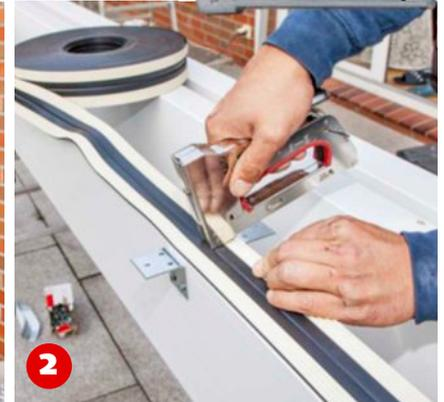
**Kantenverbinder aufsetzen.** Maße (aus der Aufbauskizze) für die Winkelstücke anzeichnen. Mit Spax anschrauben. Dichtband auftackern. Auf die Oberseite der Dachsparren wird das Dichtband montiert. An der Kanten zur Traufe (außen) wieder 15 cm überstehen lassen.
