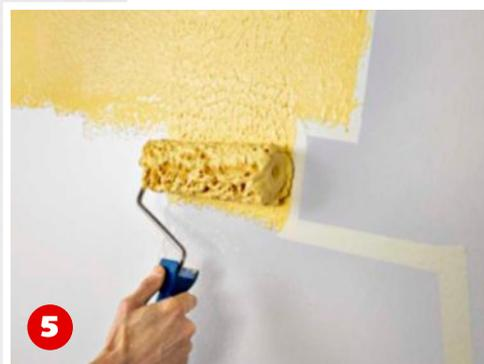
**5** Die ausgezackte Linie zwischen der grauen Wand und der Putzfläche mit Malerkrepp abkleben, wenn die Wandfarbe getrocknet ist. Dann wird der Easyputz aufgetragen.
