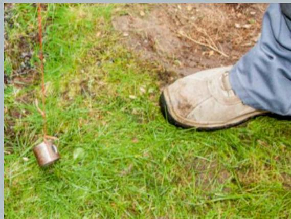
**Stützpunkte finden.** Überall, wo zwei Elemente zusammenstoßen, muss ein Fundamentpfiler gesetzt werden. Diese Punkte markieren.
