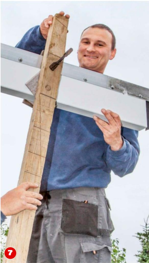
**7 Latte anklemmen.** Mit einer Dachlatte plus Schraubzwinde wird der Dachsparren fixiert und gesichert. Übrige Sparren ebenso anbringen.
