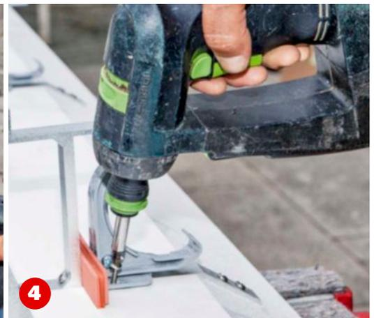
**Traufen vorbereiten.** An die vorn quer verlaufenden Traufen (abgeschrägte Balken) werden die Dachrinnenträger angebracht. Gefällerrichtung beachten!
