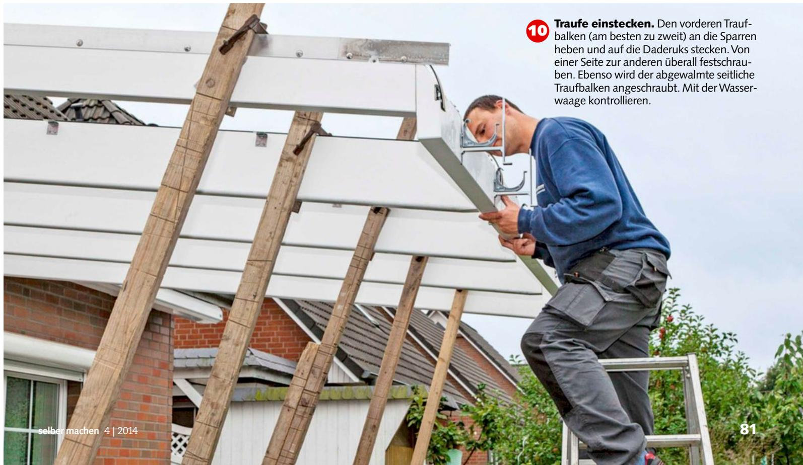
**10 Traufe einstecken.** Den vorderen Traufbalken (am besten zu zweit) an die Sparren heben und auf die Daderuks stecken. Von einer Seite zur anderen überall festschrauben. Ebenso wird der abgewalzte seitliche Traufbalken angeschraubt. Mit der Wasserwaage kontrollieren.
