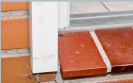
**Maß aller Dinge.** Zeichnen Sie diesen Wert „Oberkante fertiger Fußboden“, kurz OKFF an – Referenz für alle weiteren Markierungen.
